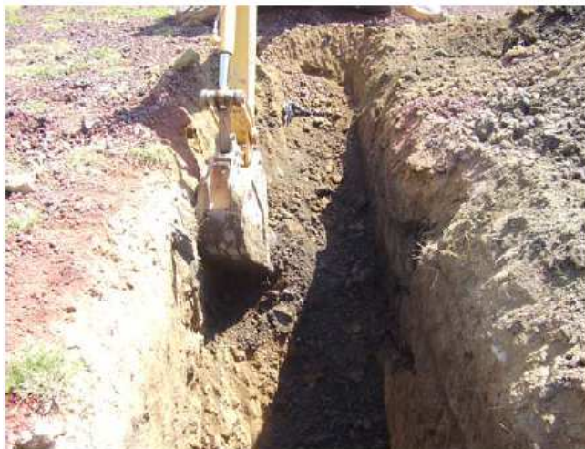
Figura 4.18.- Excavación de pozos a cielo abierto.
