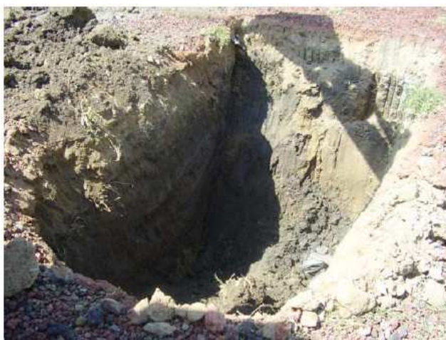
Figura 4.19.- Excavación de pozos a cielo abierto.
