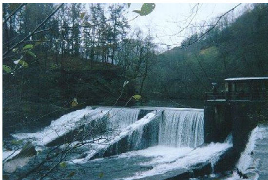
Figura I.1. Central minihidroeléctrica de “agua fluyente”
