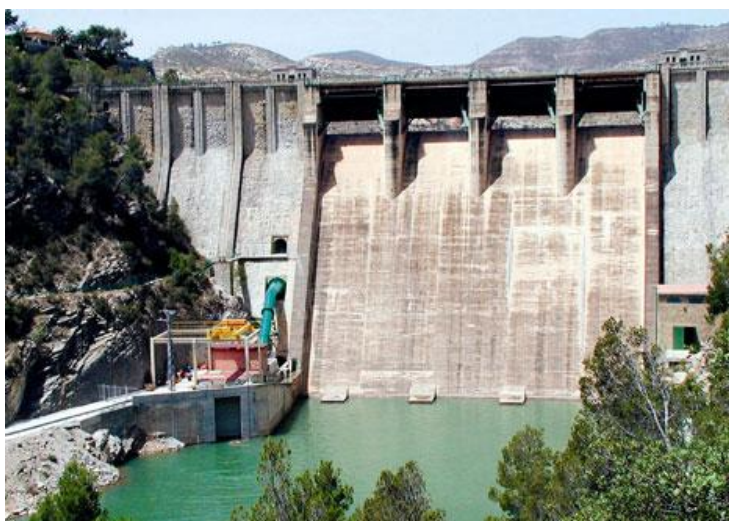
Figura I.2 Central minihidroeléctrica de “pie de presa”
