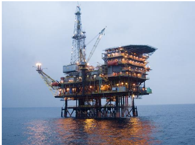
Figura 2.2.10 Plataforma de Perforación Recuperado de: http://www.michellerivera.com.mx
