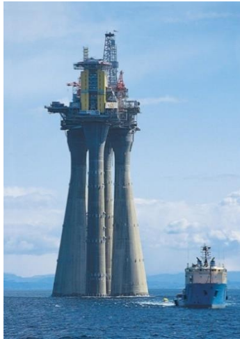
Figura 2.2.3 Plataforma de Gravedad Troll-A Recuperado de: http://ingenieriaycomputacion.blogspot.mx
