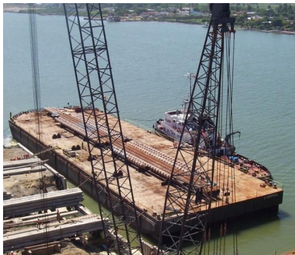
Figura 2.6.4 Pilotes sobre Barcaza
