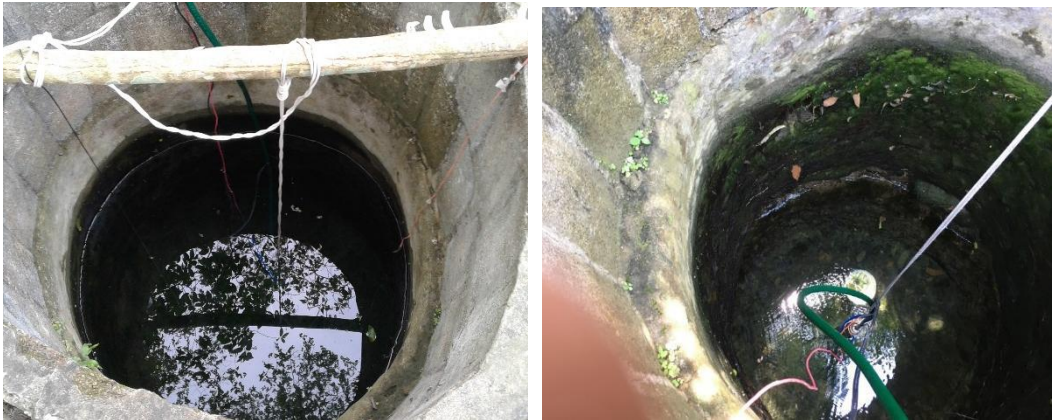
Fig. IV. 12 Realización de la prueba de bombeo en Noria N°4, se observa el vaciado de la estructura
