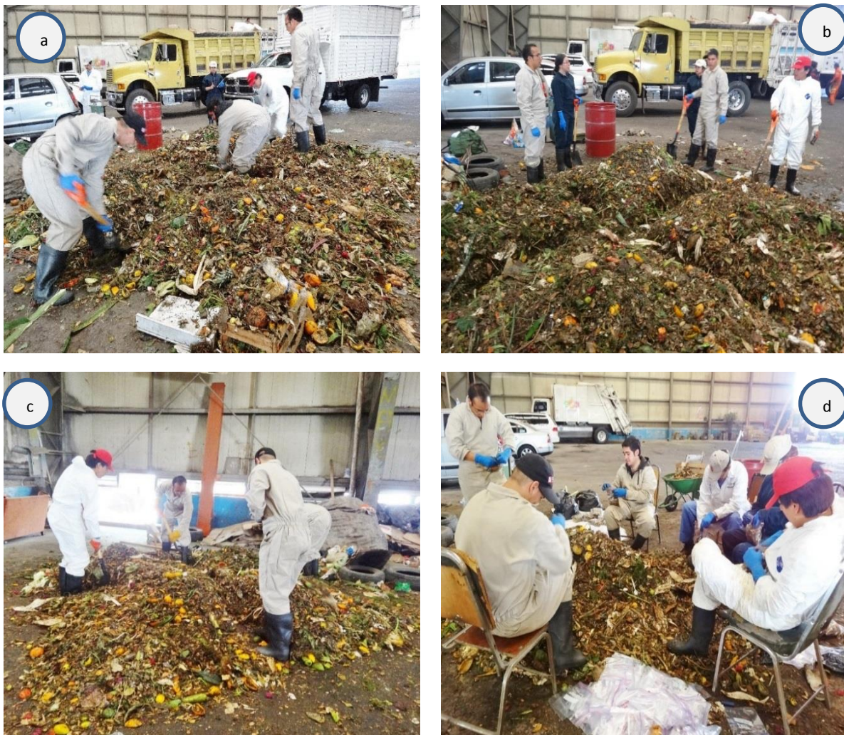
Figura. 6.1. Etapas del proceso de muestreo de residuos en la estación de transferencia Coyoacán, CDMX.
