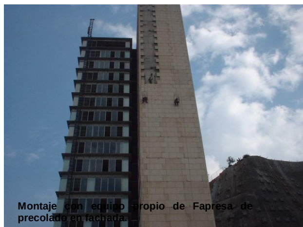
Montaje con equipo propio de Fapresa de precolado en fachada.
