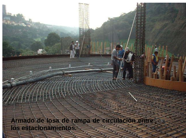
Losa de N-7.40 (motor Lobby). Zona de habilitado de acero para dados y columnas de estacionamiento de Torre "B", columnas, losa y traveses de Torre "A".
