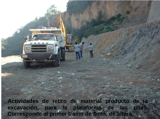
Afine con maquinaria pesada de la Plataforma de desplante de pilas.
