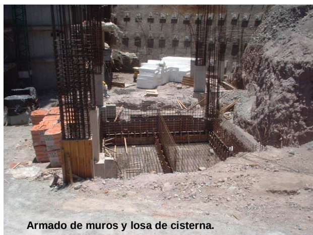
Losas de estacionamientos N-11.00 y N-7.40 (motor Lobby). Habilitado de acero en dados y columnas de estacionamiento de Torre "B".
