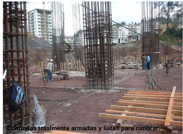
Habilitado de Acero en columnas de N-14.60 hacia N-11.00.
