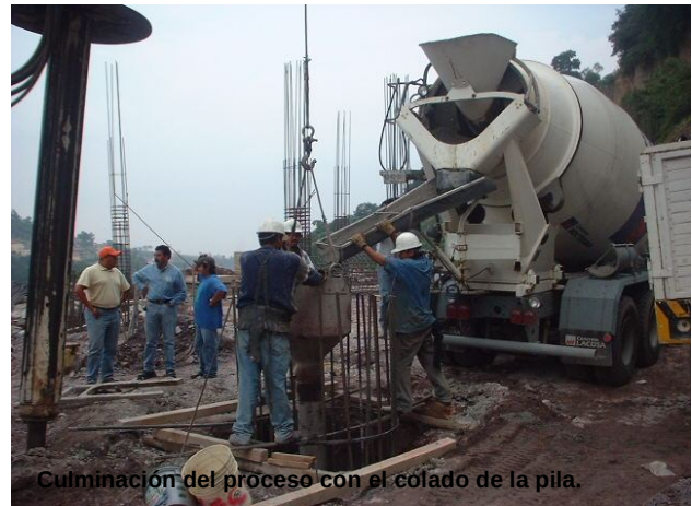
Acero colocado y tubo tremie en posición para el colado de pila.
