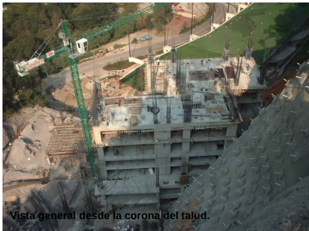
Vista general del frente de la torre “A”, en donde apreciamos claramente la estructuración a base de columnas, traves postensadas, y losa postensadas.
