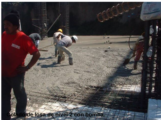
Colocación de casetón de poliestireno para el colado de la losa del N-7.40, así como de malla electrosoldada para el firme de compresión.
