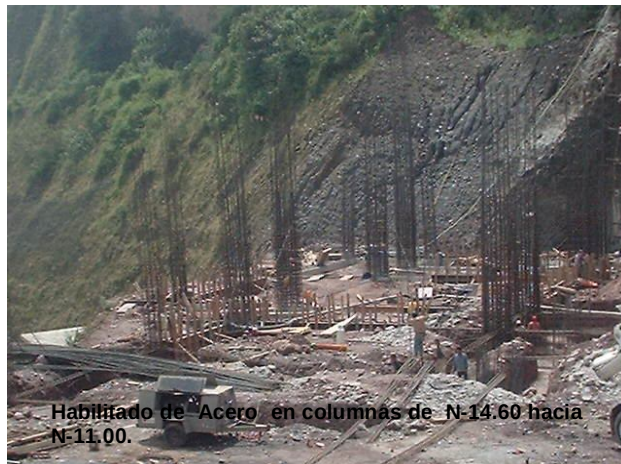
Columnas totalmente armadas y listas para cimbrar.
