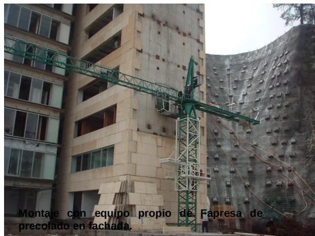
Vista lateral, avance de precolados en fachada, así como estructura.
