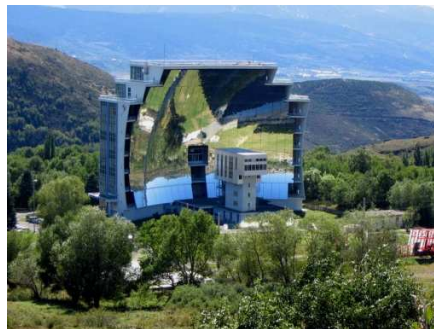
Figura 4.2. Colector solar de concentración
