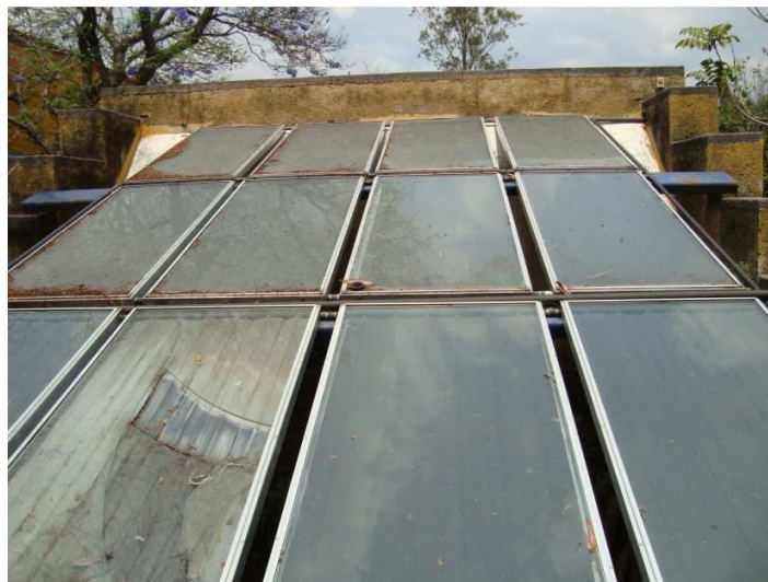
Figura 4.5. Sistema utilizado para calentamiento de alberca.
