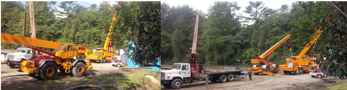
Figura 25. Grúas utilizadas para la descarga y armado de los componentes de la draga.
