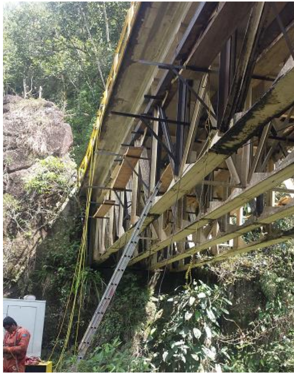
Figura 24. Reforzamiento del puente la Soledad.
