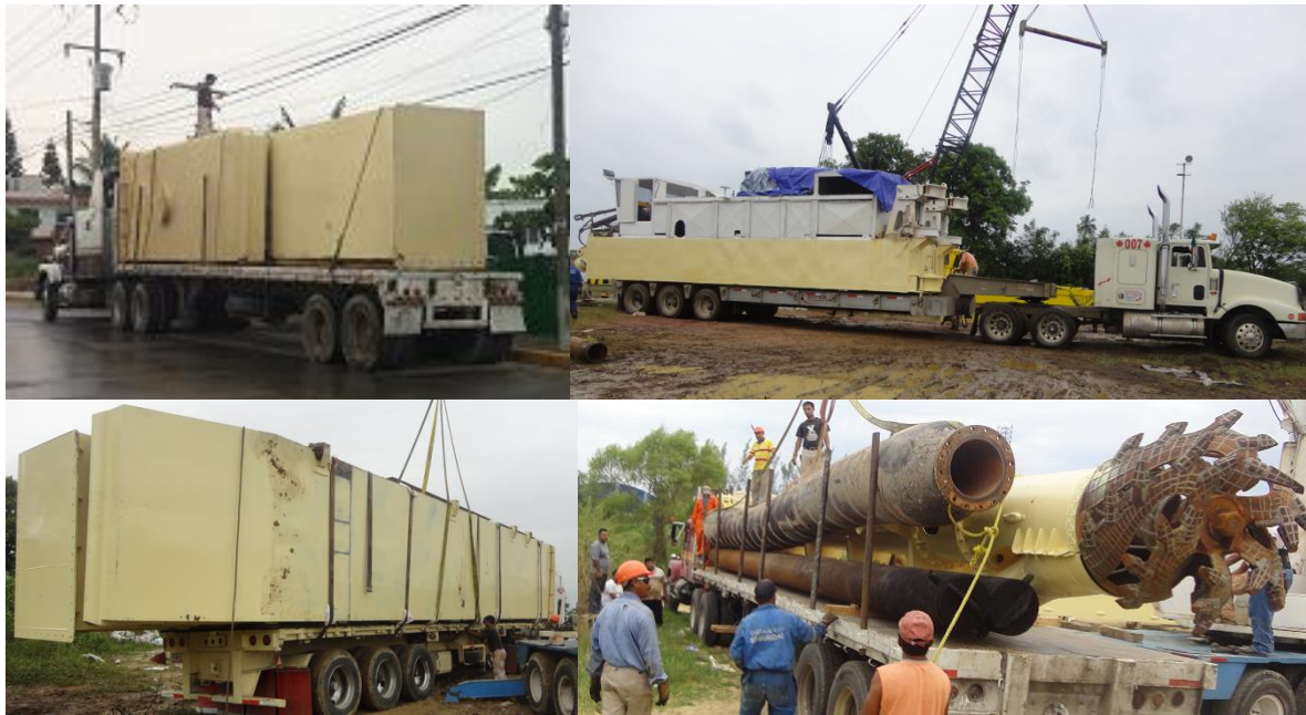
Figura 23. Desarmado de draga y colocación en vehículos para su traslado.
