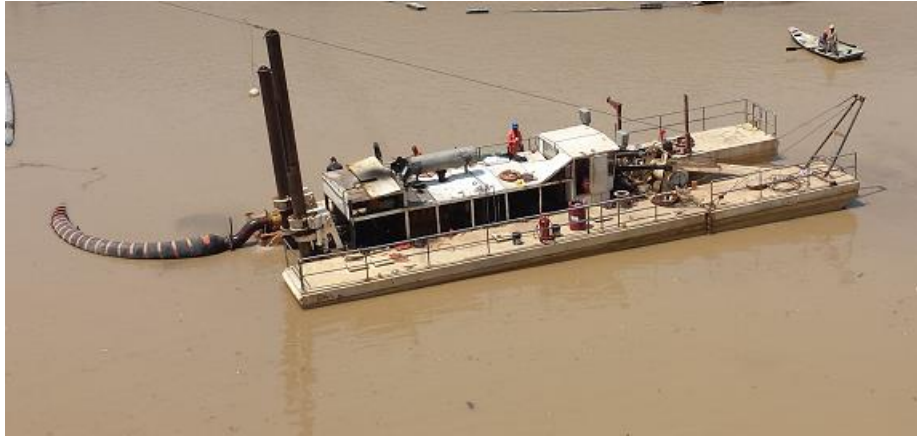
Figura 28. Draga lista para realizar trabajos de dragado.
