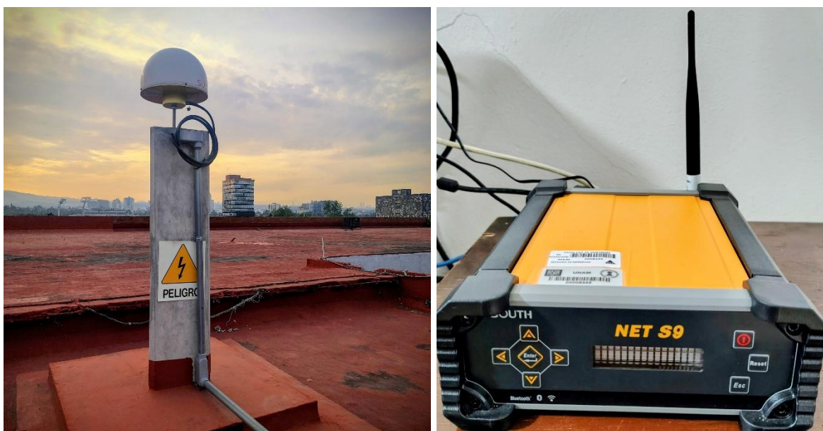
Imagen 1. Estación de Referencia de Operación Continua de la Facultad de Ingeniería de la UNAM.
