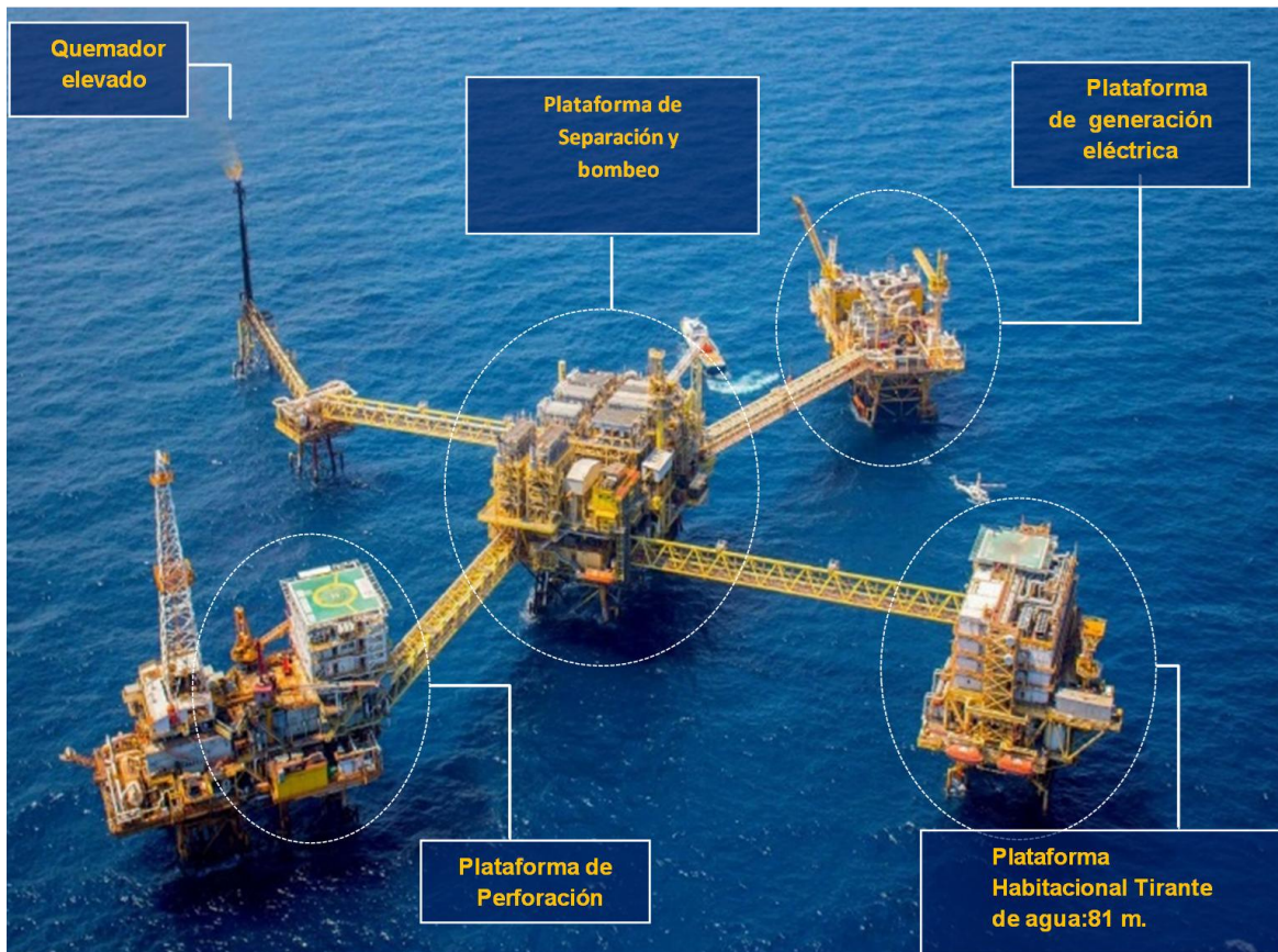
Figura 2. Centro de proceso costa afuera y sus 4 plataformas. Tomada de Contexto operacional de un centro de proceso costa afuera (PEMEX, 2024)
