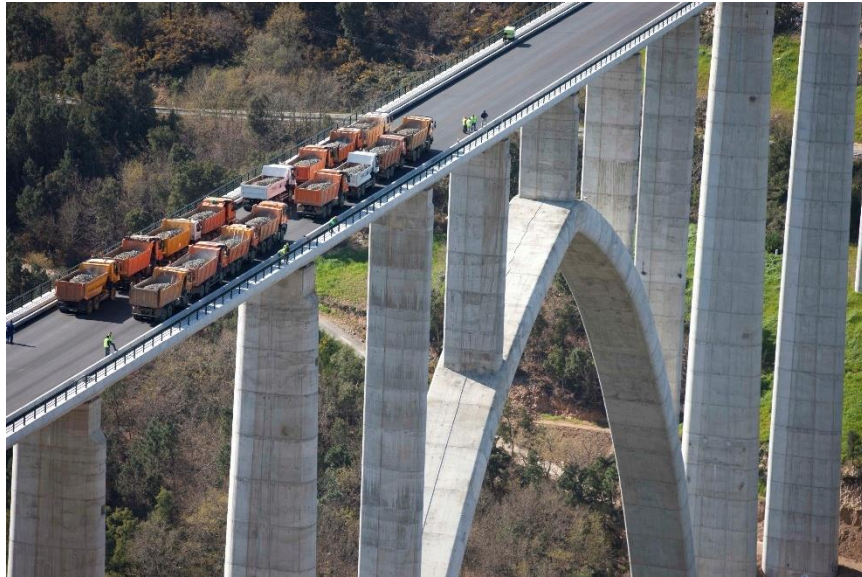
Figura 1.4 Prueba de carga en el viaducto sobre el Río Ulla, 23 de marzo de 2011. (flickr, 2011)
