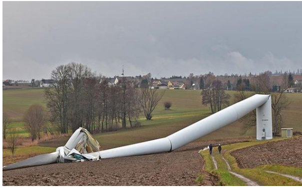
Figura 3-3. Colapso por pandeo de una torre de aerogenerador en Alemania, 2017 (Capaldo et al. , 2020).
