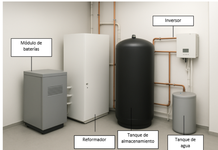
Figura 11: Elementos de un micro-CHP.
