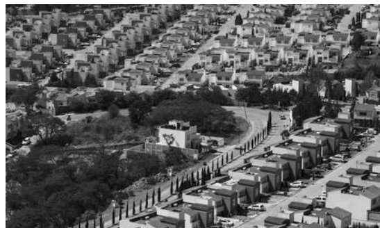
Imagen 22. [Vivienda de la mano de obra foránea]. Tomada de Saint Gobain (s.f.)
