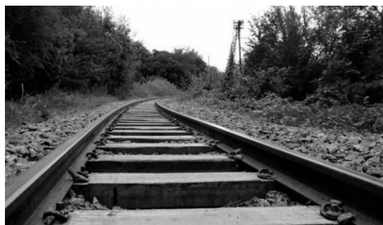
Imagen 6. [Vía férrea rehabilitada]. Tomada de Redacción T21 (2023)
