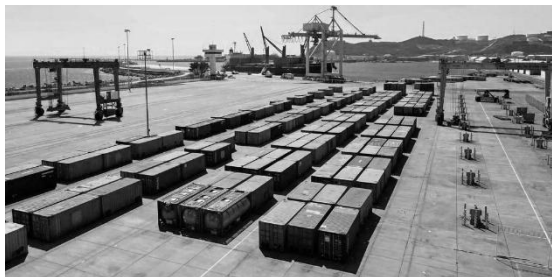
Imagen 1. [Movimiento de carga en puertos]. Tomada de Real Estate (s.f.)
