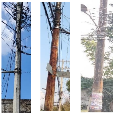
Imagen 15. Tipo de postes. (Concreto, Metálico y Madera).
