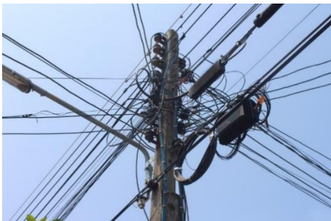
Figura 17. Fibra óptica en poste.
