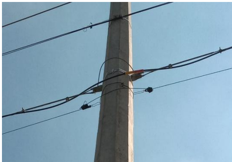
Figura 17. Fibra óptica en poste.
