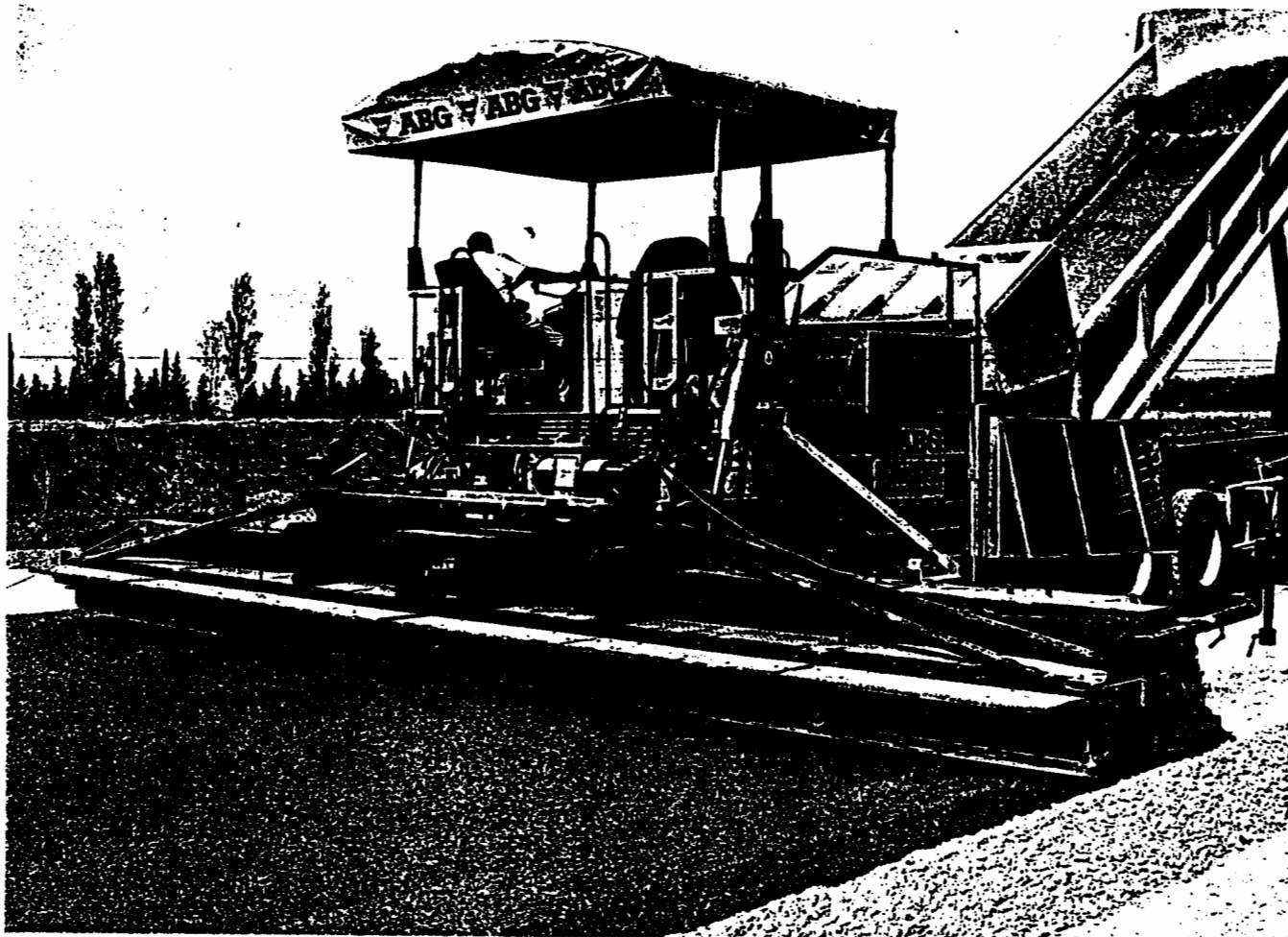
Fig. 3.21, Pavimentadora de CCR
