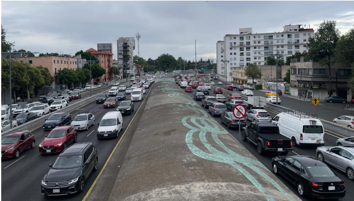
Ilustración 4 Carriles centrales del Viaducto Miguel Alemán
