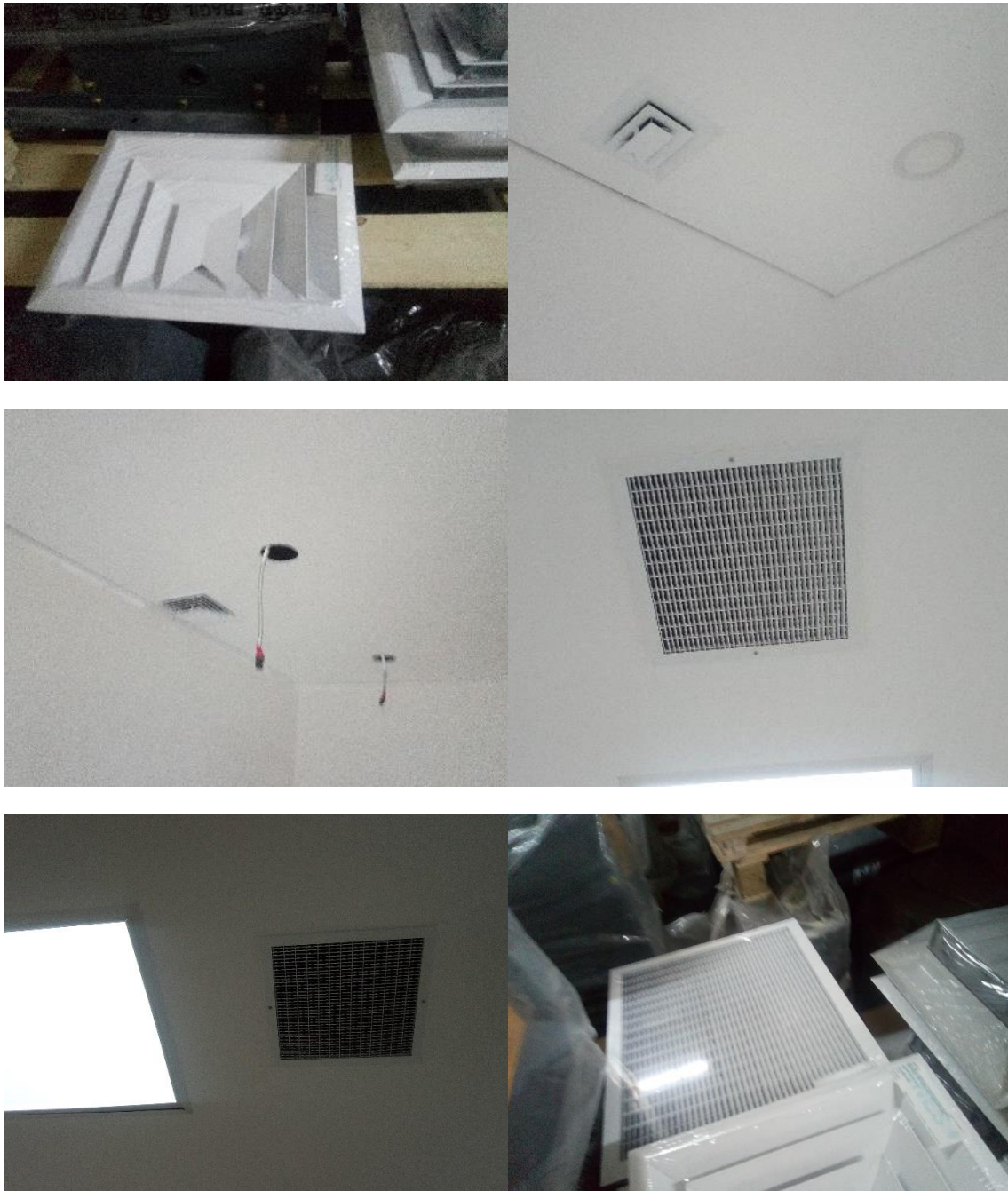
Figura 19: Colocación de rejillas y difusores
