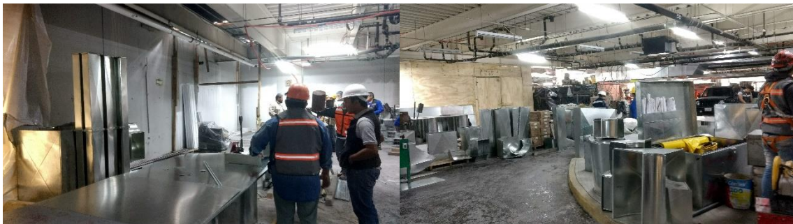
Figura 10 A: Fabricación de ducteria, previamente calculada y aceptada, en sótano del
