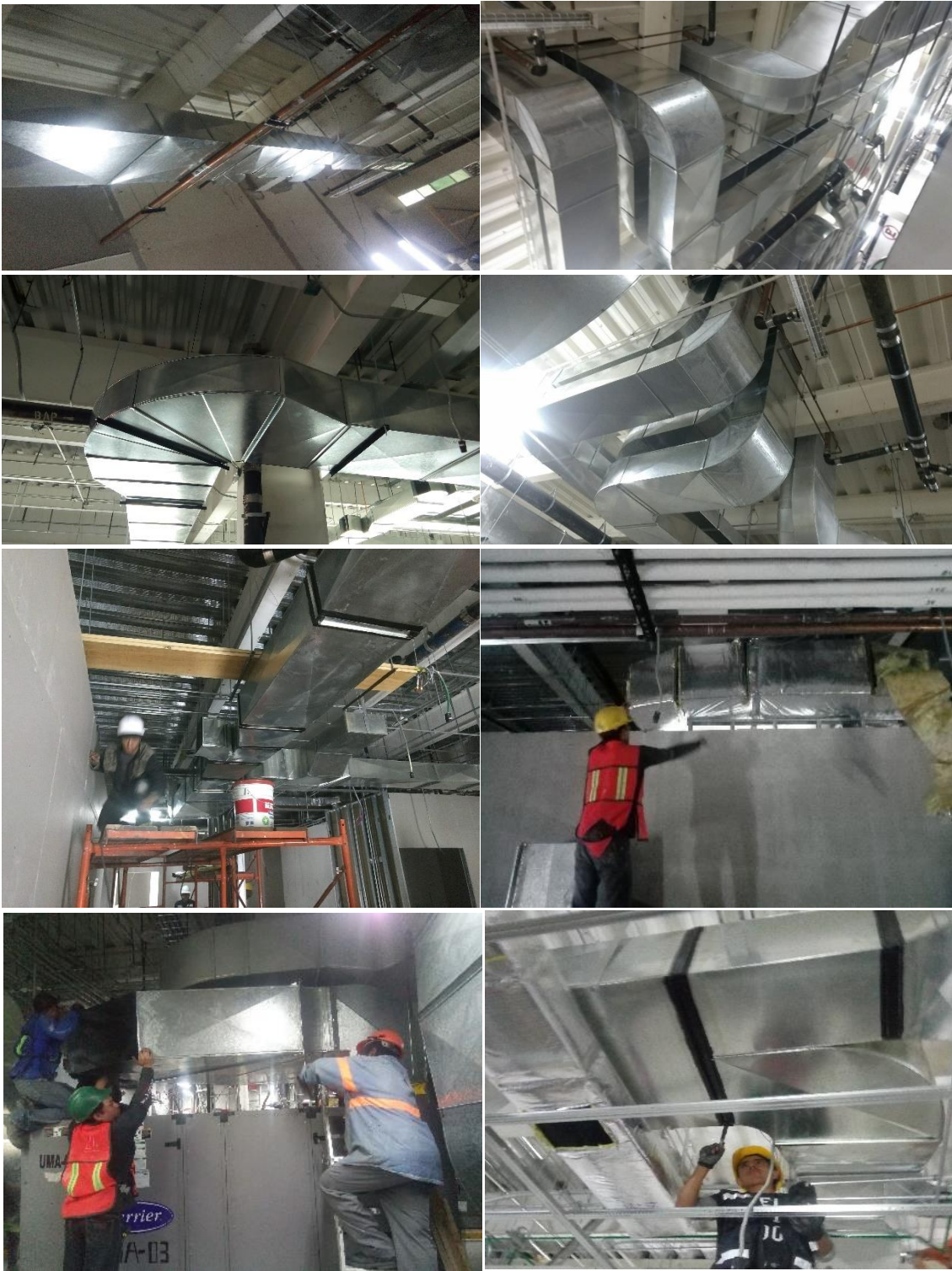
Figura 10 C: Instalación de ductos para distribución de aire, sellado de uniones y aislante
