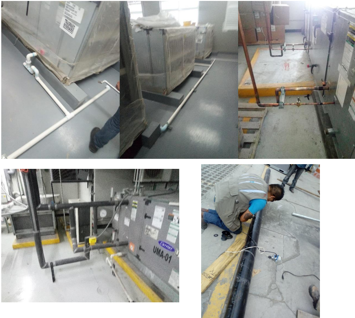
Figura 10 E: Instalación de drenes y de tuberías de agua helada.
