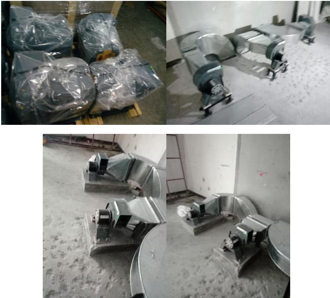
Figura 9: Suministro e instalación de extractores para área de Trasplantes
