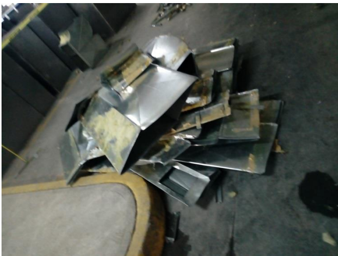
Figura 1: Desmantelamiento de ductos
