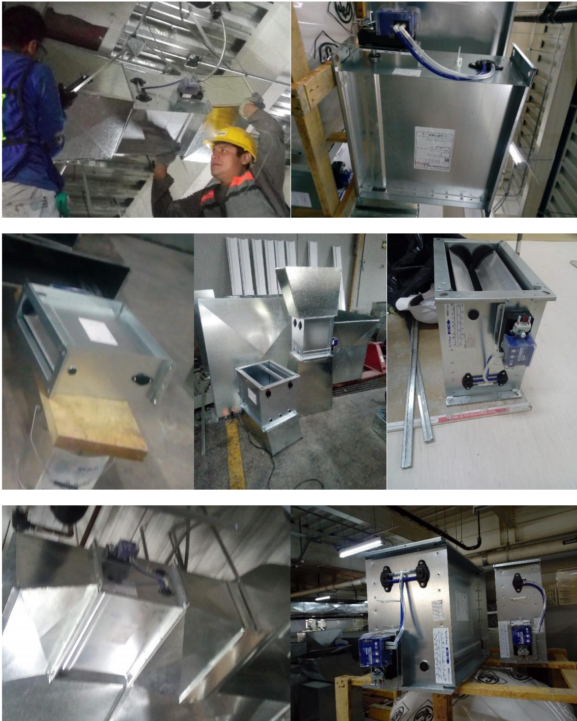
Figura 10 D: Instalación de cajas de volumen
