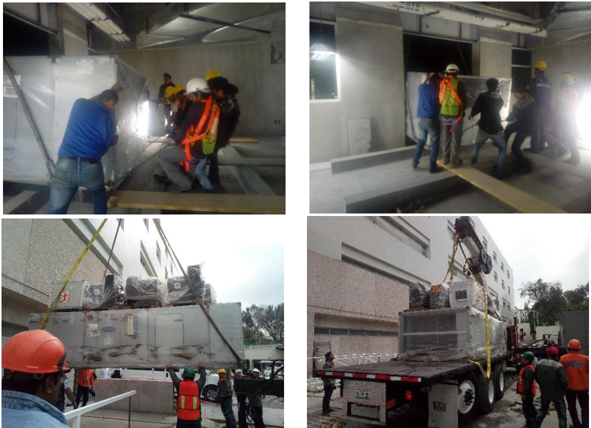
Figura 8: Maniobra de elevación y colocación de UMA en cuarto de máquinas
