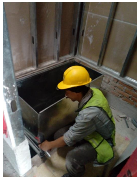
Figura 2: Trabajo de desmantelamiento
