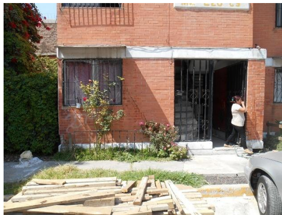
Figura 1.2. Daños estructurales identificados en un edificio de vivienda por el 19S17.
