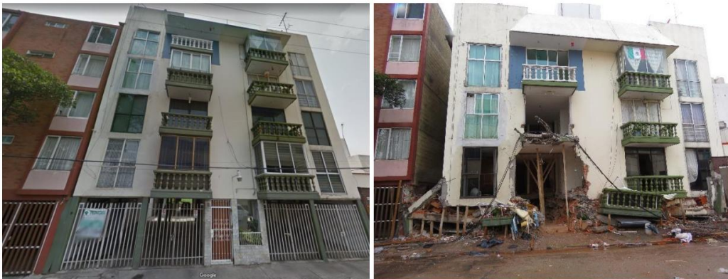
Figura 1.4. Edificación antes y después del S19-2017, falla por planta baja débil (SÍSÉ, 2025).
