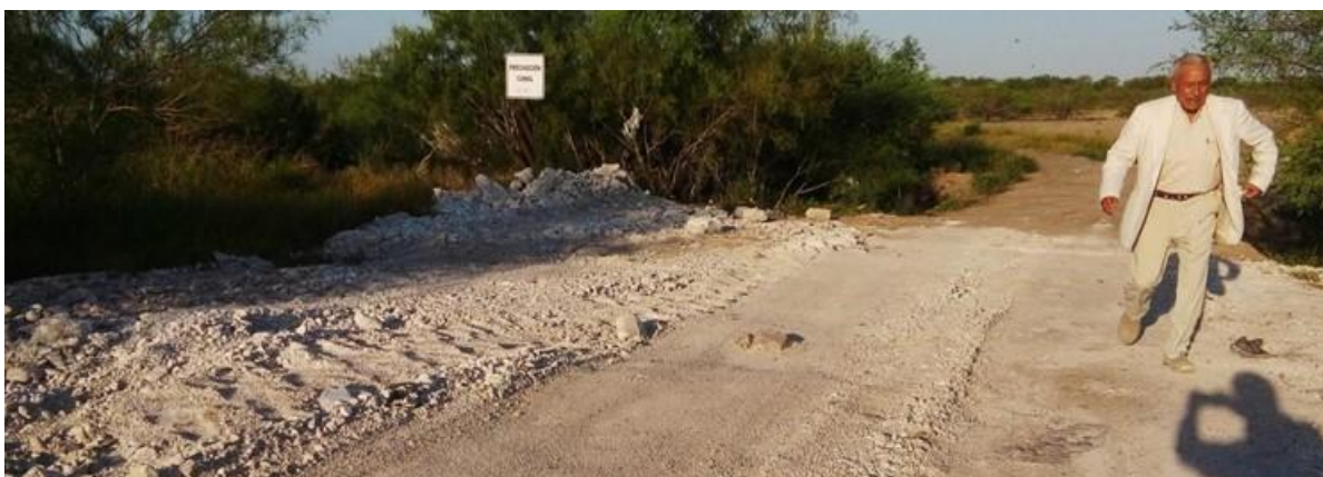
Imagen 129. Supervisión de la colocación, conformación y compactación de la capa de sulfato de calcio para el reacondicionamiento de los caminos interiores y de las plataformas de contingencia.
