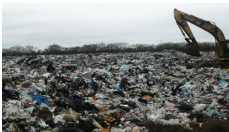
Imágenes 119 y 120. Fotografía de la izquierda, actividades de colocación de cobertura en una celda de disposición final con los residuos expuestos al aire.
