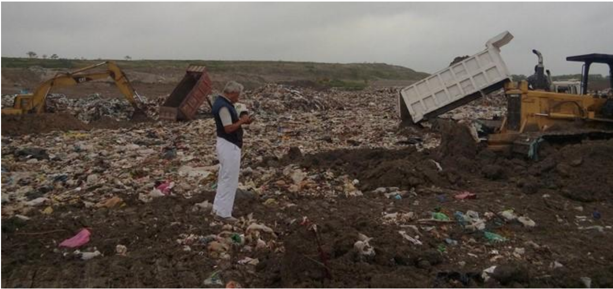
Imagen 126. Supervisión de las actividades del Plan de Rescate y Saneamiento del Relleno Sanitario de Matamoros. Colocación de cobertura en las celdas con residuos expuestos. Imagen propia.
