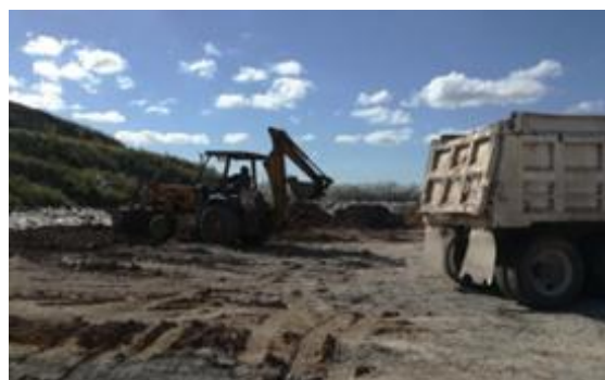
Imágenes 121 y 122. Fotografía de la izquierda, actividades de colocación de cobertura en celdas con residuos calcinados durante los incendios.
