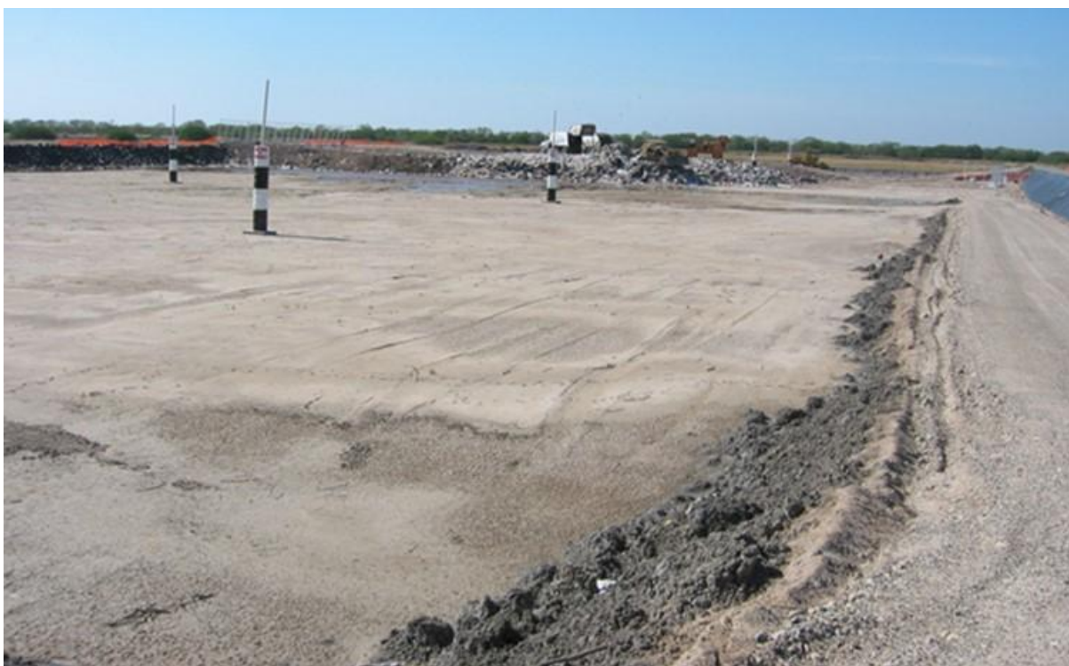
Imagen 25. Inicio de operaciones del Relleno Sanitario Regional. Disposición de residuos sólidos urbanos en la celda de emergencia (la primera celda que estuvo en funciones).
