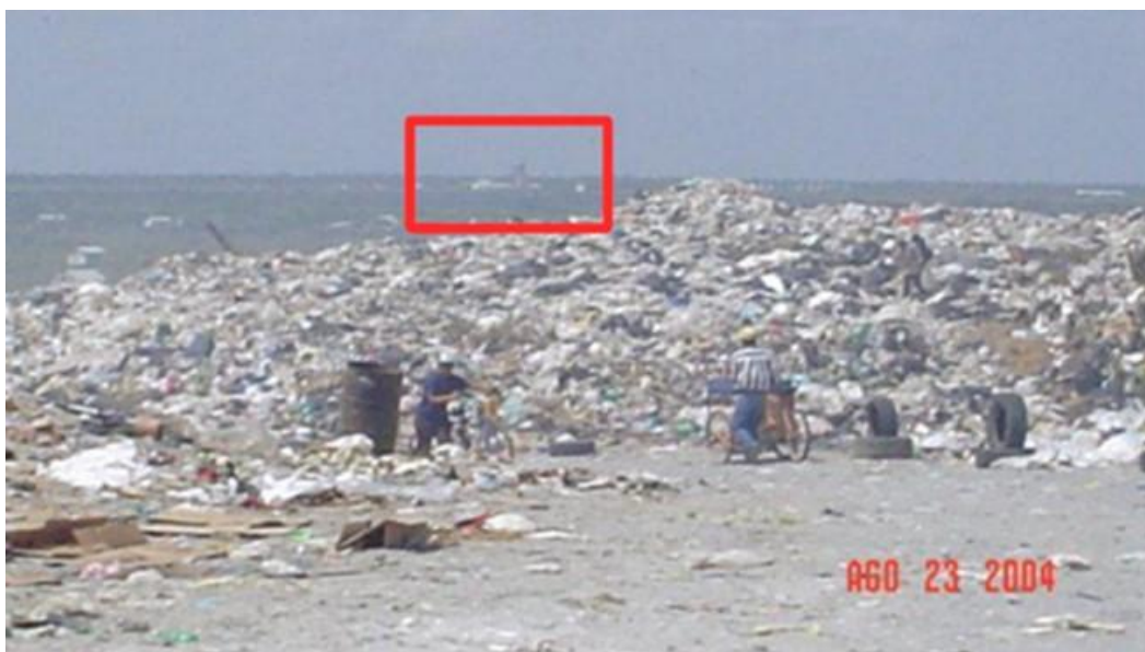
Imagen 30. Antiguo tiradero a cielo abierto de Matamoros (El Basurero Municipal). Este sitio recibía en promedio 400 toneladas diarias. En esta fotografía se logra apreciar la torre de control del Aeropuerto General Servando Canales dentro del rectángulo color rojo. El predio de este antiguo sitio de disposición final aparece dentro de un polígono magenta en la Imagen 29. Imagen cortesía del Ing. Magdaleno Rodríguez.
