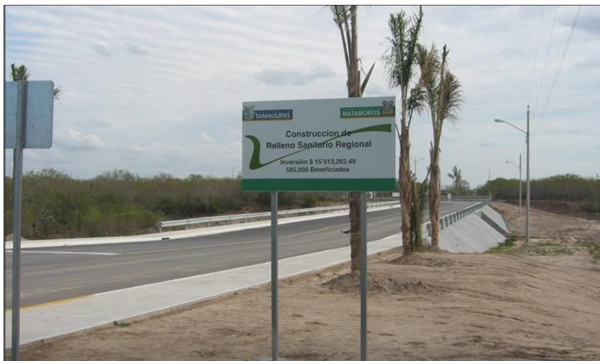
Imagen 3. Letrero colocado en la entrada del relleno sanitario durante su etapa de construcción. Imagen cortesía del Ing. Magdaleno Rodríguez.
