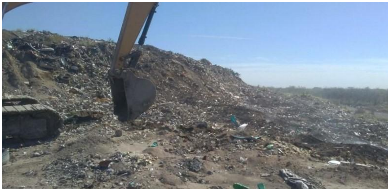
Imagen 117. Inicio de las actividades de rescate y saneamiento en el Relleno Sanitario Regional de Matamoros. La primera etapa de limpieza y saneamiento consistió en la disposición final de los residuos calcinados y cenizas expuestas en las celdas de confinamiento. También se sofocaron los conatos de incendio con apoyo de la maquinaria pesada. Imagen cortesía del Ing. Magdaleno Rodríguez.
