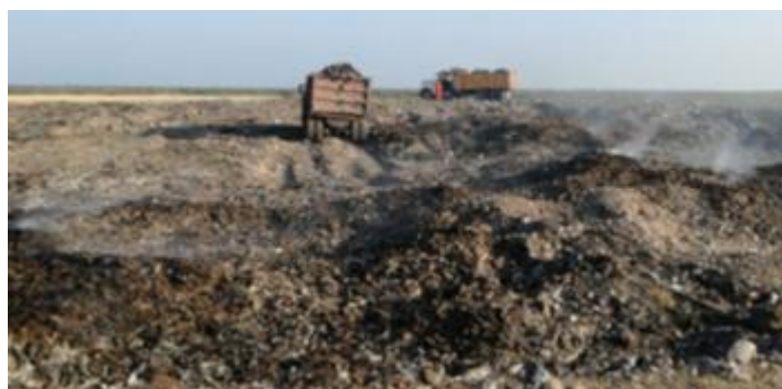
Imágenes 121 y 122. Fotografía de la izquierda, actividades de colocación de cobertura en celdas con residuos calcinados durante los incendios.
