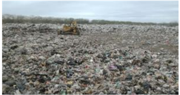
Imágenes 123 y 124. Fotografía de la izquierda, un tractor de orugas es entregado en el interior de las instalaciones del relleno sanitario para apoyar en las actividades de limpieza y saneamiento. Fotografía de la derecha, el mismo tractor de orugas realizando la conformación y compactación de residuos en una de las celdas con residuos expuestos al aire libre. Imágenes cortesía del Ing. Magdaleno Rodríguez.
