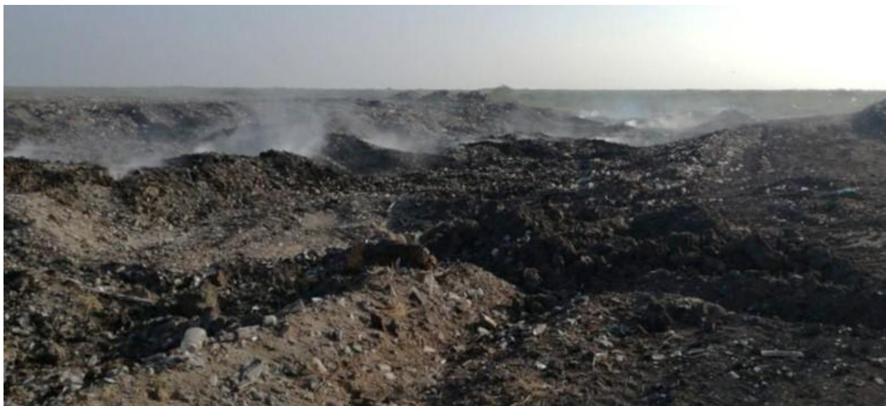
Imagen 116. Humo procedente de las celdas de confinamiento. Los incendios fueron una contingencia muy recurrente durante la Administración Municipal 2015–2018. Imagen cortesía del Ing. Magdaleno Rodríguez.
