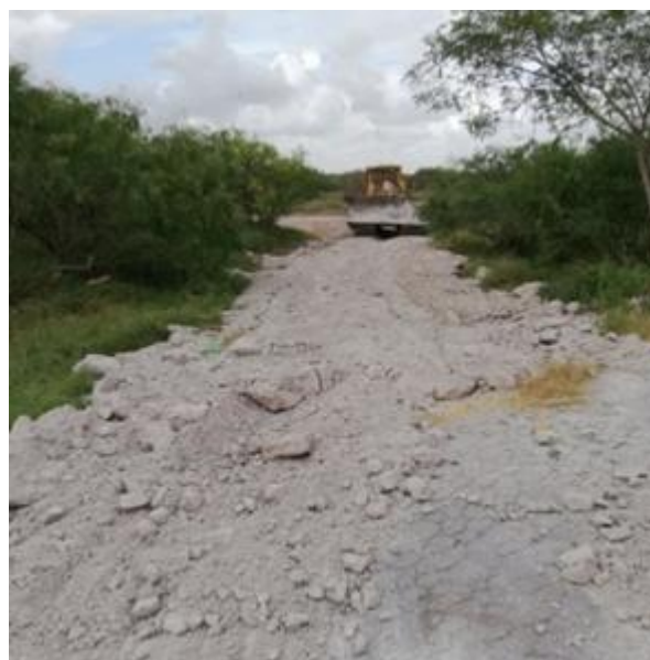
Imágenes 127 y 128. Colocación, conformación y compactación de sulfato de calcio en los caminos interiores del Relleno Sanitario de Matamoros.
