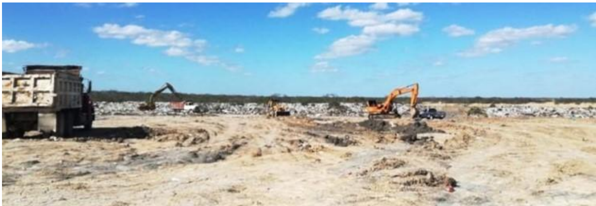
Imagen 125. Supervisión de las actividades del Plan de Rescate y Saneamiento del Relleno Sanitario de Matamoros. Colocación de cobertura en las celdas con residuos expuestos. Imagen propia.
