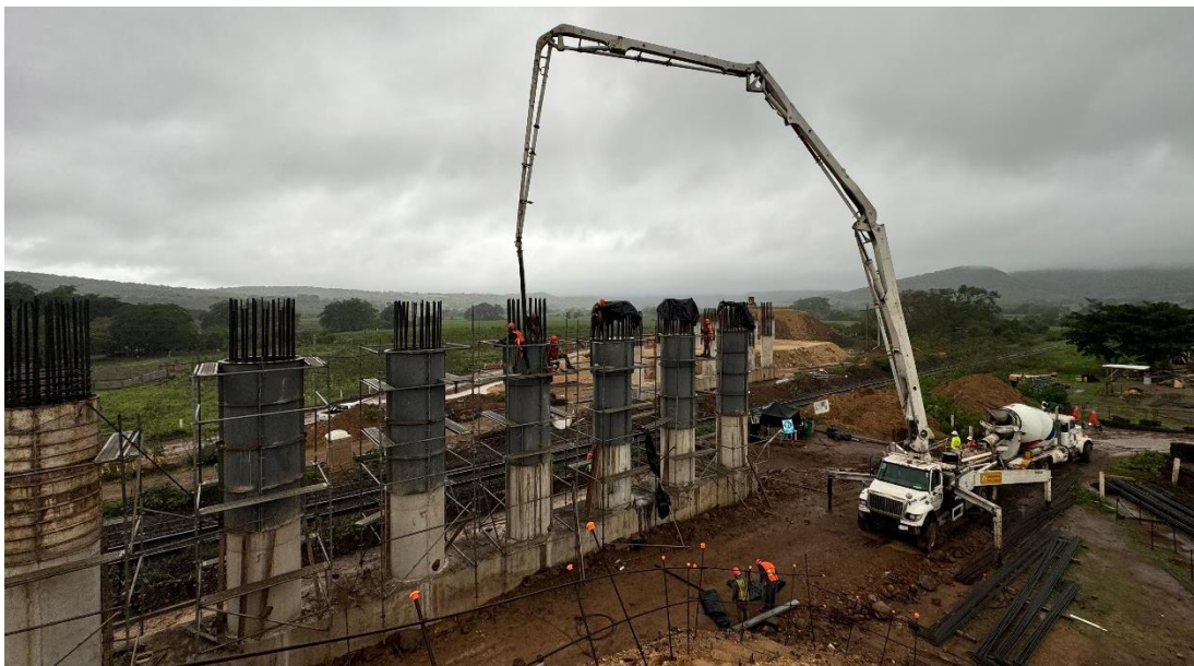
Figura 2.33 Colado de columnas, 2do trepado, PSFC 21.01
