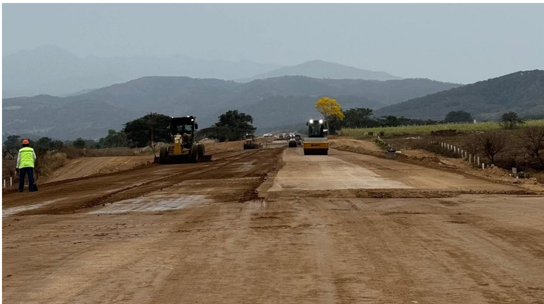
Figura 3.3 Colocación y compactación de capa subyacente.
