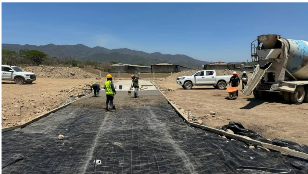
Figura 2.5 Colocación de malla de acero en ODT 25.03
