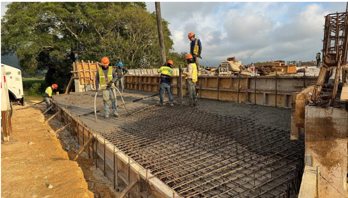
Figura 2.54 Colado de losa de acceso, muro de respaldo y dentellón en PK-, PTE 20.01.
