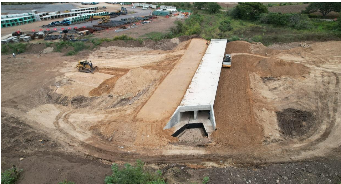
Figura 2.1 ODT 24.02, estilo cajón, finalizada.
