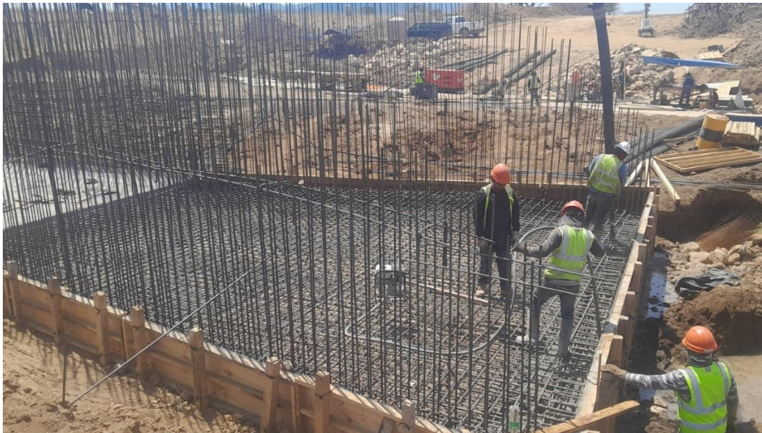
Figura 2.20 Colado de losa de cimentación en PSMA 25.01
