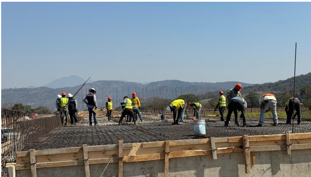
Figura 2.49 Armado de losa tablero en PTE 19.01
