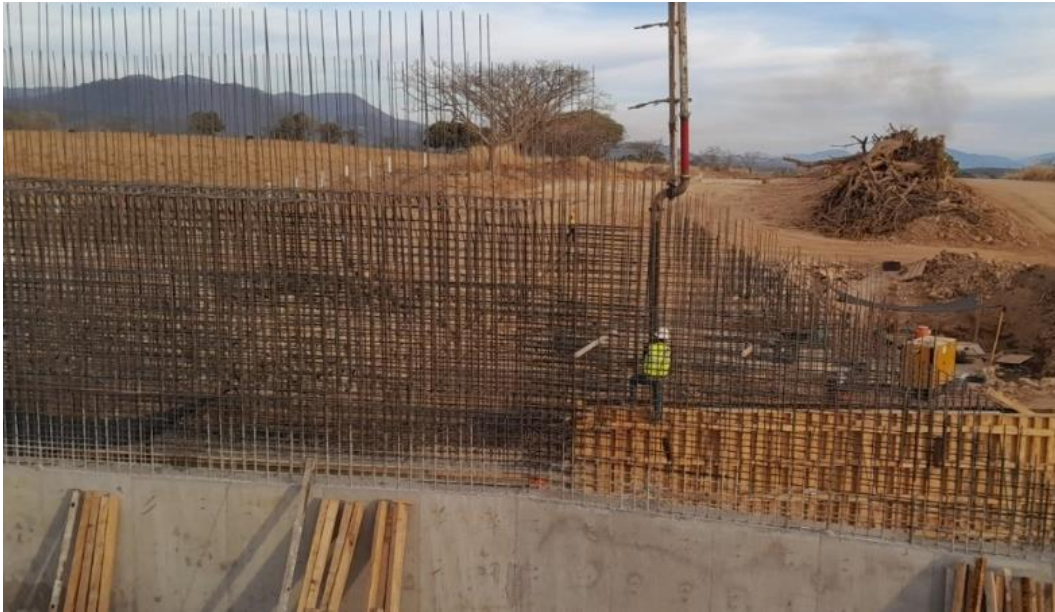
Figura 2.21 Colado de alero y muro en Pk+ primer trepado en PSMA 24.01
