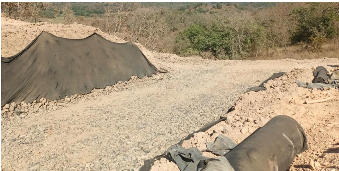
Figura 2.4 Colocación de geotextil y capa de finos en ODT 18.2
