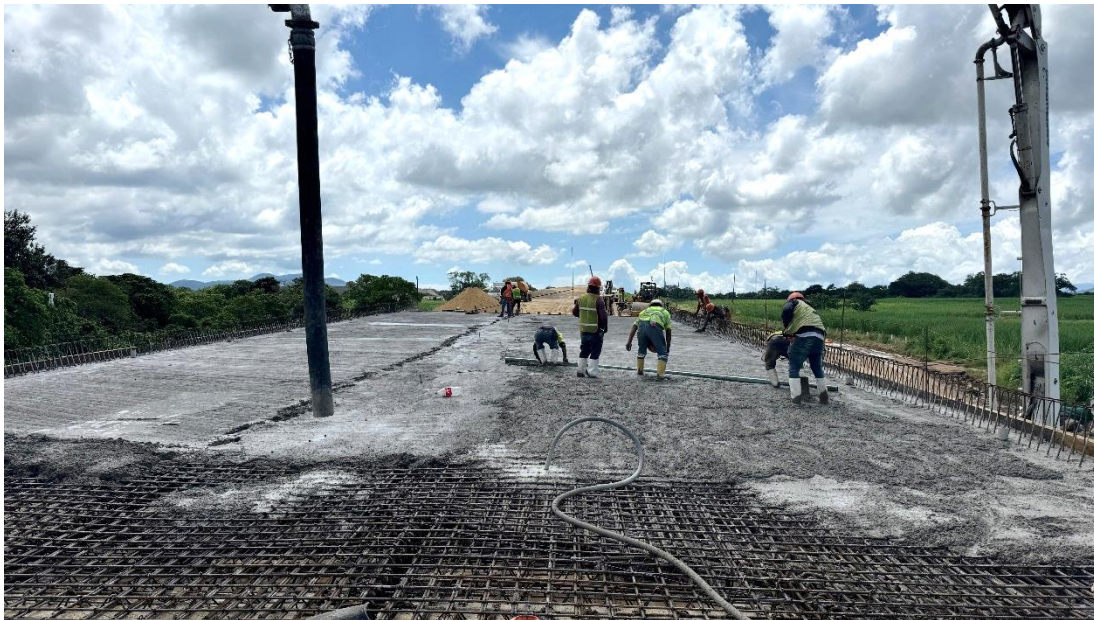
Figura 2.50 Colado de la losa tablero en PTE 21.01
