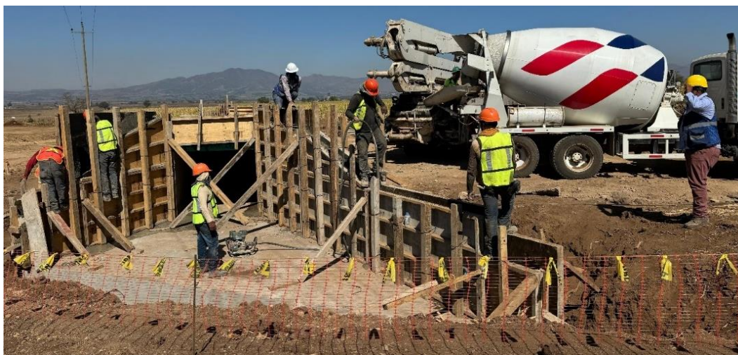
Figura 2.16 Colado de aleros y guarnición en ODT 25.02
