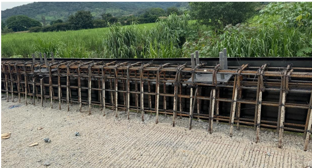
Figura 2.53 Armado y colocación de placas metálicas para parapeto
