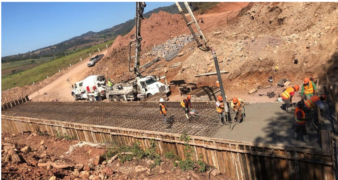
Figura 2.10 Colado de losa superior en ODT 18.02
