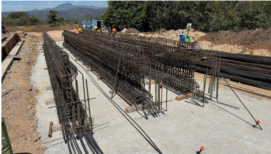
Figura 2.39 Armado de trabe tipo III
