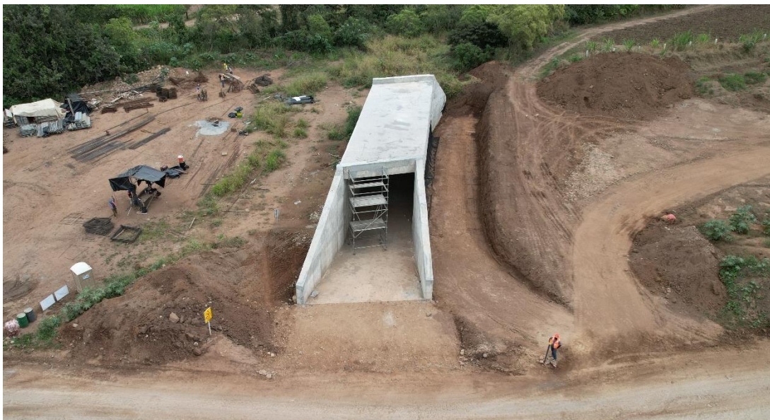
Figura 2.17 Paso superior de maquinaria agrícola (PSMA), finalizado.
