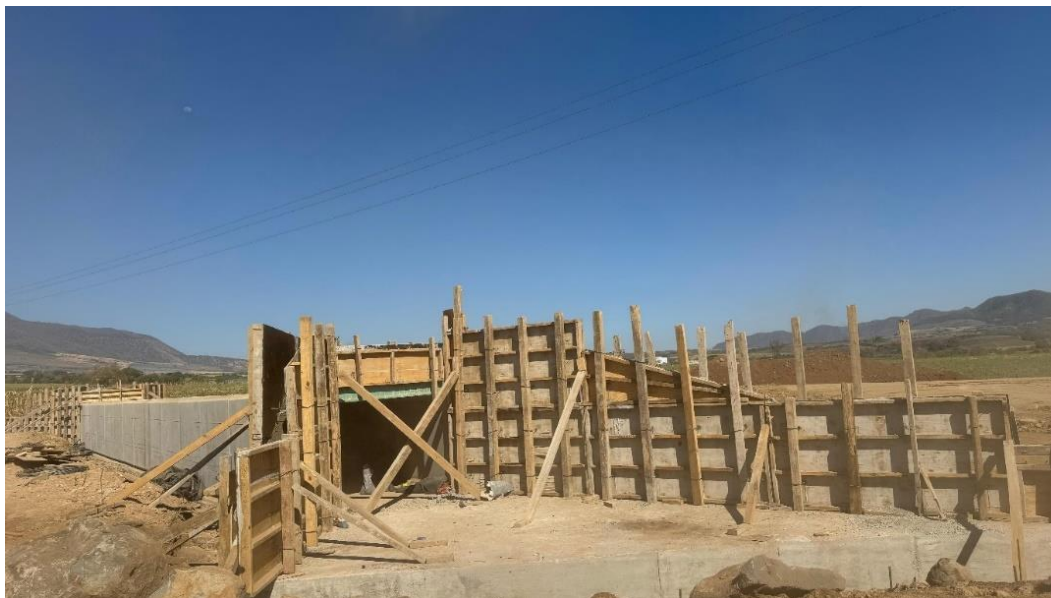
Figura 2.15 Colado y armado de aleros con guarnición en ODT 25.01
