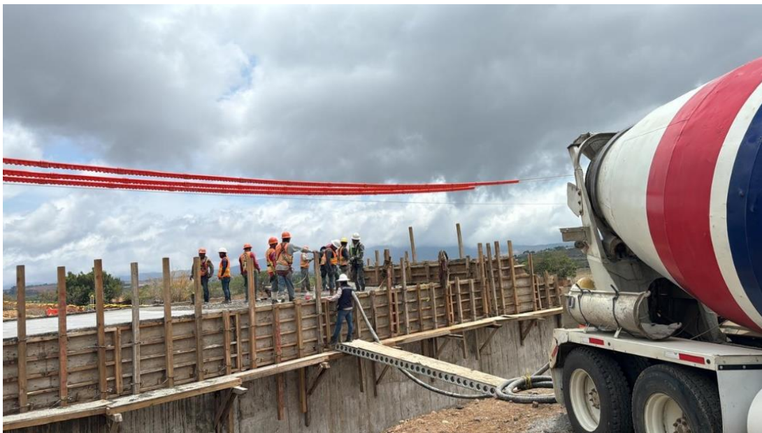
Figura 2.23 Colado de losa superior en PSMA 24.01
