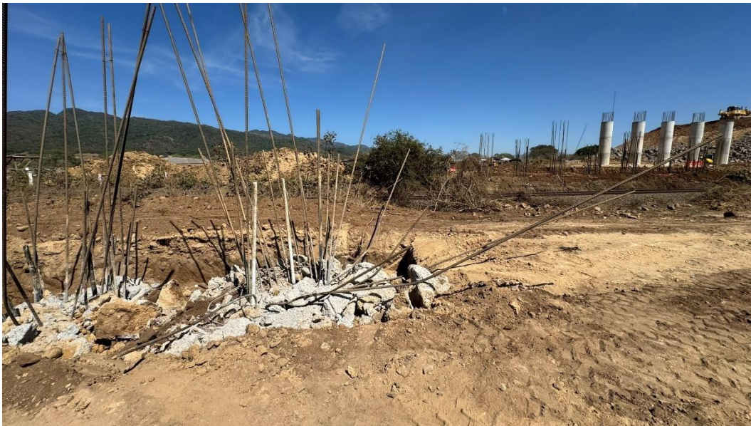
Figura 2.32. Descabezado de pila
