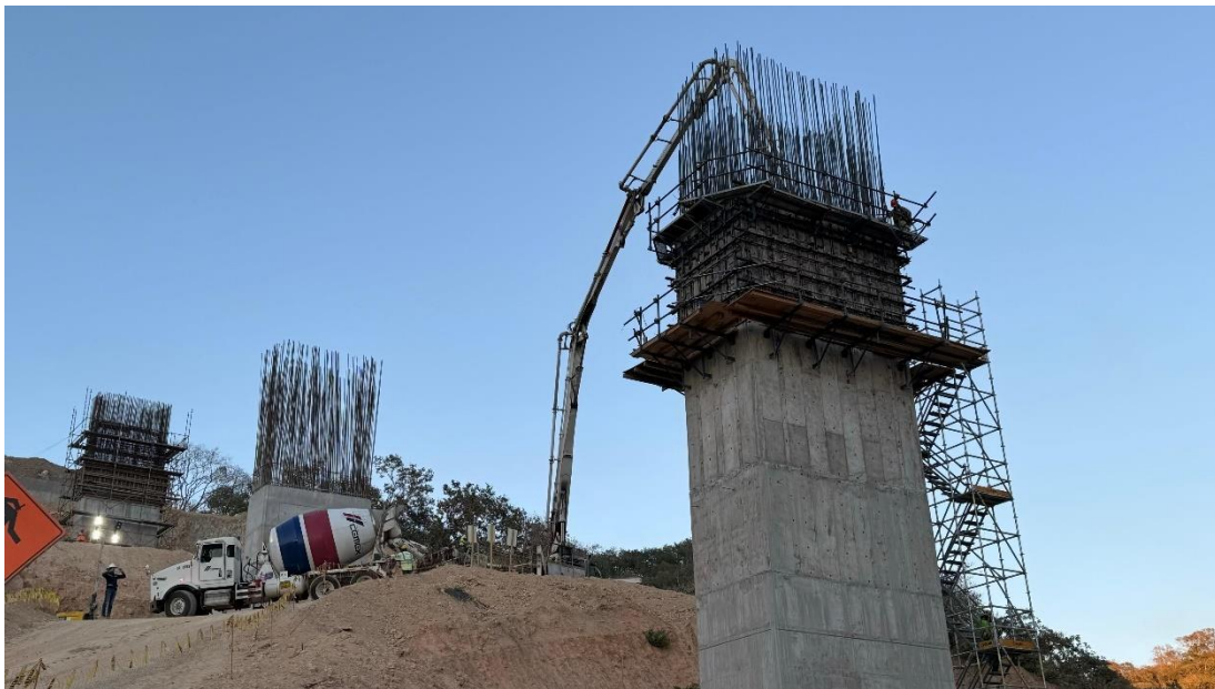
Figura 2.34 Colado de columna hueca, trepado 4to, en PTE 17.01
