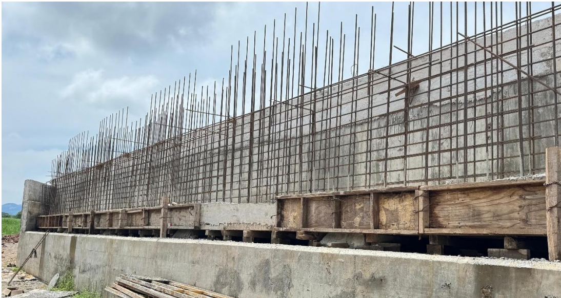
Figura 2.45 Diafragma en estribo 2, apoyado en bancos y neopreno en PSV 19.01
