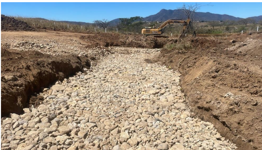
Figura 2.3 Colocación y acomodo de piedra en ODT 24.03
