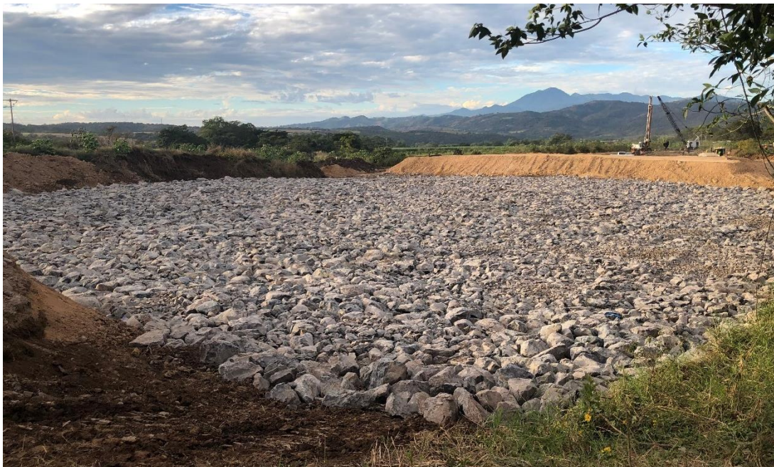
Figura 3.1 Material no compactable, bandeado y acomodado
