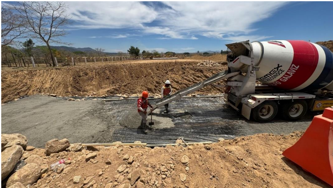
Figura 2.19 Colocación de malla, cimbra para plantilla y colado para PSMA 25.01
