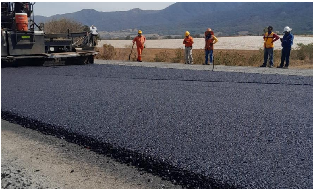
Figura 3.8 Primera capa de la carpeta de concreto asfáltico.
