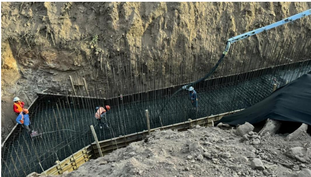
Figura 2.8 Colado de losa de cimentación en ODT 17.02
