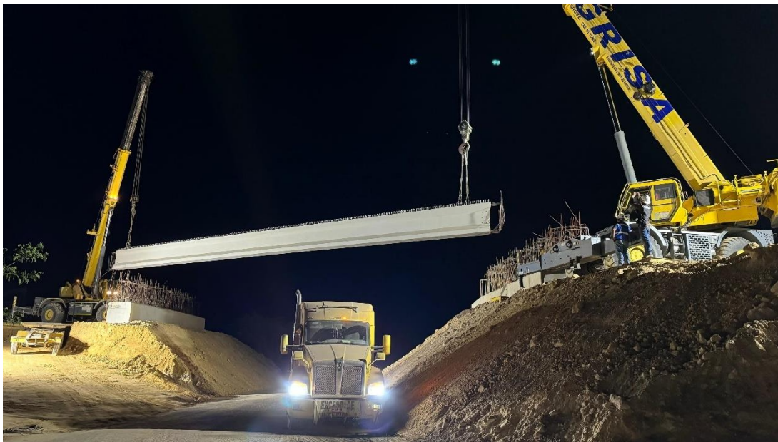
Figura 2.41 Colocación de trabe tipo III en PSV 21.01
