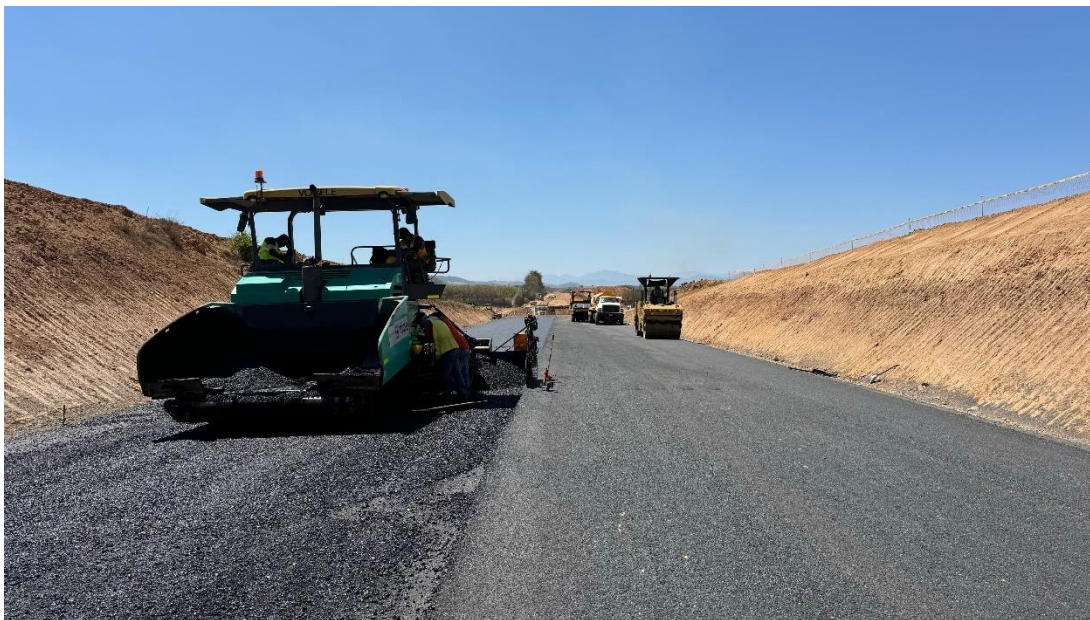
Figura 3.7 Colocación del material asfáltico y compactación de la primera capa de concreto asfáltico.
