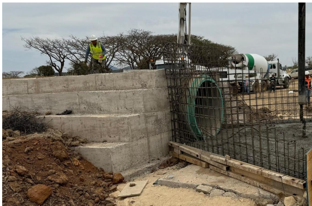
Figura 2.13 Acostillado en forma piramidal en ODT 22.01
