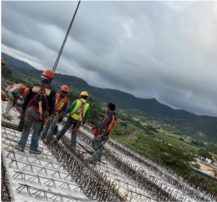
Figura 2.47 Montaje de prelosas
