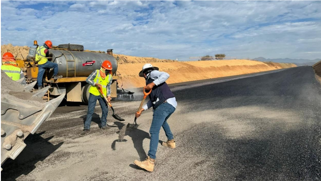
Figura 3.6 Distribución de arena en base hidráulica
