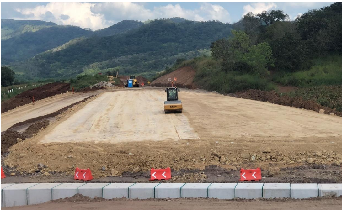
Figura 3.2 Acomodo de materia compactable
