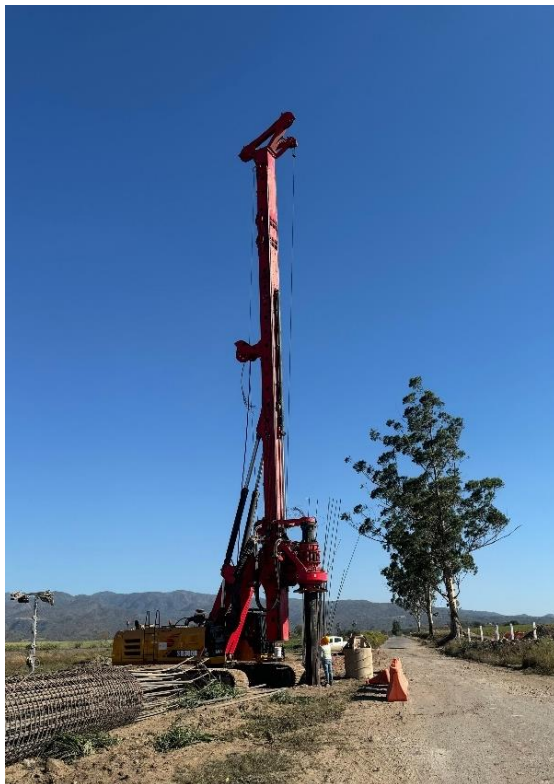
Figura 2.25 Perforación finalizada
