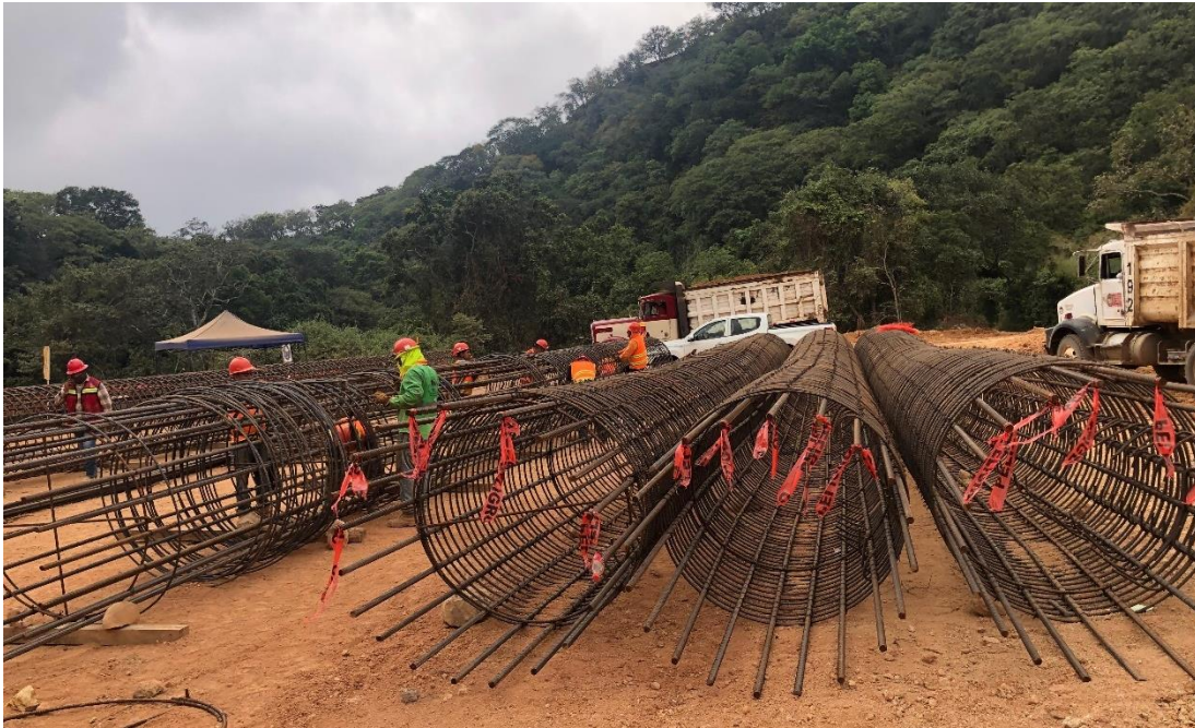
Figura 2.26 Armado estructural para pilas con acero de refuerzo para PTE 17.01
