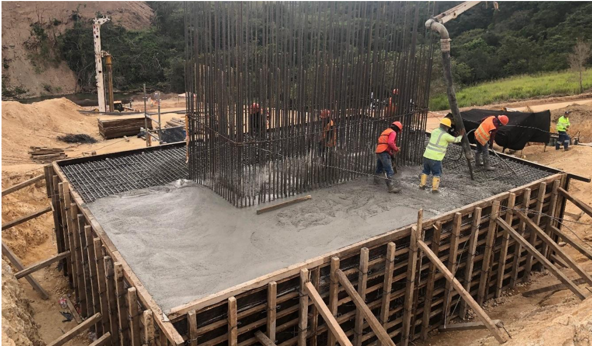
Figura 2.30 Colado de zapata en PTE 17.01
