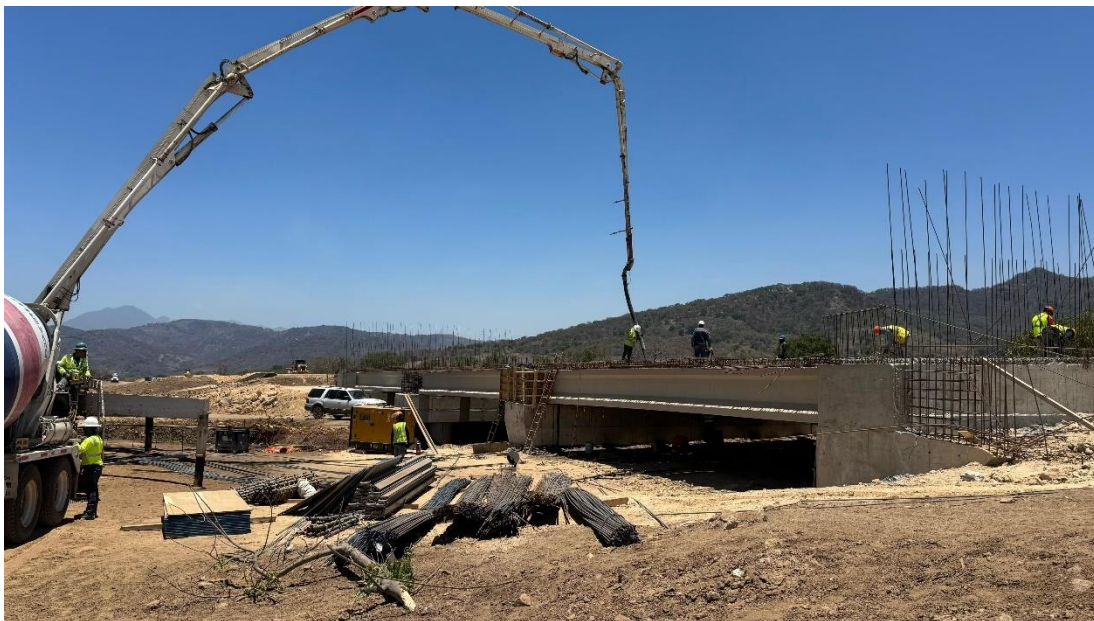
Figura 2.43 Colado de diafragma en pila 2 en PTE 19.01
