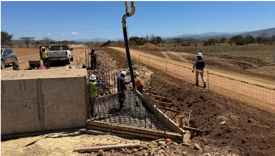
Figura 2.14 Colado de dentellón y solera en ODT 23.01
