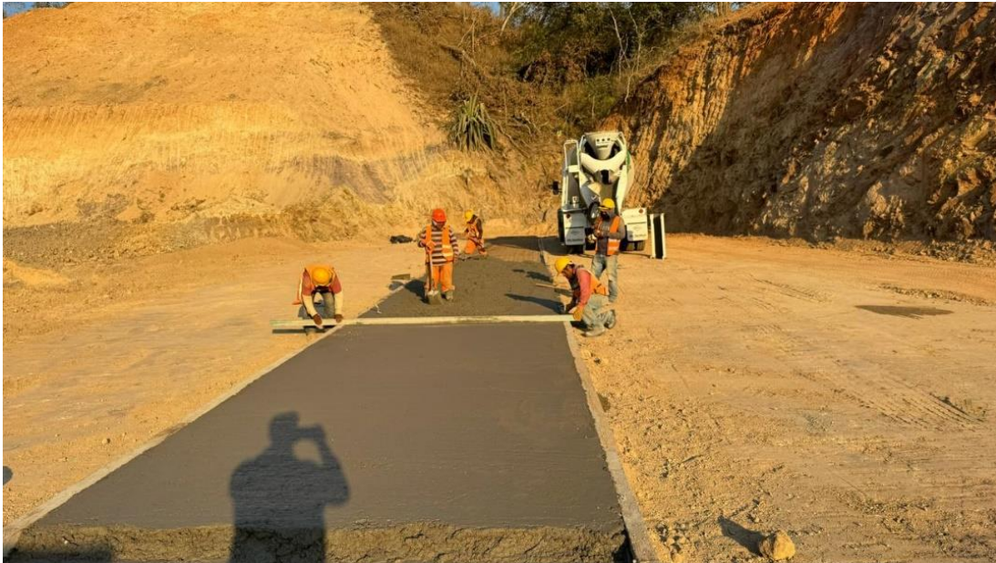
Figura 2.6 Acabado fino de plantilla en ODT 20.01
