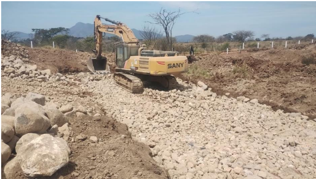
Figura 2.18 Colocación y acomodo de piedra para PSMA 25.01
