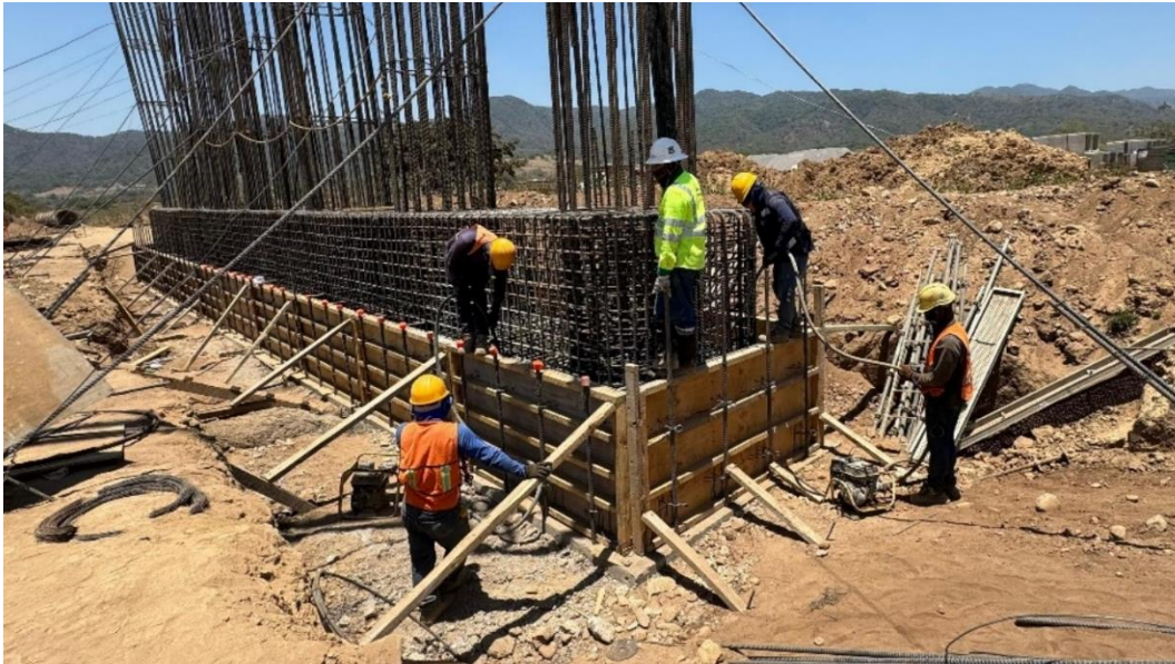
Figura 2.31 Colado de la zapata en apoyo a las 7 columnas en PSFC 21.01
