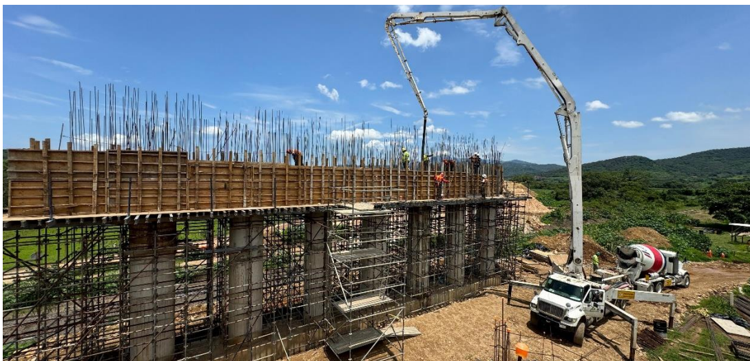
Figura 2.35 Colado de cabezal en pila 2, PSFC 21.01
