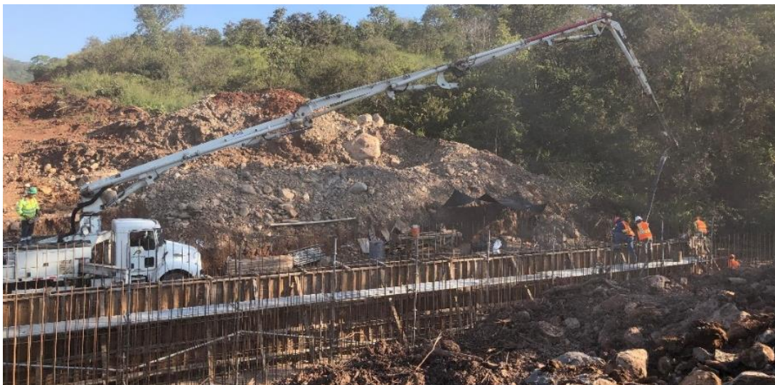
Figura 2.9 Colado de muro lado PK- en ODT 18.02
