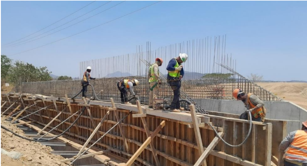
Figura 2.22 Colado de muro y alero en PK-, aplicando vibrado en PSMA 25.01
