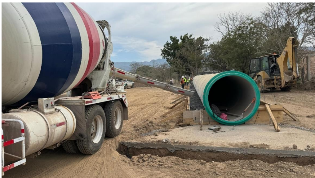
Figura 2.12 Colado de acostillado en ODT 24.04
