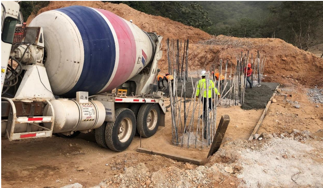
Figura 2.29 Colocación de plantilla PTE 17.01
