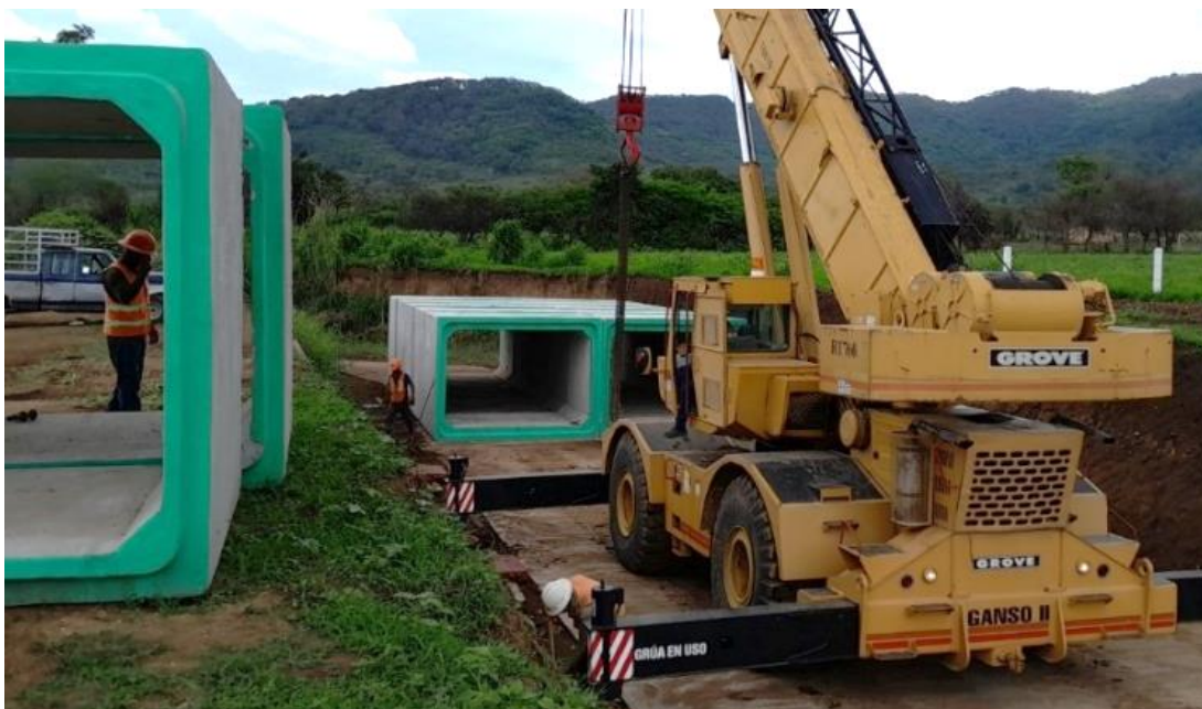
Figura 2.7 Colocación de cajones en ODT 20.04
