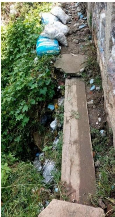
*Figura 9. Tabla sobre el tramo más inestable de la barranca*
