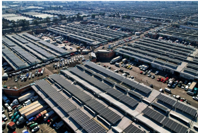
Figura 5.11 Planta Fotovoltaica en la Central de Abastos CDMX
