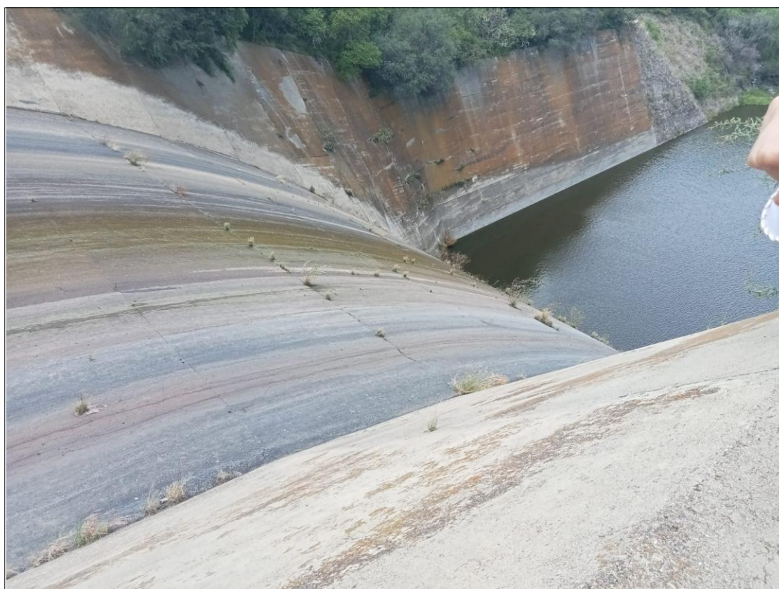
Figura 13 Obra se excedencia, tanque amortiguador. Elaboración propia.
