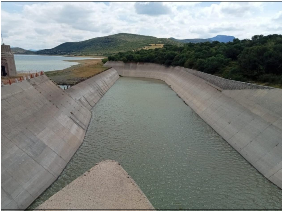
Figura 11 Cortina tipo cimacio Presa Solís. Elaboración propia.
