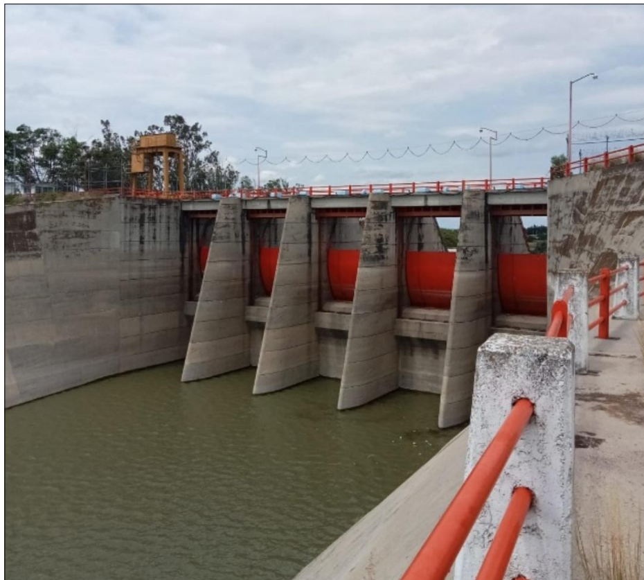
Figura 12 Compuertas radiales Presa Solís. Elaboración propia.
