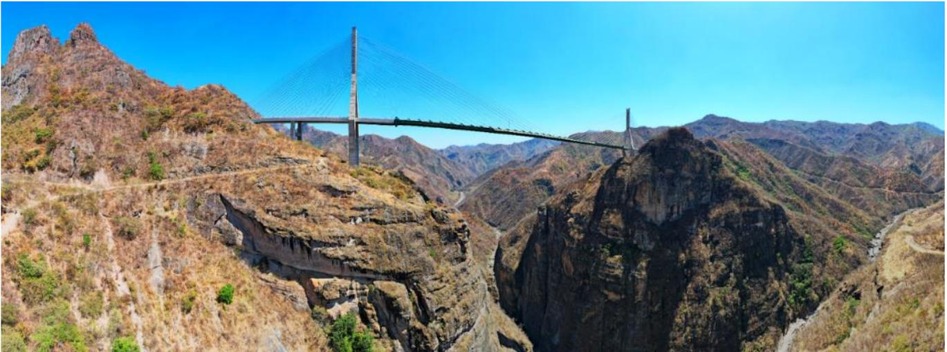
Figura 54. Vista esférica del Puente Baluarte. Este puente tiene una longitud total de 1124 m y una altura sobre la barranca de 402.5 m, por lo que es considerado el puente atirantado más alto de México. Fotografía: Sergio Enrique Macias Medrano. Coordenadas: 23.534585; -105.759368. Fecha: abril de 2022.
