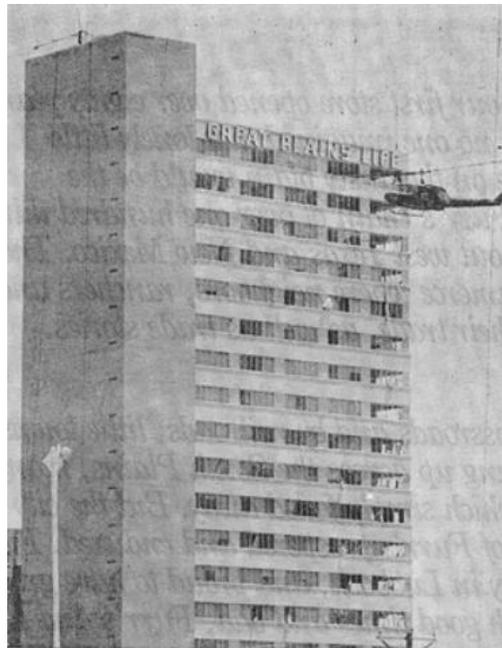
Figura 3.3.2. Edificio Great Plains Life Building, después de balancearse y oscilar durante varios segundos debido a fuertes vientos (<https://n9.cl/n5x0e>).
