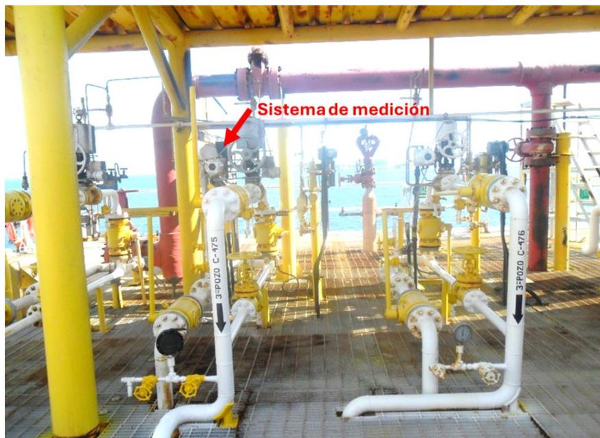
Figura 15. Peines de inyección y sistema de medición de flujo.
