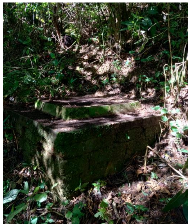
Figura 24. Cuarta caja de conducción hacia el tratamiento.
