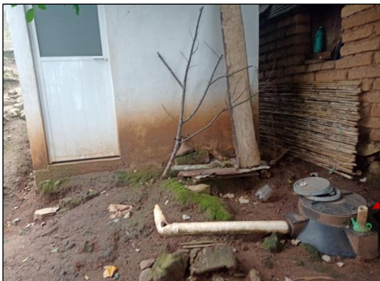
Figura 40. Sanitario con biodigestor sin funcionamiento.
