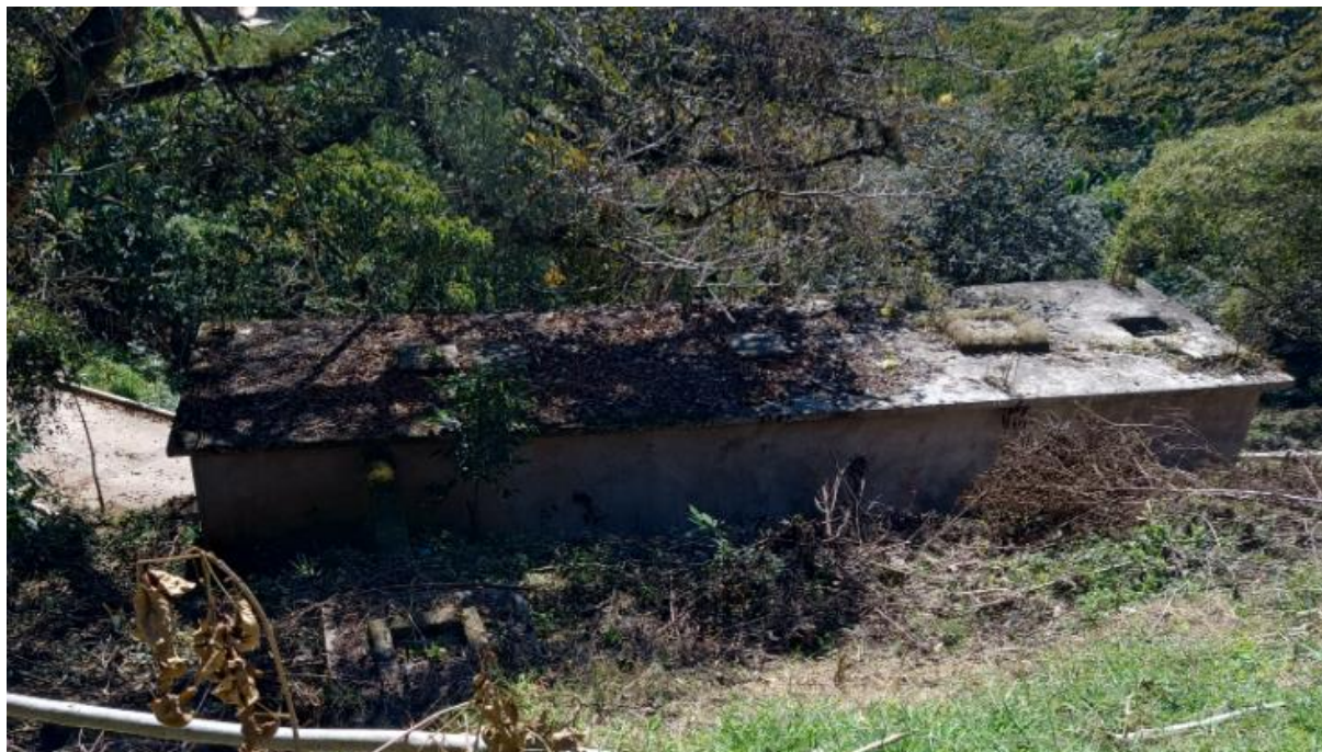
Figura 29. Ubicación de la planta de tratamiento Zona Centro.
