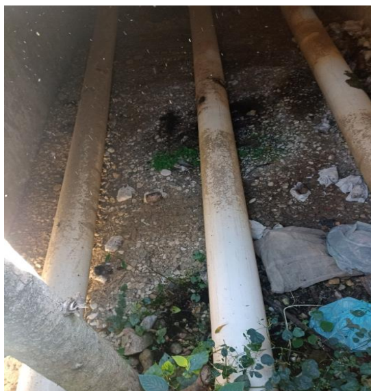
Figura 36. Condición interior de la cámara de oxidación.
