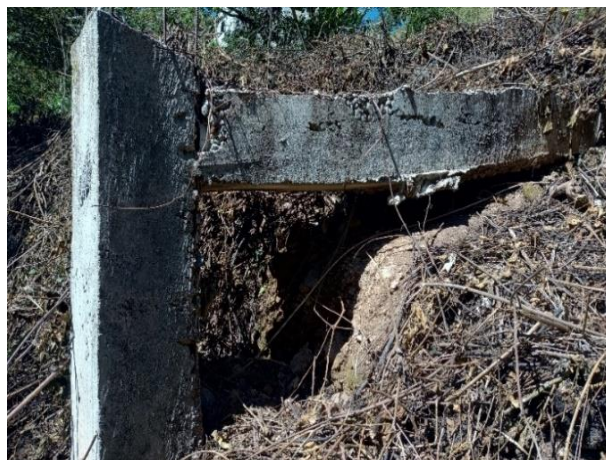
Figura 33. Tubería que conduce el agua tratada al cauce
