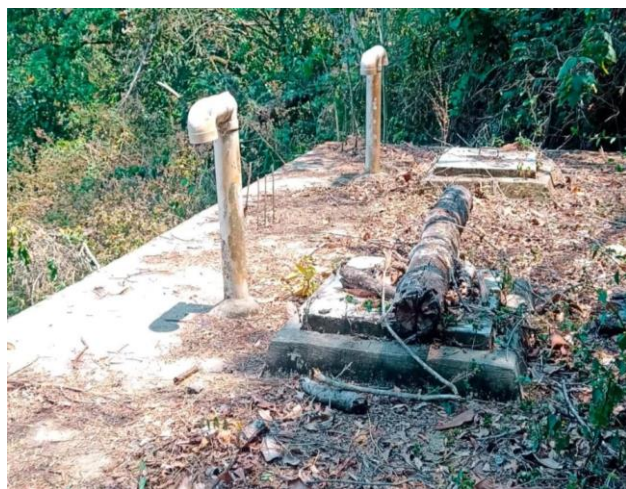
Figura 27 y Figura 28. Condiciones de la ventilación y tapa del tanque.
