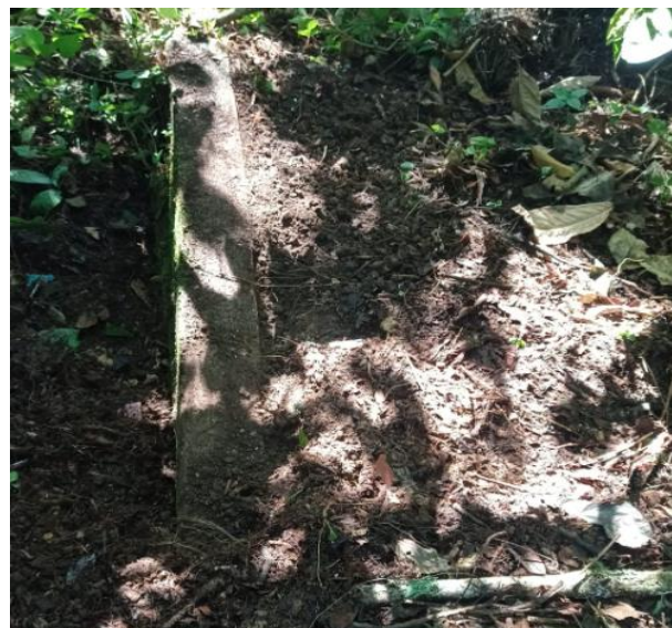
Figura 22. Segunda caja de conducción al tratamiento.
