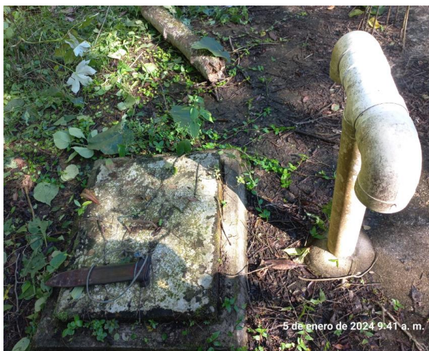
Figura 27 y Figura 28. Condiciones de la ventilación y tapa del tanque.
