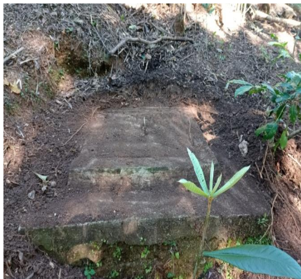
Figura 21. Primera caja de conducción al tratamiento.
