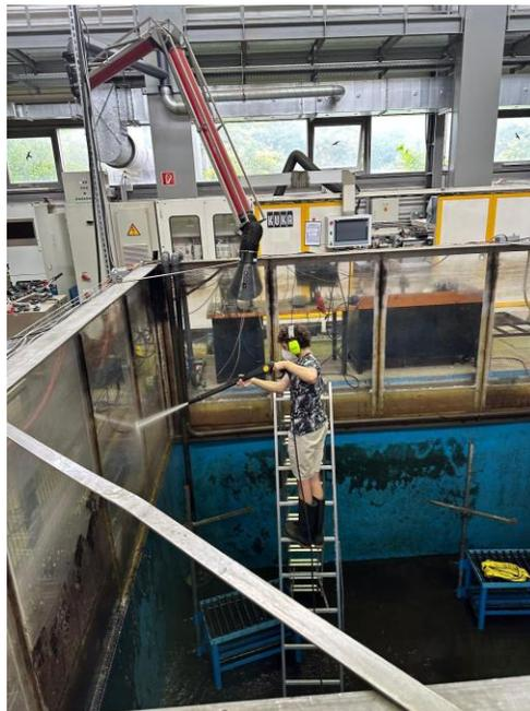
Figura 12b. Limpieza del tanque de inmersión con máquinas de agua a presión.
