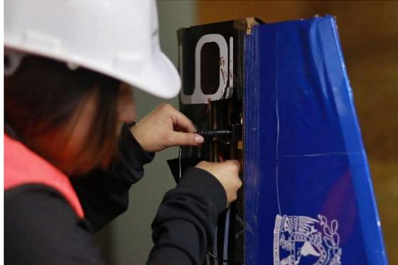
7. Una vez recargada la batería del sensor, tapar el hueco generado para la instalación del sensor, recordando la importancia de dejar descubierta una pequeña parte de la antena del acelerómetro para no interferir en la comunicación con el receptor.
