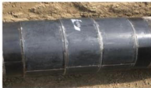
Figura 18. Rehabilitación mediante envoltente metálica, GSD 42" Ramones-Divisadero (DESPUÉS)
