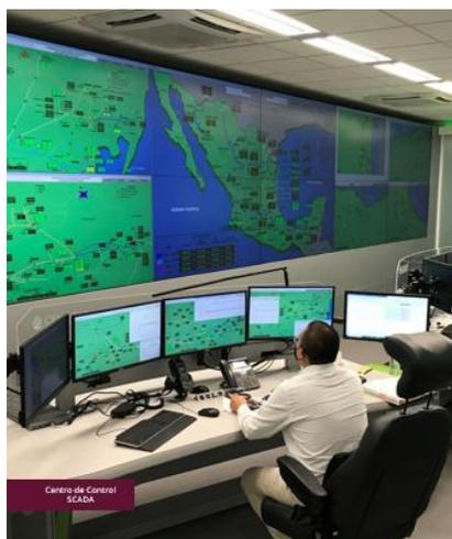
Mediante el Sistema de Administración de Medición de Gas (**SAMG**), se validan los datos de medición observando la tendencia de los parámetros de volumen y energía, asegurando la transferencia oportuna al sistema de nominaciones QUORUM. Ambos sistemas, SCADA y SAMG operan en conjunto para obtener datos en tiempo real confiables. En la figura 10 se puede observar la relación que tienen estos sistemas para la confiabilidad de la medición.
