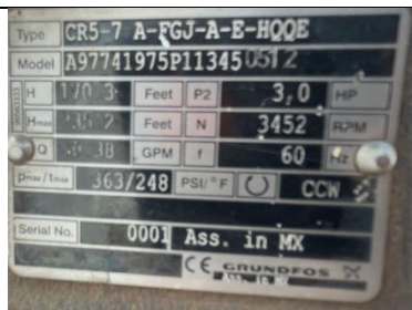
Figura 61. Placa de la bomba del equipo de bombeo No.1.
