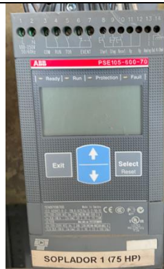
Figura 72. Arrancador suave modelo PSE105-600-70 marca ABB para el soplador de aire (1) de 75 hp.
