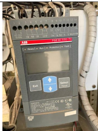
Figura 76. Arrancador suave modelo PSE30-600-70 marca ABB para el soplador de aire (6) de 40 hp.
