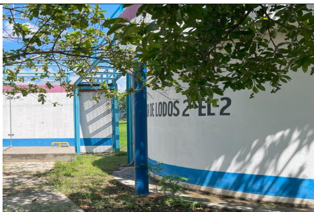
Figura 42. Espesador de lodos secundarios EL-2.
