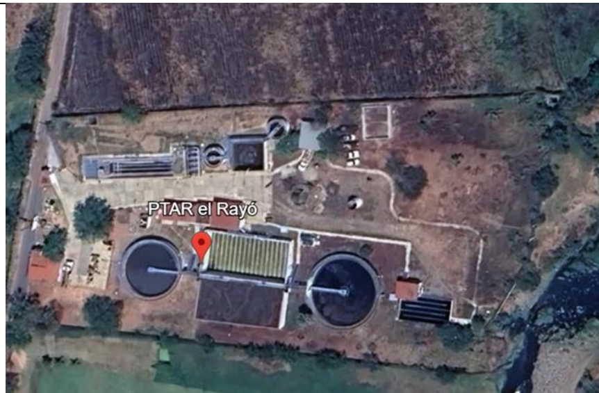
Figura 6. Vista aérea de la PTAR “El Rayo”, Temixco.
