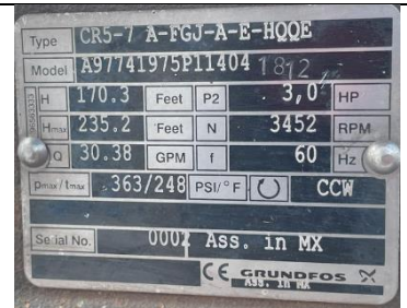
Figura 63. Placa de la bomba del equipo de bombeo No.2.
