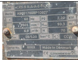
Figura 65. Placa de la bomba del equipo de bombeo No.3.
