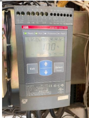
Figura 74. Arrancador suave modelo PSE85-600-70 marca ABB para el soplador de aire (4) de 75 hp.
