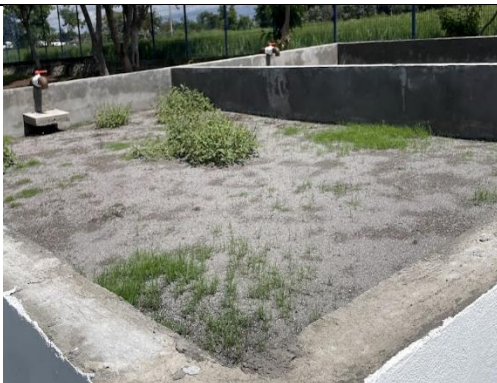
Figura 53. Vista de la obra civil de los dos lechos de secado.
