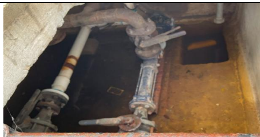
Figura 27. Bomba de cavidad progresiva de 1.00 hp de potencia para bombeo de lodos primarios hacia el espesador de lodos No. 1.
