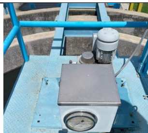
Figura 29. Vista del soplador de lodos EL-1.
