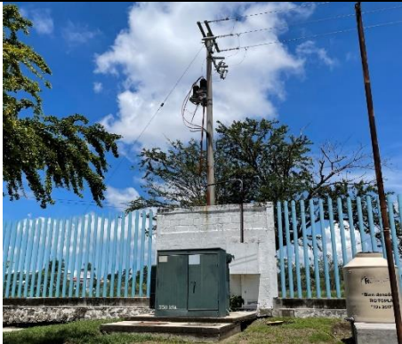
Figura 77. Subestación 750 kVA.
