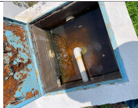
Figura 54. Registro de agua de lixiviado, actualmente no cuenta con bomba.
