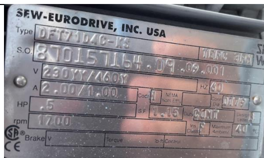
Figura 25. Placa del motor eléctrico del sedimentador primario en funcionamiento continuo.
