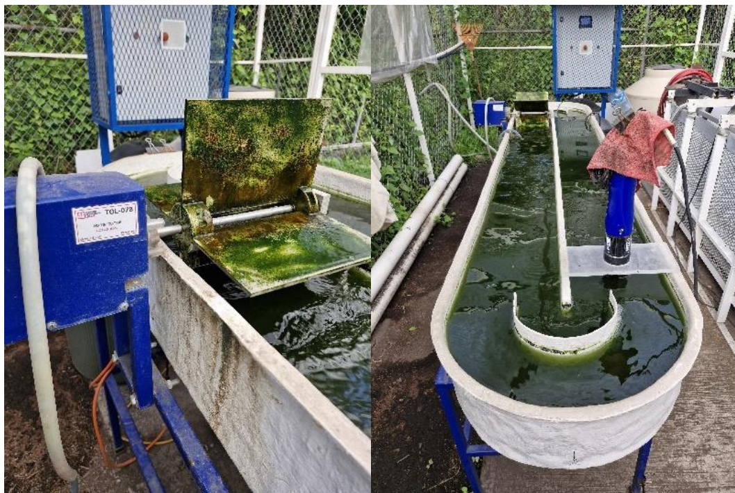
Figura 6. Sistema de mezcla tipo propela y Tanque HRAP.
