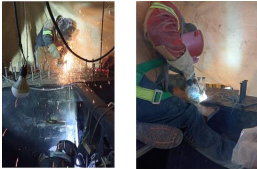
Figura 38. Relleno en patines superiores
