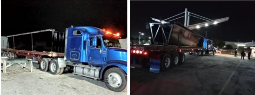
Figura 16. Salida de taller de sección de 12 metros
