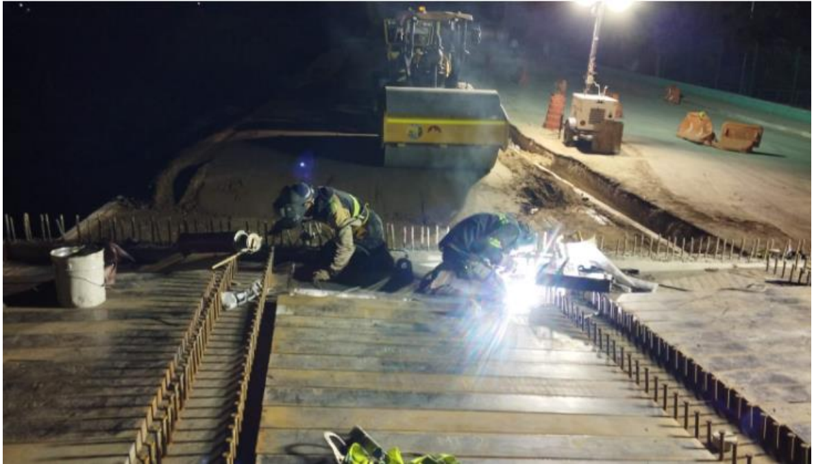
Figura 56. Aseguramiento (punteo) de montenes en el claro 3-4
