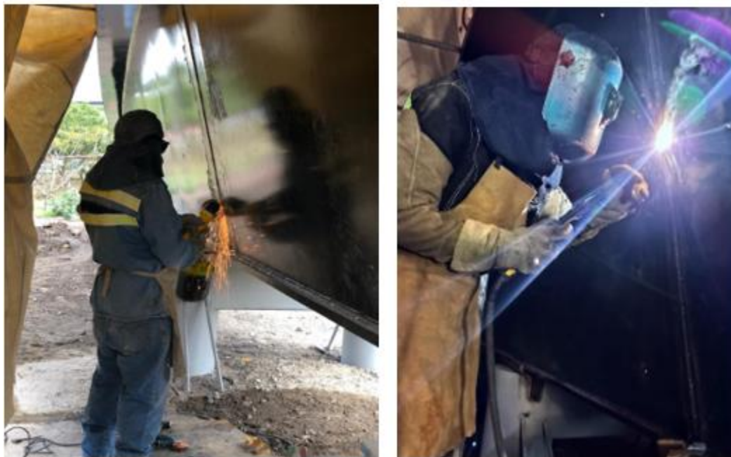
Figura 43. Reparación de defectos encontrados en la inspección por UT
