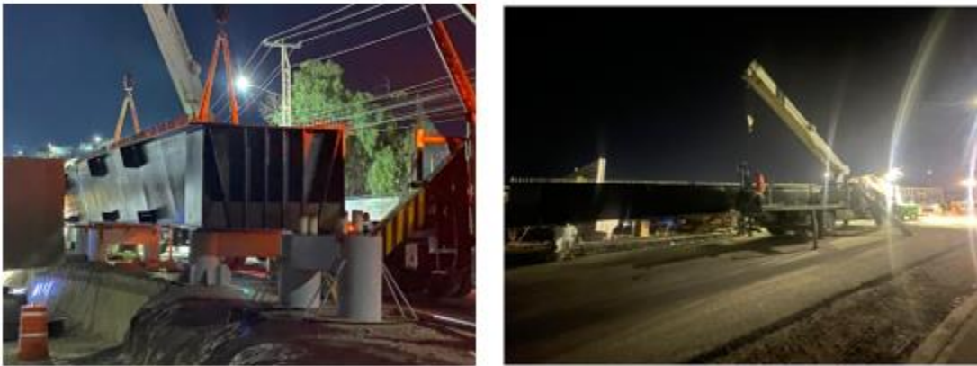
Figura 32. Conformación de trabe 3-4 intradós
