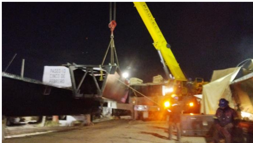
Figura 34. Conformado de trabe 2-3 intradós
