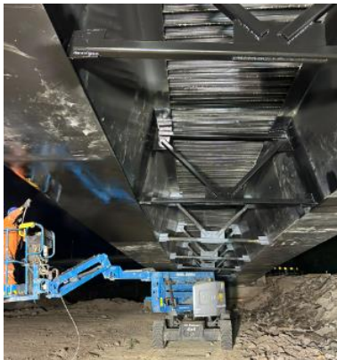
Figura 57. Resane de pintura en traveses metálicas con ayuda de plataforma de elevación
