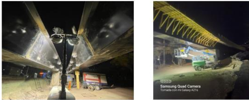
Figura 11. Torres de iluminación
