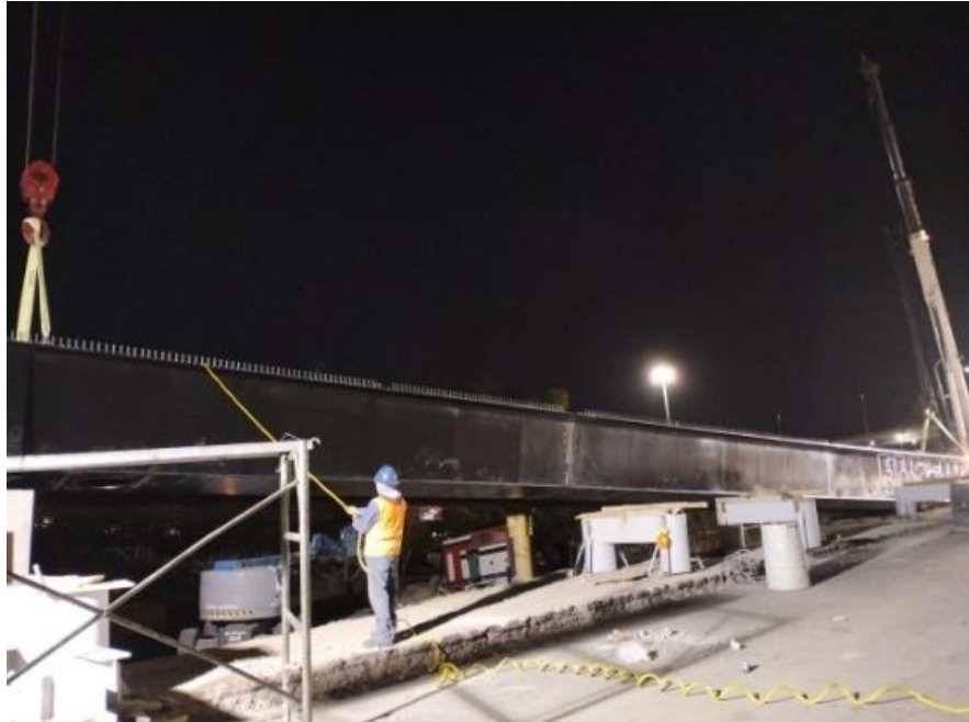
Figura 46. Montaje de trabe intradós 3-4
