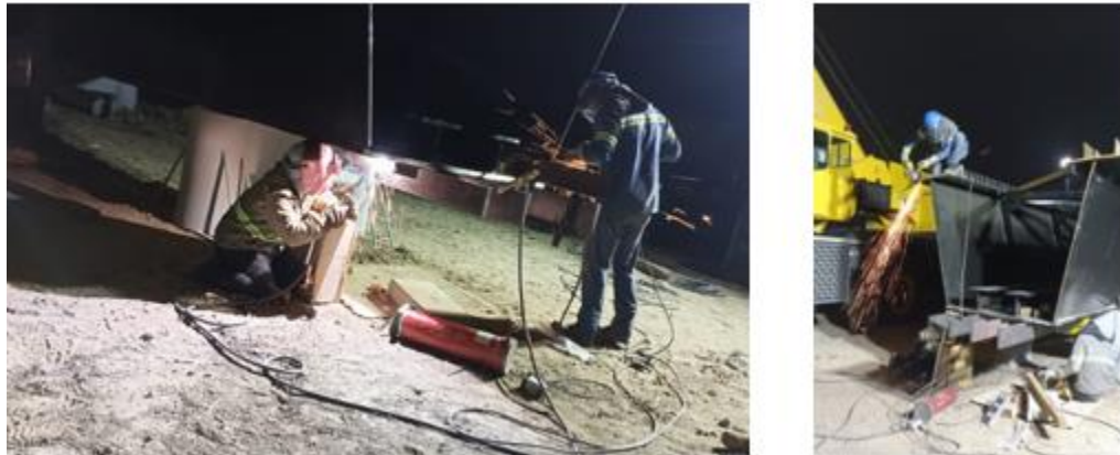
Figura 26. Limpieza mecánica en biseseles
