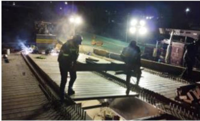
Figura 9. Colocación de montenes sobre traves metálicas
