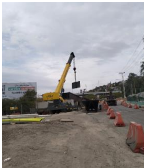
Figura 51. Montaje de cabezales entre traveses
