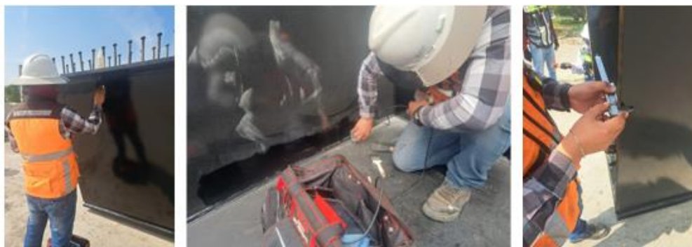
Figura 24. Pruebas no destructivas por parte de la supervisión externa
