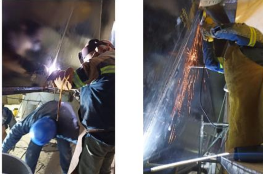
Figura 39. Aplicación de vista en almas derecha e izquierda
