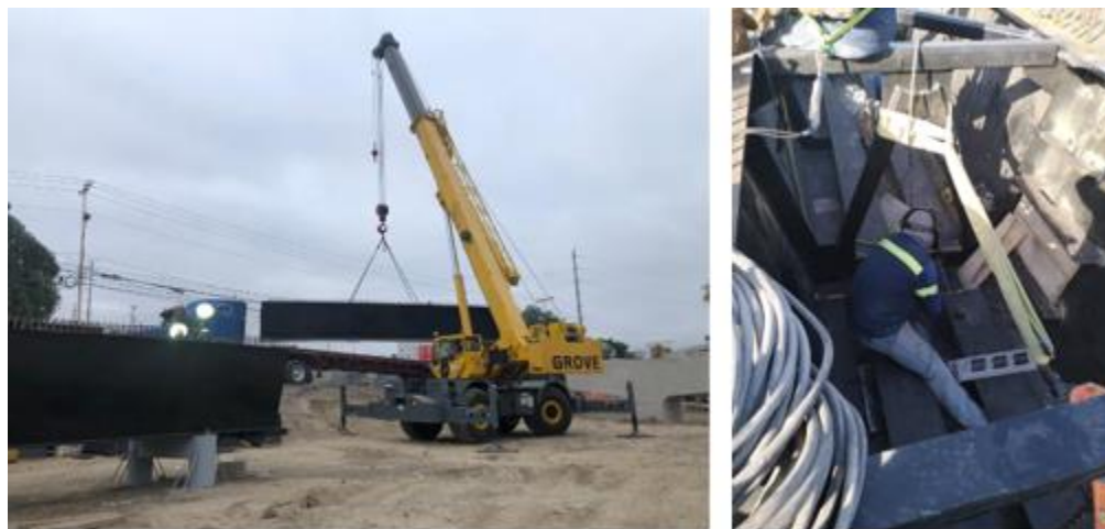
Figura 27. Ensamble de secciones de traveses
