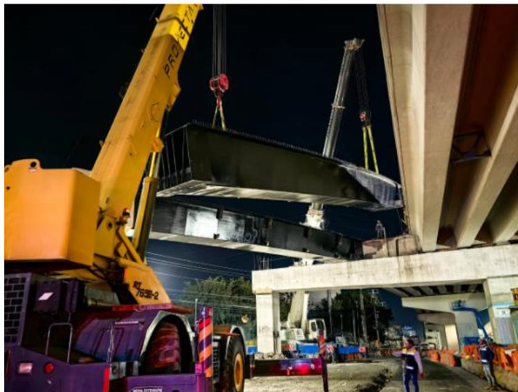
Figura 49. Montaje de traves del claro 1-2
