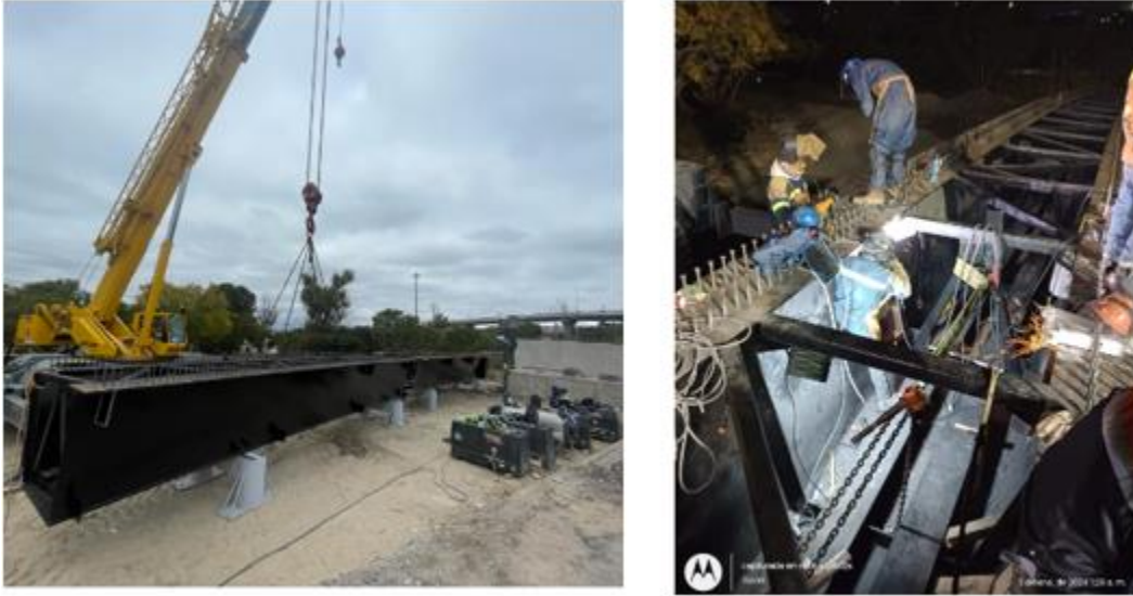
Figura 31. Conformación de trabe 3-4 extradós
