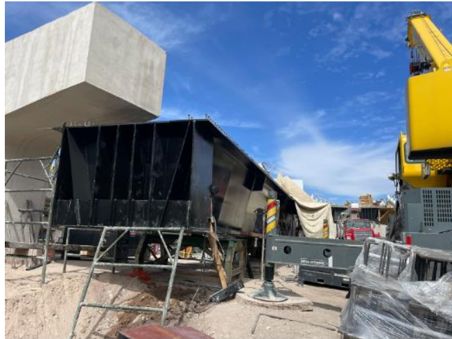
Figura 33. Conformado de trabe 2-3 extradós
