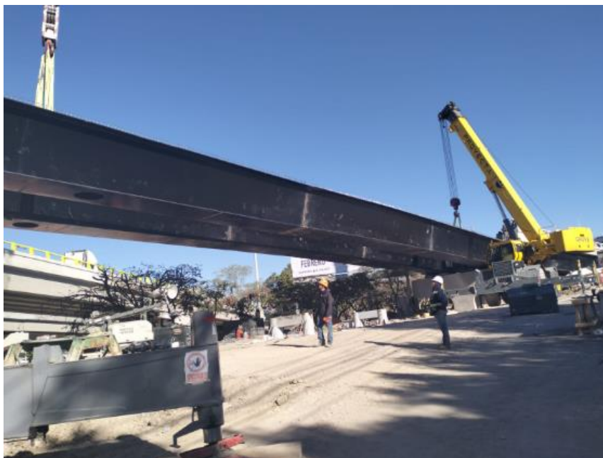
Figura 50. Montaje de traves del claro 2-3
