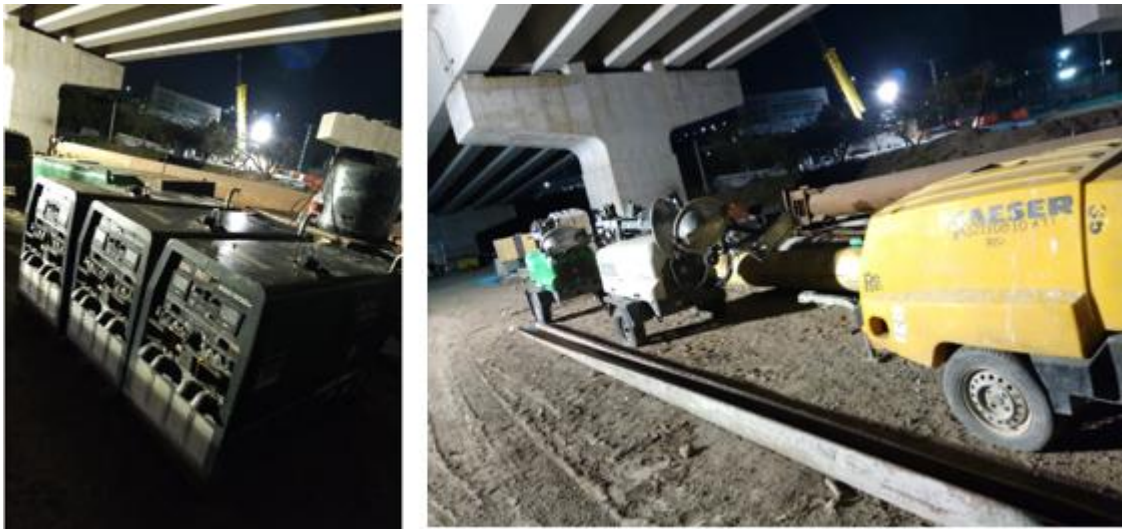
Figura 14. Máquinas de soldar y compresor portátil
