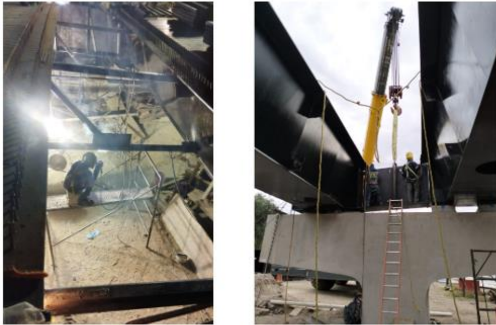
Figura 7. Cabezales entre traves y diafragmas intermedios
