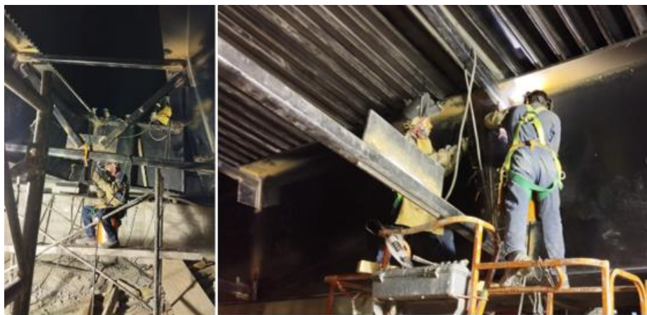
Figura 52. Montaje de diafragmas intermedios
