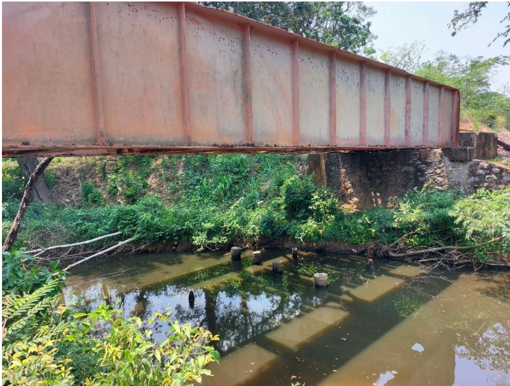
Foto 7. Cauce debajo del Puente 2
