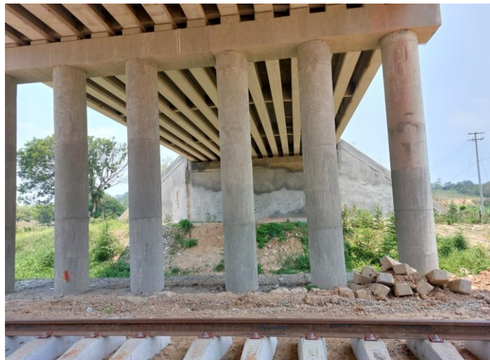
Foto 3. Cauce y pilas del Puente 1
