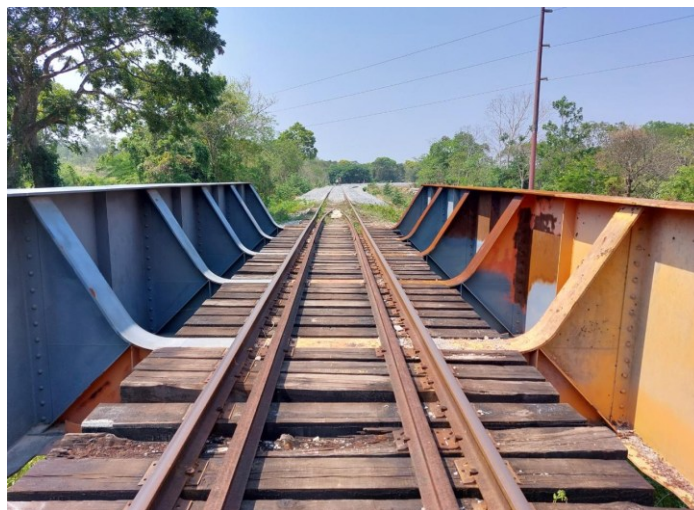
Foto 4. Vías férreas sobre el Puente 2
