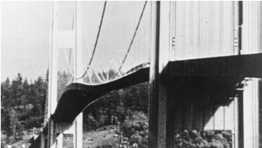
Figura 1. Puente Tacoma Narrow antes del colapso (Yablonski, 2021).
