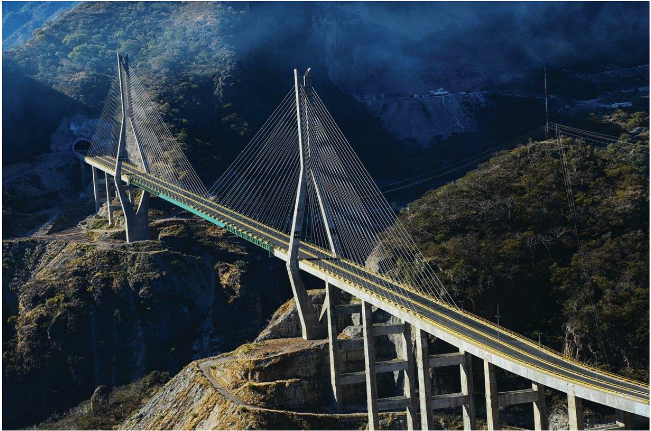
Figura 15. Puente Atirantado “Puente Baluarte” (Warrick, 2012).
