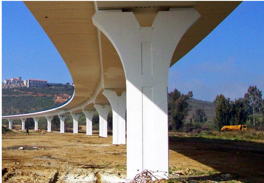
Figura 7. Elemento de pila (Ingeniería por el mundo, 2014).
