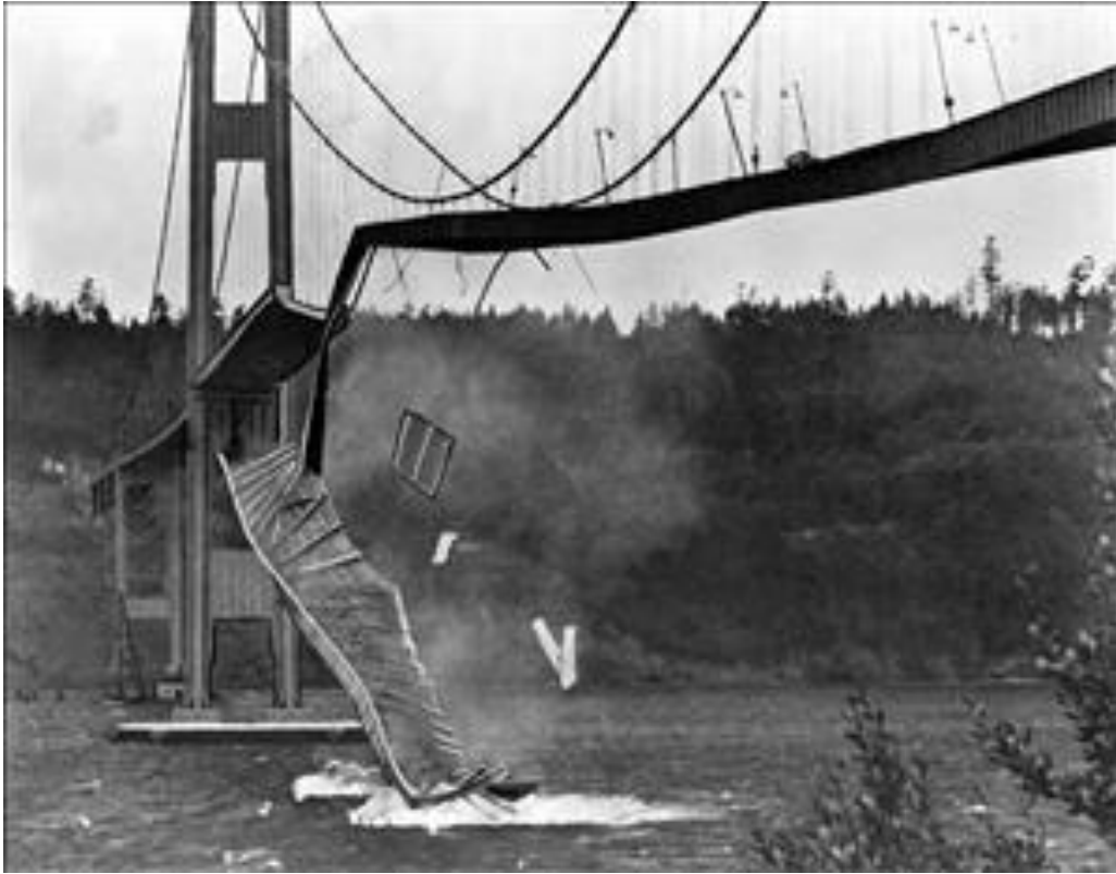
Figura 2. Derrumbe del Puente Tacoma Narrow (Long, 2003).
