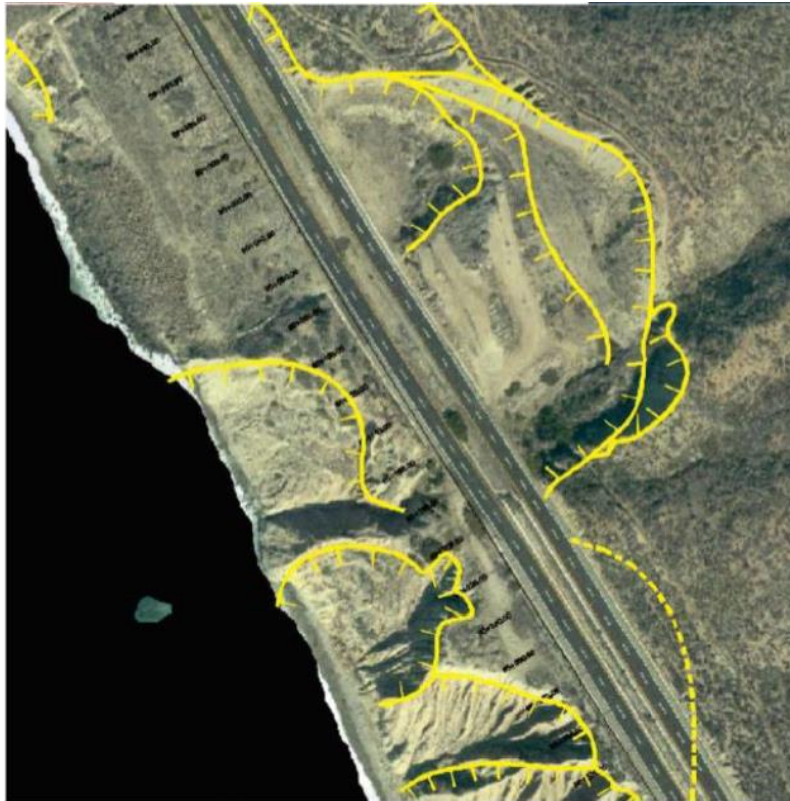
Imagen 6. Superficies de falla en los km 88+000-90+000 de la carretera (TGC S.A de C.V, 2015)
