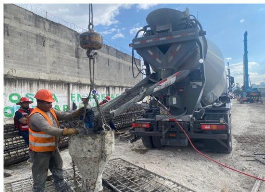
Imagen 71 y 72 Autoría Propia (2023) "Vertido de concreto f'c 250 kg/cm 2 en pilas de cimentación"
