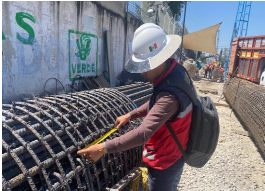
Imagen 178 y 179 Autoría Propia (2023) "Supervisión de armado de acero y tubería para pruebas de integridad"
