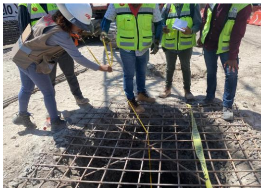
Imagen 54 y 55 Autoría Propia (2023) "Vista de trabajos de sondeo y verificación de profundidad de desplante en pilas de cimentación"
