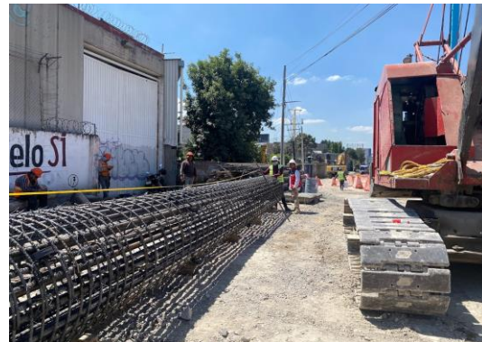
Imagen 180 y 181 Autoría Propia (2023) "Medición para la revisión de longitud efectiva en pila de cimentación"
