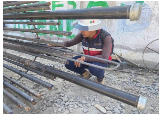
Imagen 178 y 179 Autoría Propia (2023) "Supervisión de armado de acero y tubería para pruebas de integridad"
