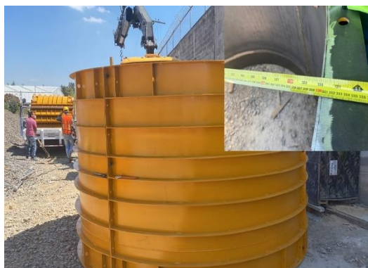
Imagen 117 y 118 Autoría Propia (2023) "Suministro y verificación de cimbra metálica para columna"
