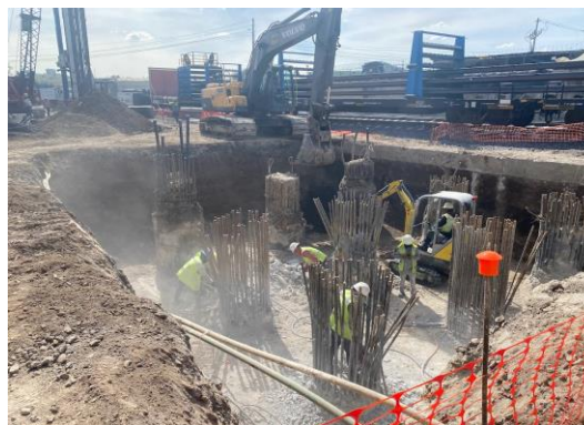
Imagen 73 y 74 Autoría Propia (2023) "Vista de los trabajos de excavación y descabece en pilas de cimentación"
