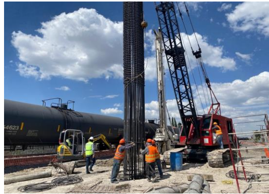
Imagen 60 y 61 Autoría Propia (2023) "Vista de los trabajos de izaje, acoplamiento y colocación de estribos para pilas de cimentación mayores a 20 metros de longitud"
