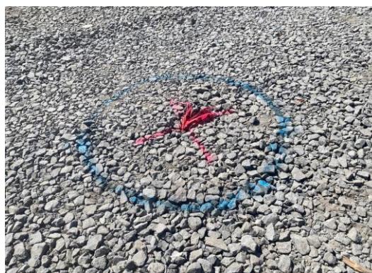
Imagen 50 y 51 Autoría Propia (2023) "Vista de verificación topográfica de supervisión para pilas de cimentación con estación total y trazo en campo para perforación"
