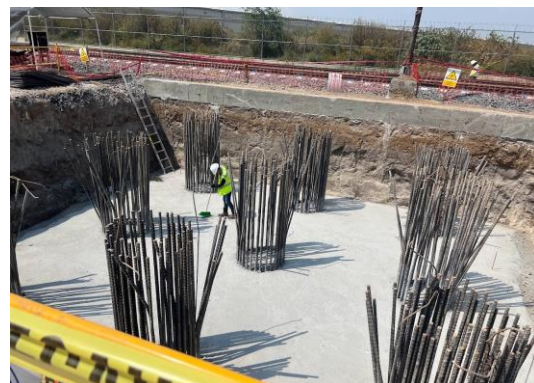
Imagen 88 y 89 Autoría Propia (2023) "Vista de plantilla de concreto pobre para inicio de estribado y armado de acero de zapatas de repartición"
