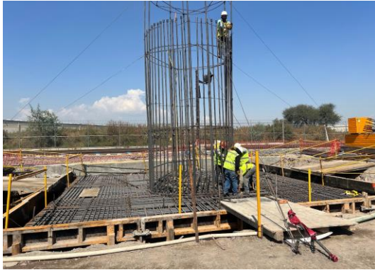
Imagen 119 y 120 Autoría Propia (2023) "Vista de trabajos de armado de acero para columna"
