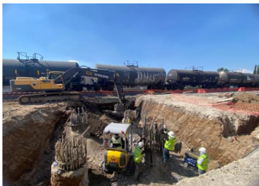
Imagen 73 y 74 Autoría Propia (2023) "Vista de los trabajos de excavación y descabece en pilas de cimentación"
