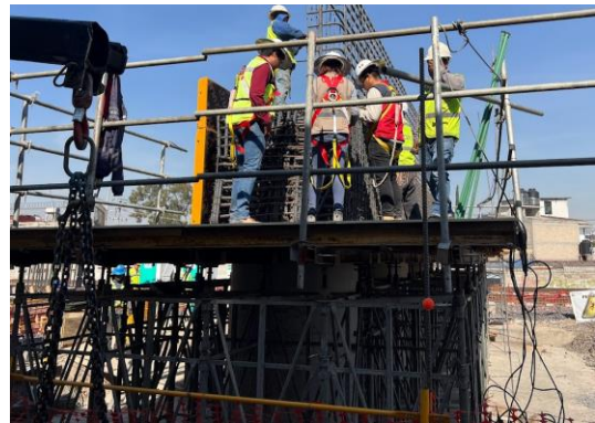
Imagen 194 y 195 Autoría Propia (2023) "Revisión y vista armado superior en columnas de caballetes (estribos)"
