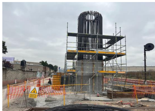
Imagen 129 Y 130 Autoría Propia (2023) "Vista de descimbrado de apoyos en diferentes trepados"
