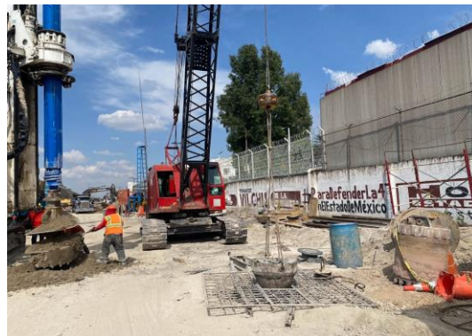
Imagen 65 y 66 Autoría Propia (2023) "Trabajos de armado y colocación de tubería Tremie para colado de pilas"
