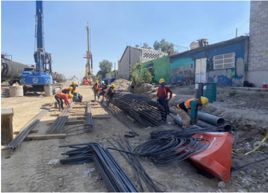
Imagen 184 y 185 Autoría Propia (2023) "Verificación de longitud efectiva de pila y espaciamiento de acero transversal"
