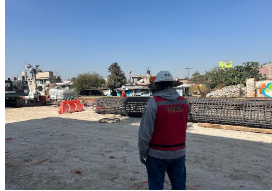
Imagen 172 y 173 Autoría Propia (2023) "Vista general de la verificación de marcaje para perforación de pilas de cimentación"
