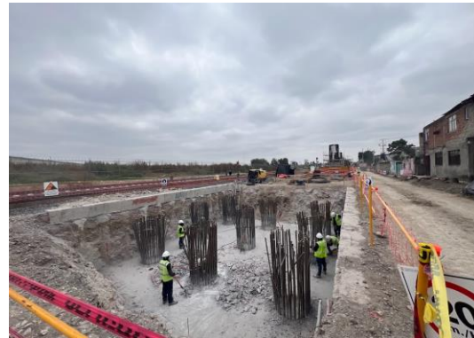
Imagen 95 y 96 Autoría Propia (2023) "Vista de trabajos de excavación, sistema de contención de pilas secantes y traves de liga en ambos lados"
