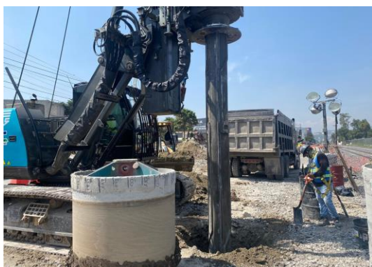
Imagen 52 y 53 Autoría Propia (2023) "Vista de trabajos de perforación para pilas de cimentación en Apoyo 23 y Apoyo 22"
