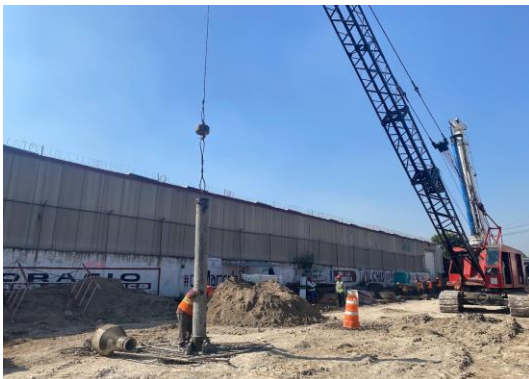
Imagen 65 y 66 Autoría Propia (2023) "Trabajos de armado y colocación de tubería Tremie para colado de pilas"
