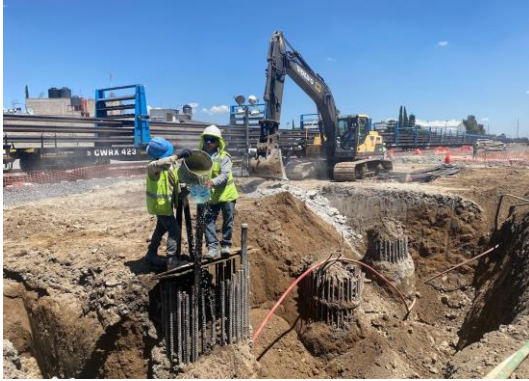
Imagen 78 y 79 Autoría Propia (2023) "Suministro de agua en tubos y ejecución de pruebas Cross Hole en pilas de cimentación mayores a 20 metros de profundidad"
