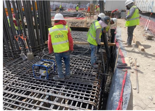
Imagen 108 y 109 Autoría Propia (2023) "Vaciado y vibrado de concreto premezclado para zapata"
