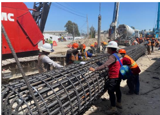
Imagen 182 y 183 Autoría Propia (2023) "Verificación de espaciamientos y conectores mecánicos en pilas de más de 20 metros de longitud"
