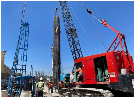
Imagen 60 y 61 Autoría Propia (2023) "Vista de los trabajos de izaje, acoplamiento y colocación de estribos para pilas de cimentación mayores a 20 metros de longitud"
