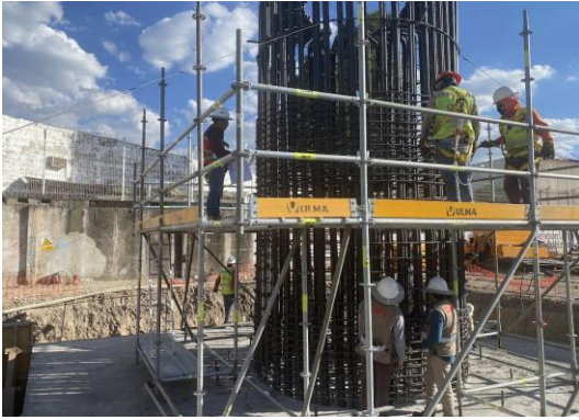
Imagen 190 y 191 Autoría Propia (2023) "Supervisión de armado de acero en columnas de apoyos intermedios, conectores mecánicos y verticalidad del elemento"
