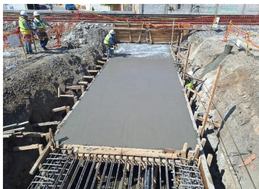
Imagen 170 y 171 Dozzer Construcción y Asesoría (2023) "Vista de trabajos de obras inducidas (cajón de alcantarilla)"
