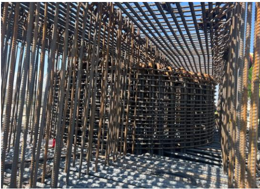
Imagen 192 y 193 Autoría Propia (2023) "Revisión y vista de la colocación de estribos restantes dentro del área de cabeza"
