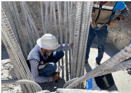
Imagen 80 y 81 Autoría Propia (2023) "Trabajos de supervisión en pruebas de integridad PIT"
