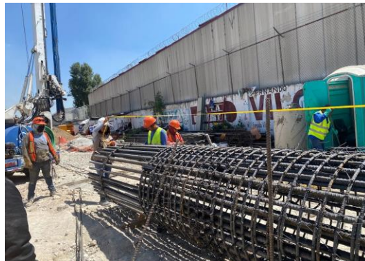
Imagen 180 y 181 Autoría Propia (2023) "Medición para la revisión de longitud efectiva en pila de cimentación"
