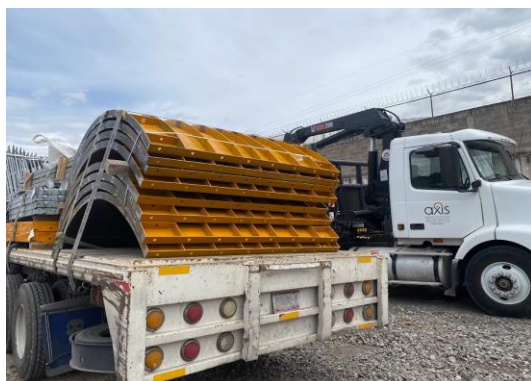
Imagen 117 y 118 Autoría Propia (2023) "Suministro y verificación de cimbra metálica para columna"
