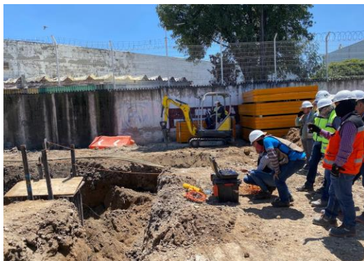
Imagen 76 y 77 Autoría Propia (2023) "Ejecución de pruebas Cross Hole en pilas de cimentación mayores a 20 metros de profundidad"
