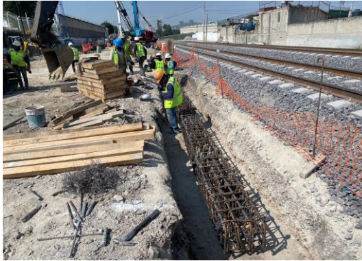
Imagen 93 y 94 Autoría Propia (2023) "Vista de trabajos de armado de acero, cimbrado y colocación de concreto en trabe de liga"
