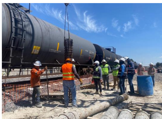
Imagen 91 y 92 Autoría Propia (2023) "Vista de trabajos de perforación e izaje de acero para pilas secantes"
