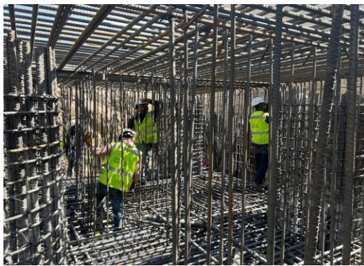
Imagen 186 y 187 Autoría Propia (2023) "Vista y revisión interna de armado de acero y recubrimiento inferior en zapatas de repartición"
