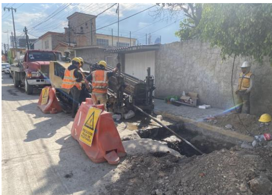
Imagen 168 y 169 Autoría Propia (2023) "Vista de trabajos de obras inducidas (fibra óptica)"
