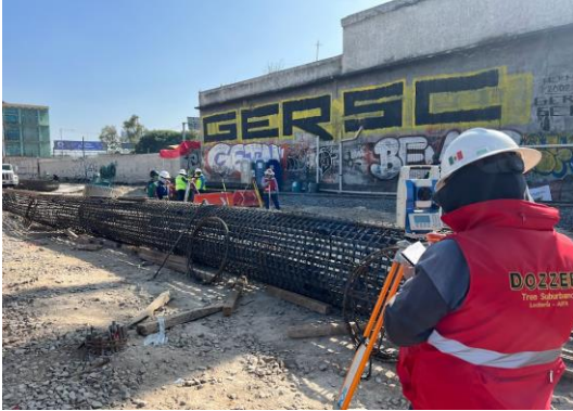
Imagen 172 y 173 Autoría Propia (2023) "Vista general de la verificación de marcaje para perforación de pilas de cimentación"
