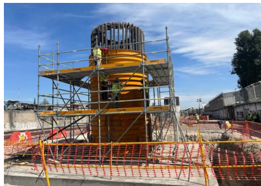
Imagen 123 y 124 Autoría Propia (2023) "Vista de los trabajos de colocación y aseguramiento de cimbra para columnas de apoyos intermedios."
