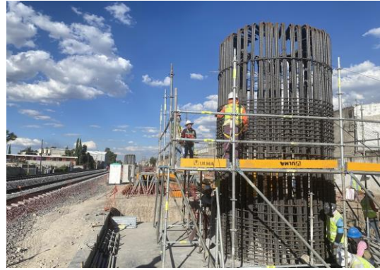
Imagen 190 y 191 Autoría Propia (2023) "Supervisión de armado de acero en columnas de apoyos intermedios, conectores mecánicos y verticalidad del elemento"
