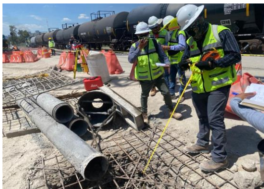
Imagen 54 y 55 Autoría Propia (2023) "Vista de trabajos de sondeo y verificación de profundidad de desplante en pilas de cimentación"
