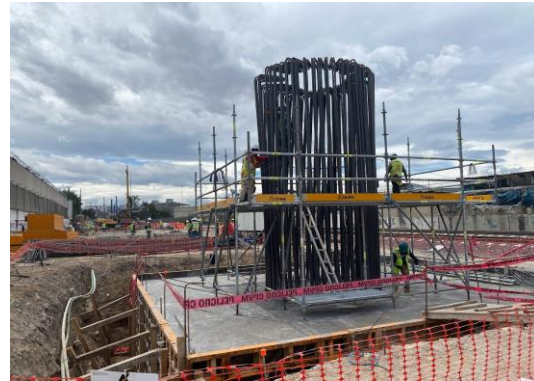
Imagen 110 y 111 Autoría Propia (2023) "Vista del terminado del colado en zapata y colocación de andamios"
