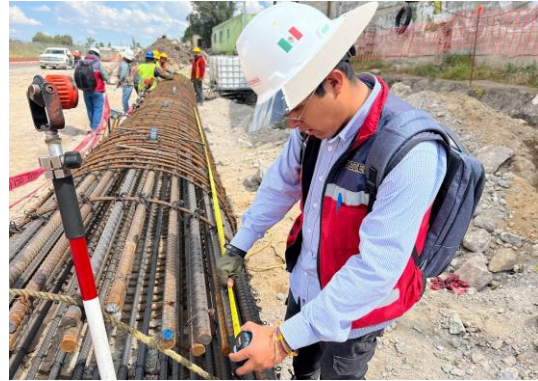
Imagen 184 y 185 Autoría Propia (2023) "Verificación de longitud efectiva de pila y espaciamiento de acero transversal"
