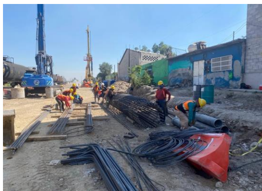
Imagen 56 y 57 Autoría Propia (2023) "Suministro de acero de refuerzo (Estribos y acero longitudinal) y Maxi light para el armado de pilas de cimentación"
