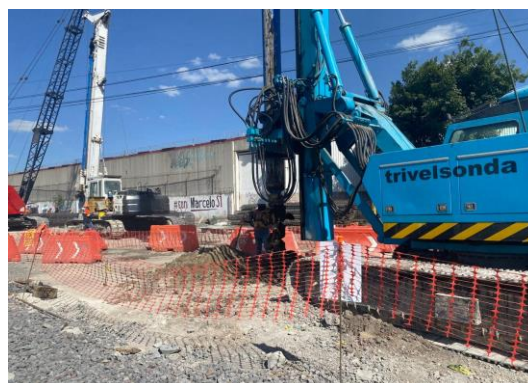
Imagen 52 y 53 Autoría Propia (2023) "Vista de trabajos de perforación para pilas de cimentación en Apoyo 23 y Apoyo 22"
