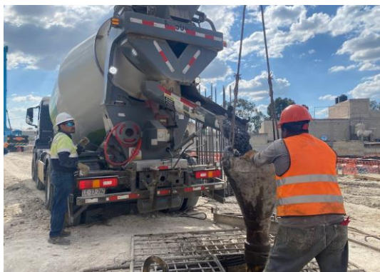
Imagen 71 y 72 Autoría Propia (2023) "Vertido de concreto f'c 250 kg/cm 2 en pilas de cimentación"
