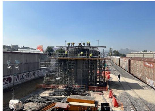
Imagen 192 y 193 Autoría Propia (2023) "Revisión y vista de la colocación de estribos restantes dentro del área de cabeza"
