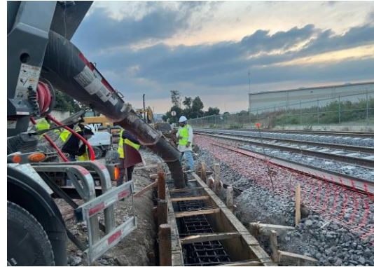
Imagen 93 y 94 Autoría Propia (2023) "Vista de trabajos de armado de acero, cimbrado y colocación de concreto en trabe de liga"
