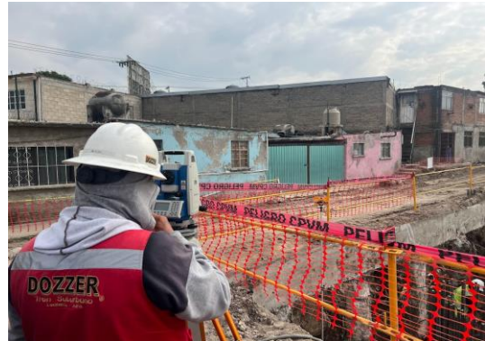
Imagen 174 y 175 Autoría Propia (2023) "Vista general de los trabajos de revisión de replanteo para zapatas de repartición"
