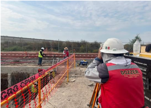
Imagen 174 y 175 Autoría Propia (2023) "Vista general de los trabajos de revisión de replanteo para zapatas de repartición"
