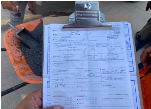
Imagen 67 y 68 Autoría Propia (2023) "Vista de hoja de remisión y toma de muestra para prueba de revenimiento"
