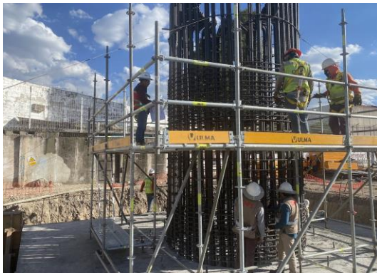
Imagen 121 y 122 Autoría Propia (2023) "Supervisión de armado de acero en columnas de apoyos intermedios"
