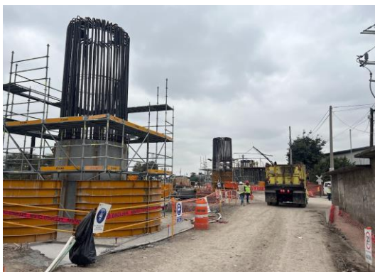
Imagen 129 Y 130 Autoría Propia (2023) "Vista de descimbrado de apoyos en diferentes trepados"
