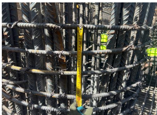
Imagen 103 y 104 Autoría Propia (2023) "Supervisión de estribos restantes en pilas de cimentación, estribos en zapatas, recubrimiento inferior y diámetros de varilla"
