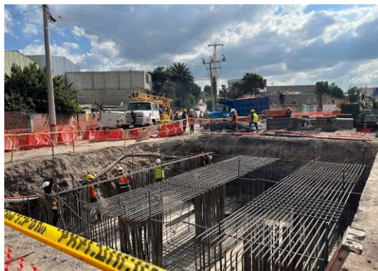
Imagen 101 y 102 Autoría Propia (2023) "Vista de los trabajos de armado de acero en zapatas de Apoyos Intermedios"
