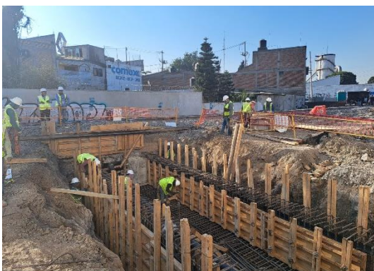
Imagen 170 y 171 Dozzer Construcción y Asesoría (2023) "Vista de trabajos de obras inducidas (cajón de alcantarilla)"
