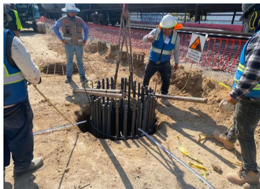
Imagen 62 y 63 Autoría Propia (2023) "Vista de bastones en orejas de pila para maniobras de colocación del segundo tramo y vista de verificación topográfica de recubrimiento inferior"
