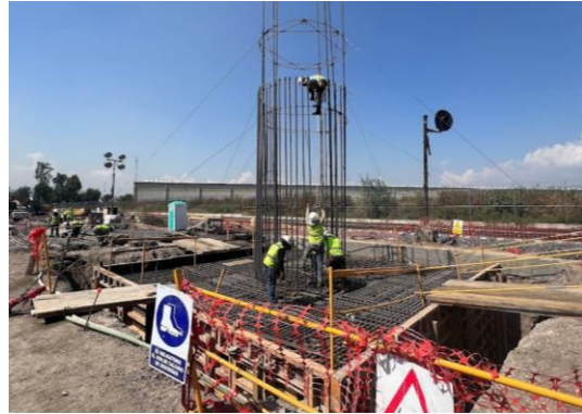
Imagen 119 y 120 Autoría Propia (2023) "Vista de trabajos de armado de acero para columna"
