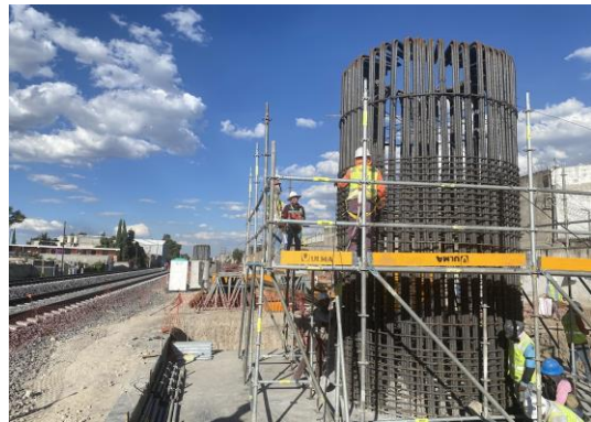
Imagen 121 y 122 Autoría Propia (2023) "Supervisión de armado de acero en columnas de apoyos intermedios"
