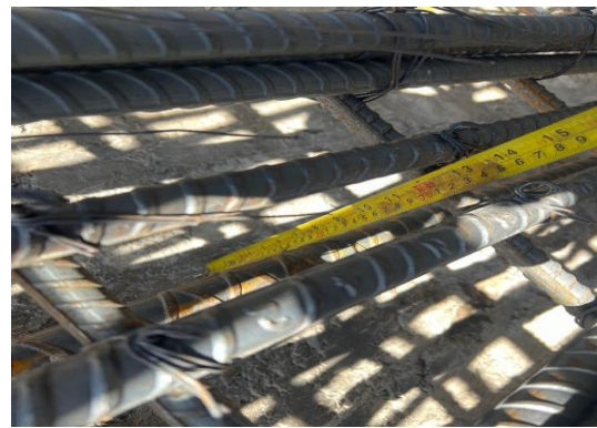
Imagen 186 y 187 Autoría Propia (2023) "Vista y revisión interna de armado de acero y recubrimiento inferior en zapatas de repartición"
