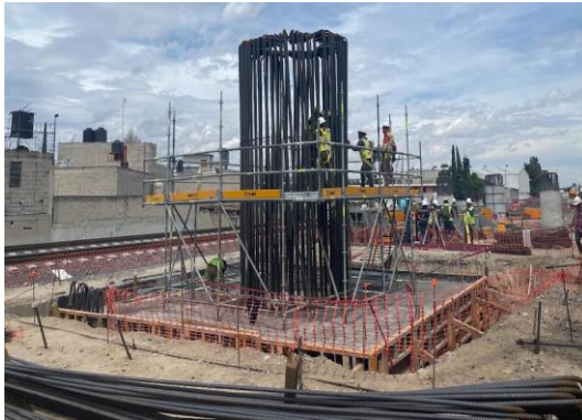
Imagen 110 y 111 Autoría Propia (2023) "Vista del terminado del colado en zapata y colocación de andamios"
