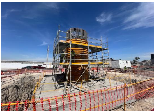
Imagen 123 y 124 Autoría Propia (2023) "Vista de los trabajos de colocación y aseguramiento de cimbra para columnas de apoyos intermedios."
