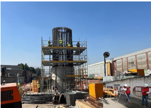
Imagen 176 y 177 Autoría Propia (2023) "Vista general de los trabajos de revisión de verticalidad en columnas"
