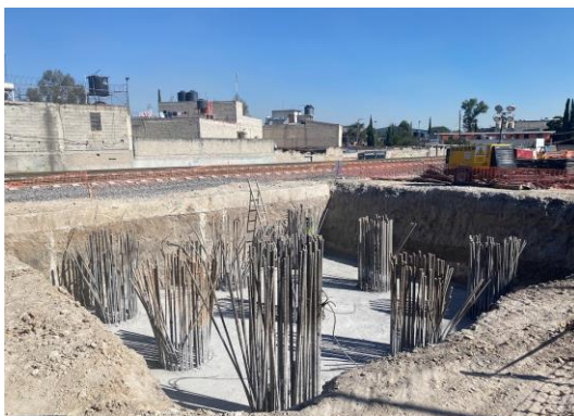
Imagen 88 y 89 Autoría Propia (2023) "Vista de plantilla de concreto pobre para inicio de estribado y armado de acero de zapatas de repartición"
