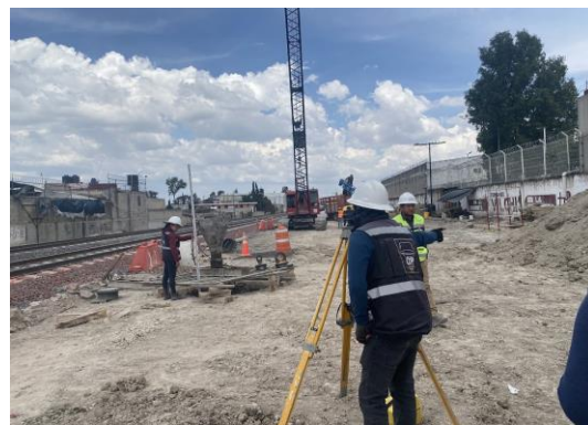
Imagen 62 y 63 Autoría Propia (2023) "Vista de bastones en orejas de pila para maniobras de colocación del segundo tramo y vista de verificación topográfica de recubrimiento inferior"
