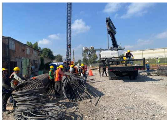
Imagen 56 y 57 Autoría Propia (2023) "Suministro de acero de refuerzo (Estribos y acero longitudinal) y Maxi light para el armado de pilas de cimentación"
