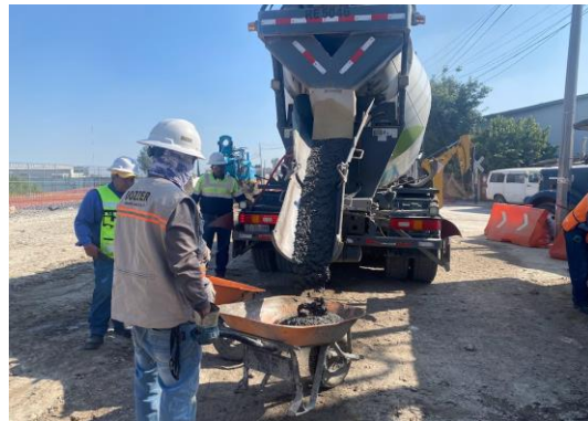
Imagen 67 y 68 Autoría Propia (2023) "Vista de hoja de remisión y toma de muestra para prueba de revenimiento"
