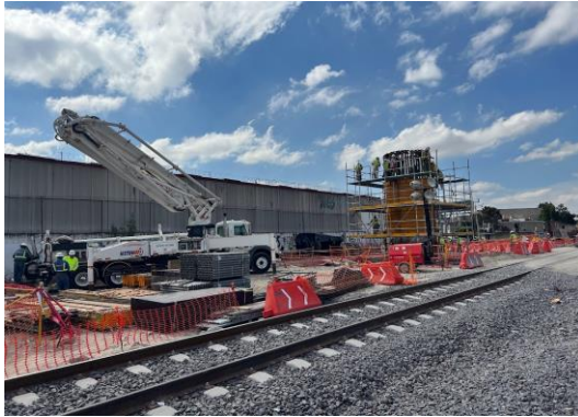
Imagen 127 y 128 Autoría Propia (2023) "Vista de posicionamiento de bomba de concreto para columnas de apoyos intermedios"
