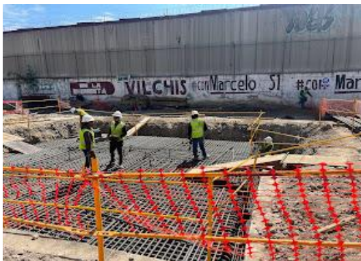
Imagen 188 y 189 Autoría Propia (2023) "Vista externa de los trabajos de armado de acero en zapata y varilla longitudinal para el armado de columna"
