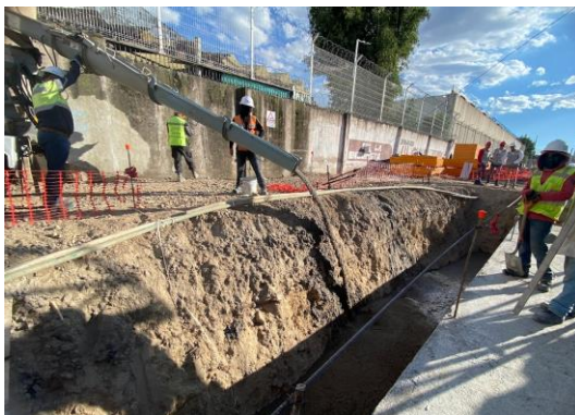
Imagen 112 y 113 Autoría Propia (2023) "Trabajos de relleno de aproche con material retirado y concreto fluido"
