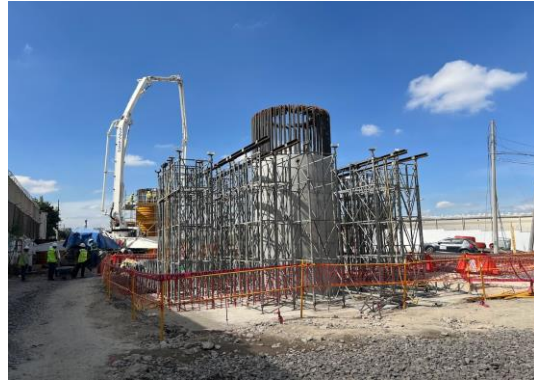
Imagen 127 y 128 Autoría Propia (2023) "Vista de posicionamiento de bomba de concreto para columnas de apoyos intermedios"
