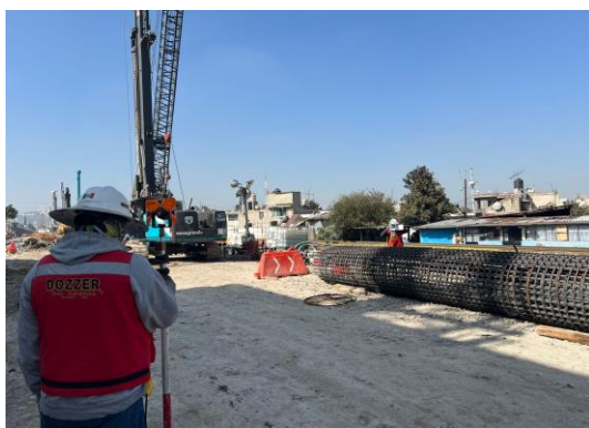
Imagen 50 y 51 Autoría Propia (2023) "Vista de verificación topográfica de supervisión para pilas de cimentación con estación total y trazo en campo para perforación"
