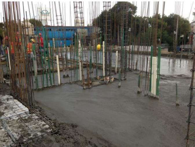
Fotografías V.2,40 a 45 Proceso de obra, vaciado, colocación tendido, vibrado y nivelado de concreto en etapas para traveses, nervaduras y losas, además de la disposición en vialidades del equipo de bombeo y las unidades de transporte del concreto
