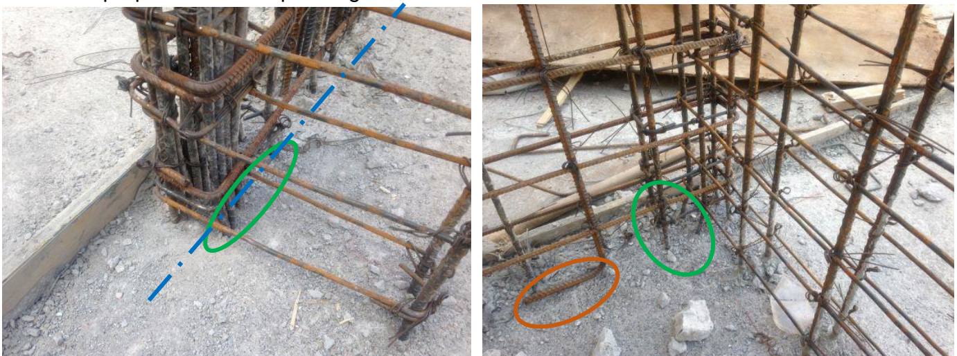
Fotografía V.2, 8 y 9 Acero bayoneteado para Corregir desplomes o desplantes de acuerdo al trazo definitivo
