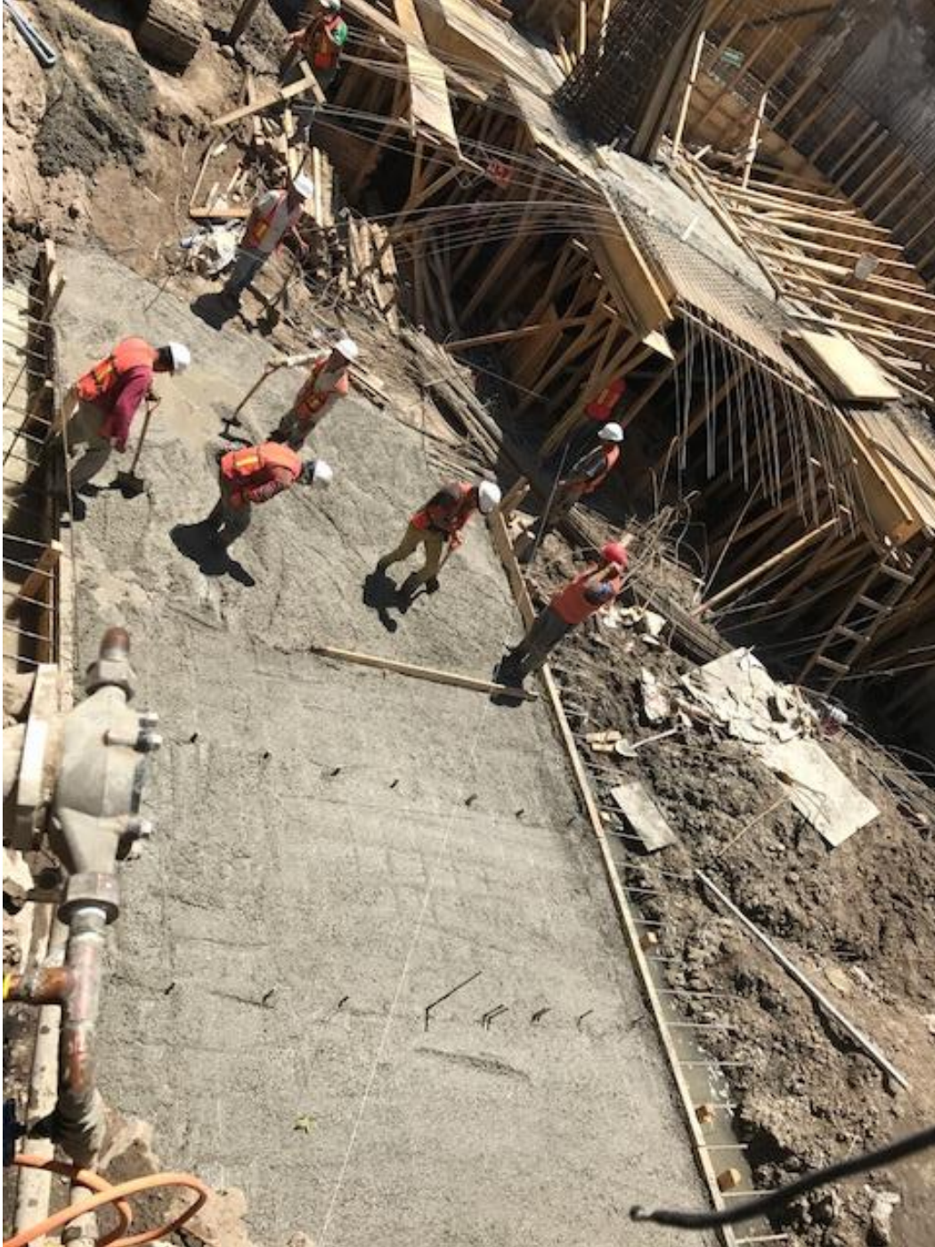
Fotografía V.2, 3 Trabajos de nivelación de terreno y control de aguas freáticas presentadas
