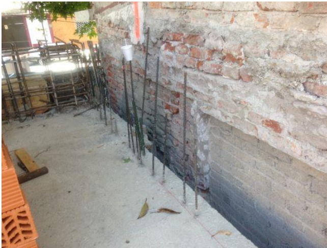
Fotografías V.2, 10 y 11 Acero mal desplantado y corrección a falla de cimbrado en muro vertical
