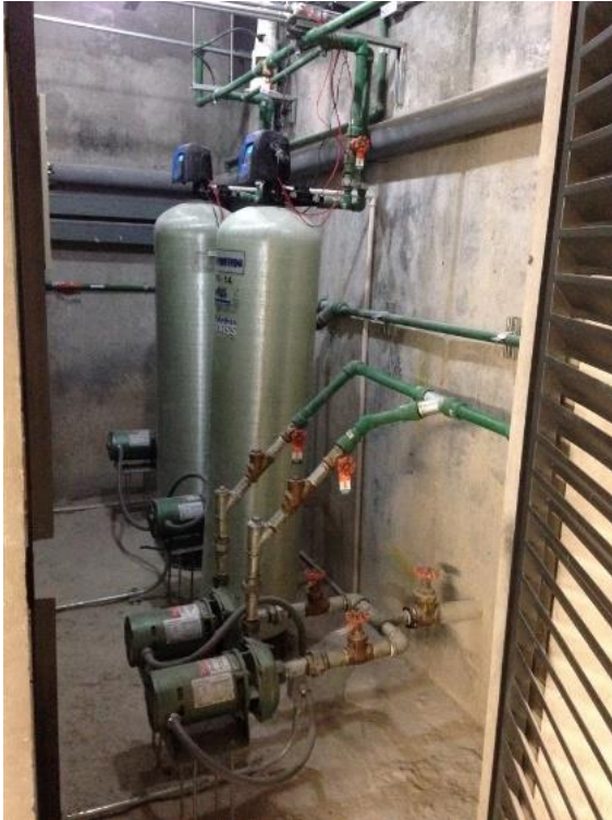
Fotografías V.2, 62 y 63 Equipo de bombeo y sistema de Tratamiento agua, pasos de cruce de instalaciones sanitaria (inmueble en estudio)
