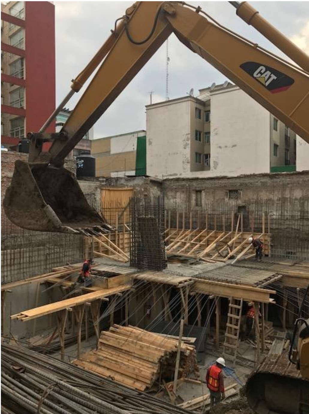
Fotografía V.2, 16, Proceso de obra, Debajo de nivel de banqueta con actividades alternando puntos de trabajo
