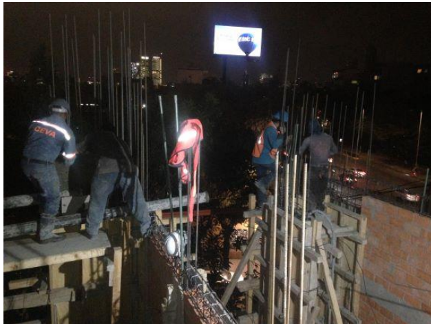
Fotografías V.2,46 a 52 Proceso de obra vaciado, colocación tendido, vibrado y nivelado de concreto en trabes y losa, en horario nocturno o fuera de horario hábil.
