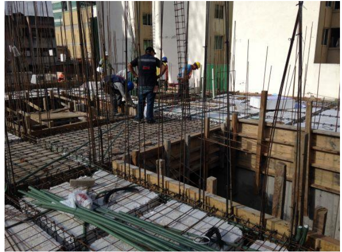
Fotografías V.2, 64 y 65 Tendido de material de instalaciones, dentro de losa, PVC Sanitario, PVC Conduit en lo eléctrico y Tuboflex para las líneas de la instalación hidráulica
