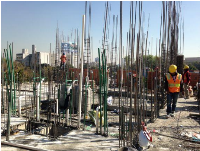
Fotografías V.2, 64 y 65 Tendido de material de instalaciones, dentro de losa, PVC Sanitario, PVC Conduit en lo eléctrico y Tuboflex para las líneas de la instalación hidráulica
