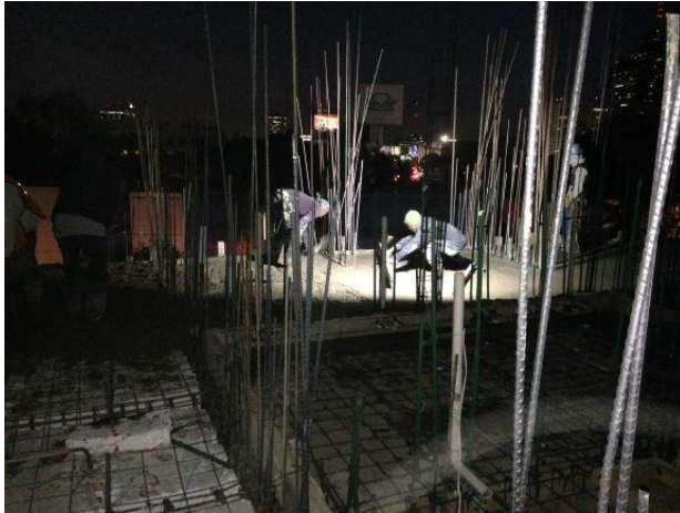
Fotografías V.2,46 a 52 Proceso de obra vaciado, colocación tendido, vibrado y nivelado de concreto en trabes y losa, en horario nocturno o fuera de horario hábil.
