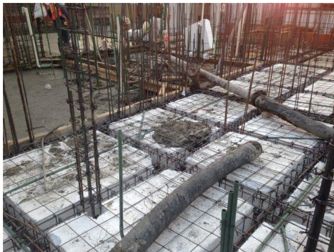
Fotografías V.2, 36 a 39 Proceso de obra, vaciado, colocación tendido, vibrado y nivelado de concreto en etapas para trabes, nervaduras y losas
