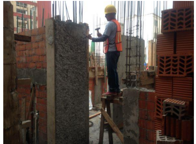
Fotografías V.2, 10 y 11 Acero mal desplantado y corrección a falla de cimbrado en muro vertical
