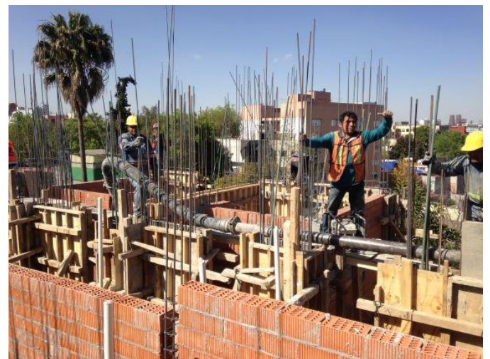
Fotografías V.2, 17 a 20, Proceso de obra, en especial muros de concreto con armado, cimbra y colado, tabique extruido
