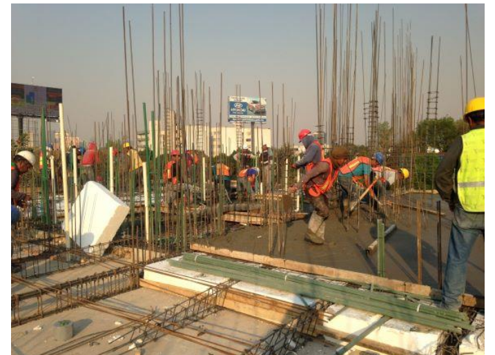
Fotografías V.2, 36 a 39 Proceso de obra, vaciado, colocación tendido, vibrado y nivelado de concreto en etapas para trabes, nervaduras y losas
