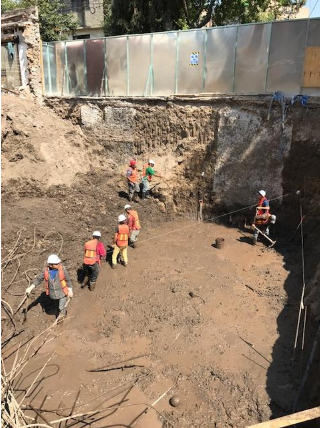
Fotografía V.2, 2 Trabajos de nivelación de terreno y control de aguas freáticas presentadas
