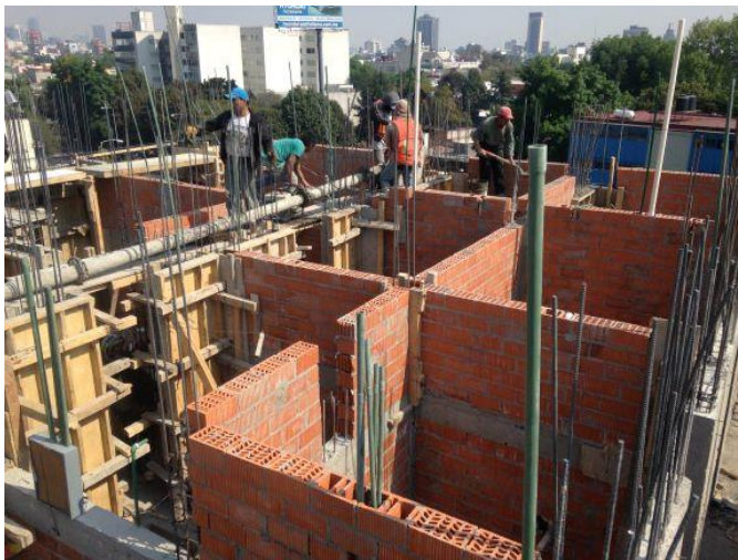
Fotografías V.2, 17 a 20, Proceso de obra, en especial muros de concreto con armado, cimbra y colado, tabique extruido
