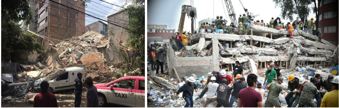
Fotografía 1 Colapsos Ocurridos después del Sismo [Fuente: Forbes México]
