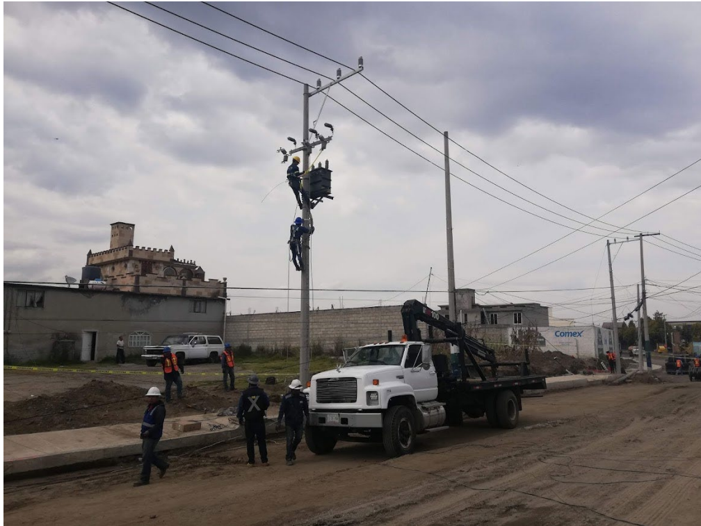
Foto 67. Colocación de transformador. Fuente propia
