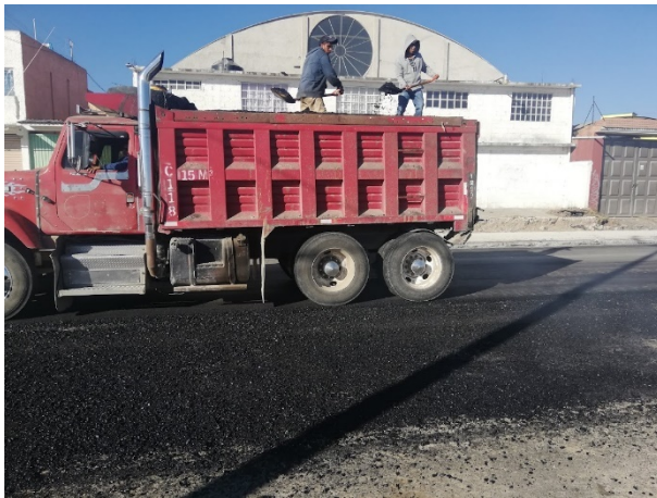
Foto 75. Manteo con asfalto. Fuente propia.
