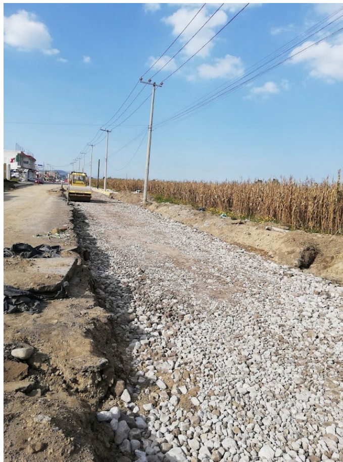
Foto 33. Compactación del pedraplén sobre el hombro izquierdo. Fuente propia.
