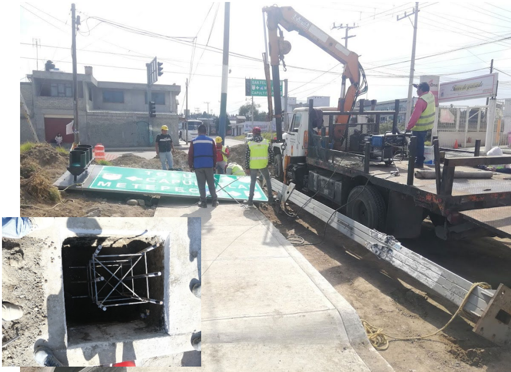
Foto 69. Instalación de letrero informativo tipo bandera. Fuente propia.
