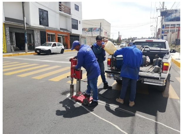
Foto 84. Extracción de núcleo en carpeta asfáltica. Fuente propia.
