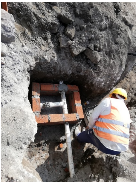
Foto 60. Se observa construcción de caja de válvulas. Fuente propia.
