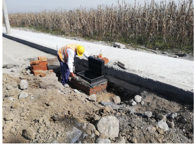
Foto 63. Colocación de tapa para rejilla pluvial. Fuente propia.
