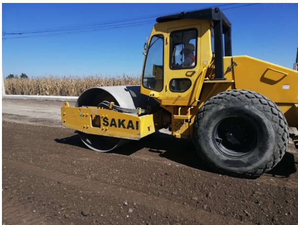
Foto 36 y 37. Conformación y Comparación de capa base. Fuente propia.
