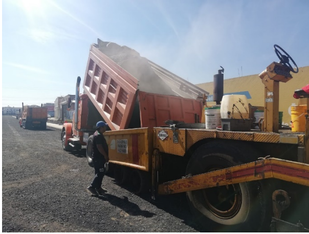
Foto 77. Llenado de tolva de finisher. Fuente propia.
