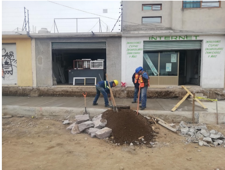
Foto 65. Excavación para la reubicación de postes. Fuente propia
