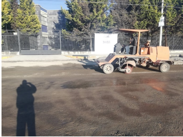
Foto 73. Barrido previo a colocación de carpeta. Fuente propia.
