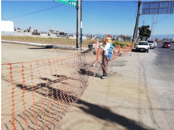
Foto 89. Delimitación de zona de trabajos. Fuente propia.
