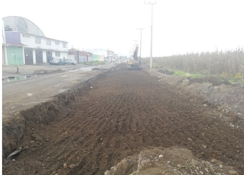
Foto 34. Caja sobre terreno natural del hombro izquierdo. Fuente propia.
