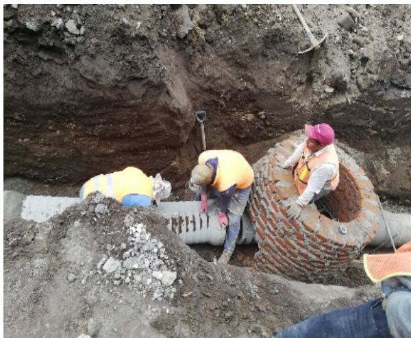
Foto 57 a la 58. Proceso de construcción de atarjeas. Fuente propia.
