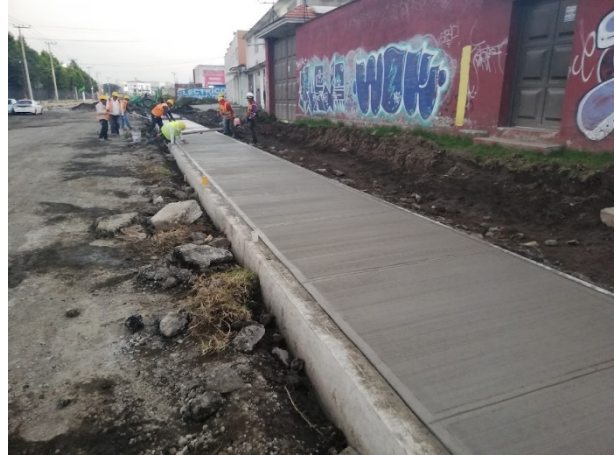
Foto 49. Acabado de banquetas. Fuente propia.
