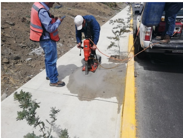
Foto 50. Extracción de núcleo en banquetas. Fuente propia.
