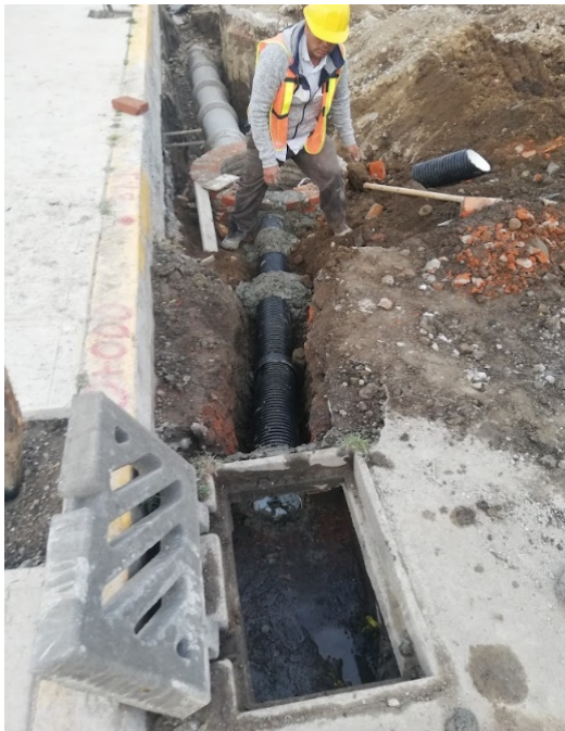
Foto 53 y 54. conexiones de tubo PAD. Fuente propia.
