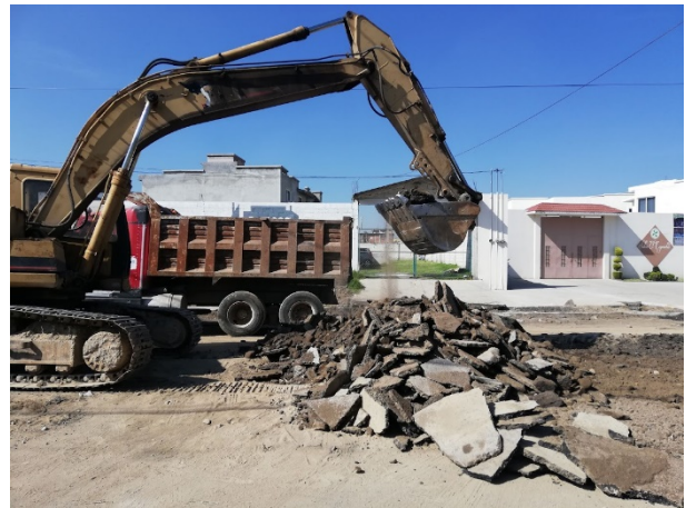
Foto 22 y 23. Demolición y carga de carpeta existente. Fuente propia.
