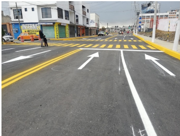
Foto 87. Proceso de colocación de pintura de tráfico. Fuente propia.
