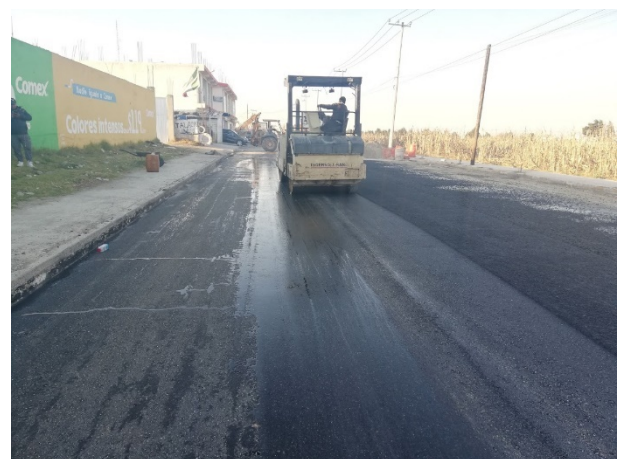
Foto 80. Compactación con rodillo doble. Fuente propia.
