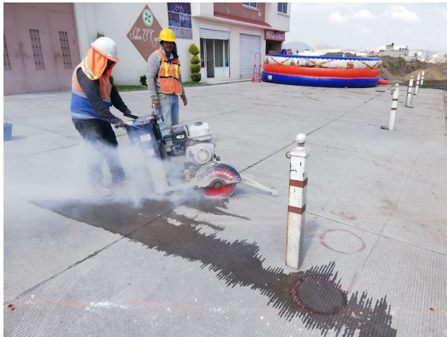
Foto 10. Av. Heriberto Enríquez frente a salón de fiestas privado, se observa firme de concreto y bolardos (hitos) metálicos colocados por el comercio. Fuente propia.
