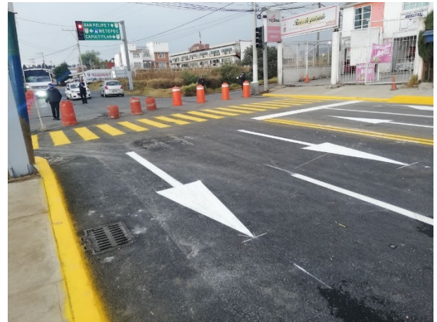
Foto 85 y 86. Trazo e inicio de pintado de señalamiento horizontal. Fuente propia.
