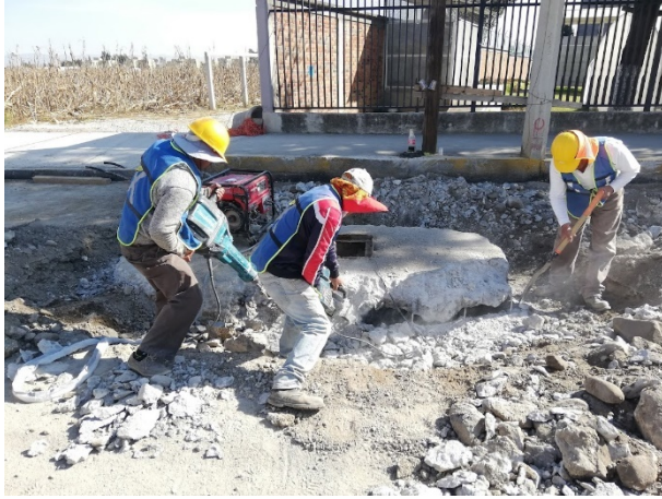
Foto 26, 27, 28 y 29. Proceso de demolición y reconstrucción de tapas de registros TELMEX. Fuente propia.
