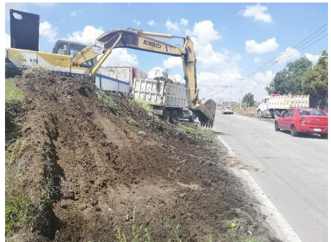
Foto 18 y 19. Despalme sobre hombros del proyecto. Fuente propia.
