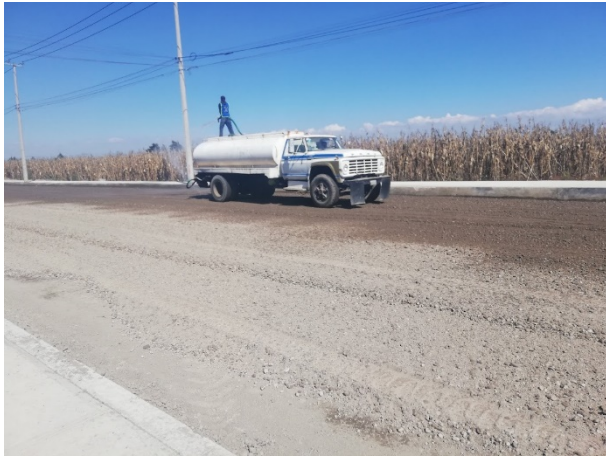
Foto 38. Riego de capa base. Fuente propia.
