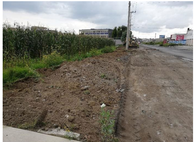
Foto 16 y 17. Despalme sobre hombros del proyecto. Fuente propia.
