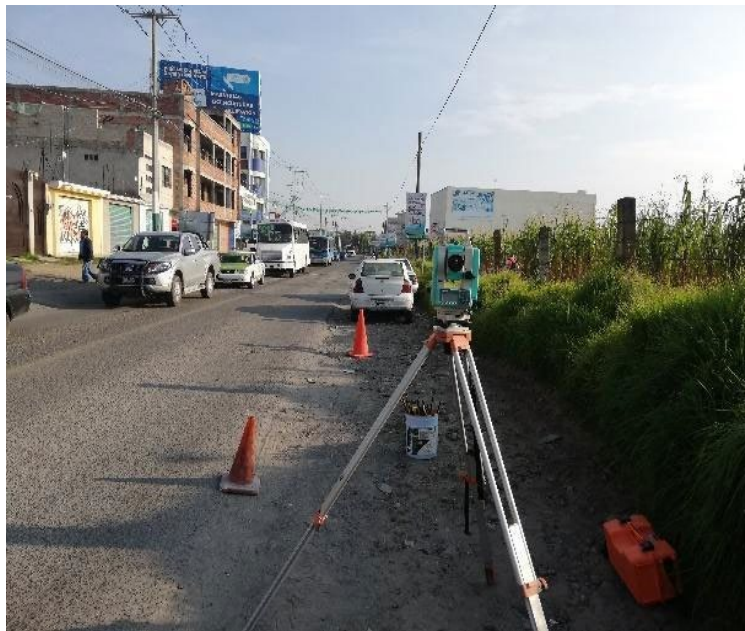
Foto 13. Trabajos topográficos, ubicación de trazo de proyecto con ayuda de estación total. Fuente propia.
