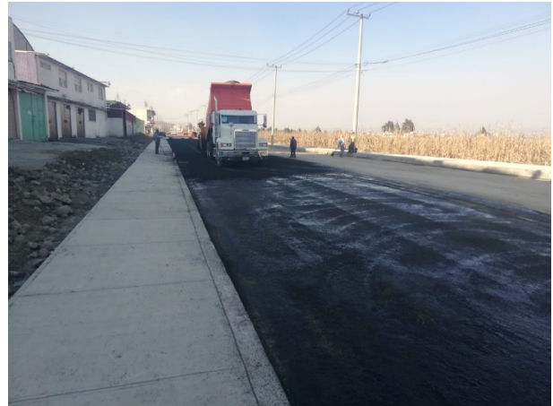
Foto 76. Manteo con asfalto. Fuente propia.
