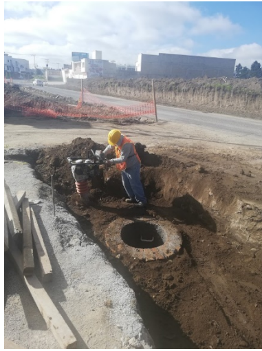
Foto 57 a la 58. Proceso de construcción de atarjeas. Fuente propia.
