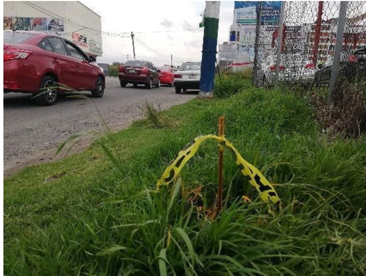
Foto 15. Varilla indicando trazo del Hombro. Fuente propia.
