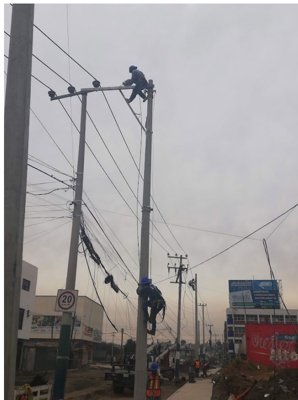
Foto 68. Colocación de nuevas líneas. Fuente propia
