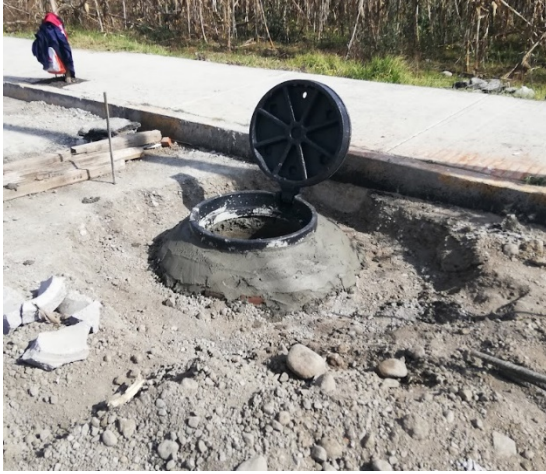
Foto 62. Colocación de brocal de neopreno en pozo de visita. Fuente
