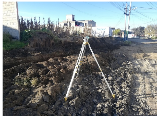
Foto 43. Nivelación de guarniciones. Fuente propia.
