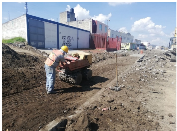
Foto 47. Compactación de TN para banquetas.
