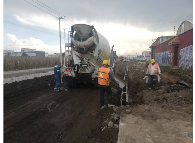
Foto 44 y 45. Colado de guarniciones con concreto premezclado. Fuente propia
