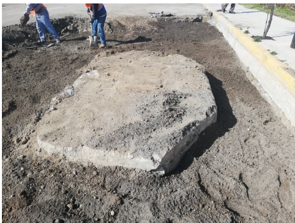
Foto 24 y 25. Identificación y demolición de tapas de registros TELMEX. Fuente propia.
