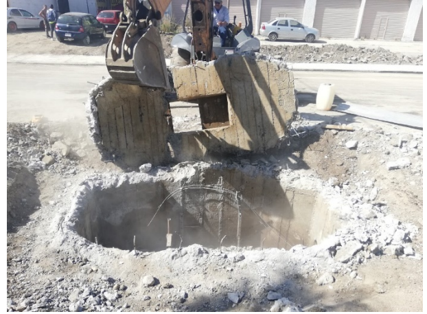
Foto 26, 27, 28 y 29. Proceso de demolición y reconstrucción de tapas de registros TELMEX. Fuente propia.
