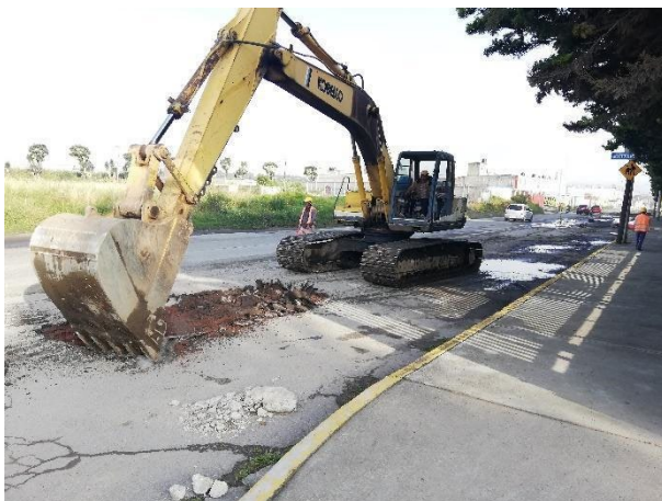
Foto 20 y 21. Demolición de carpeta existente. Fuente propia.
