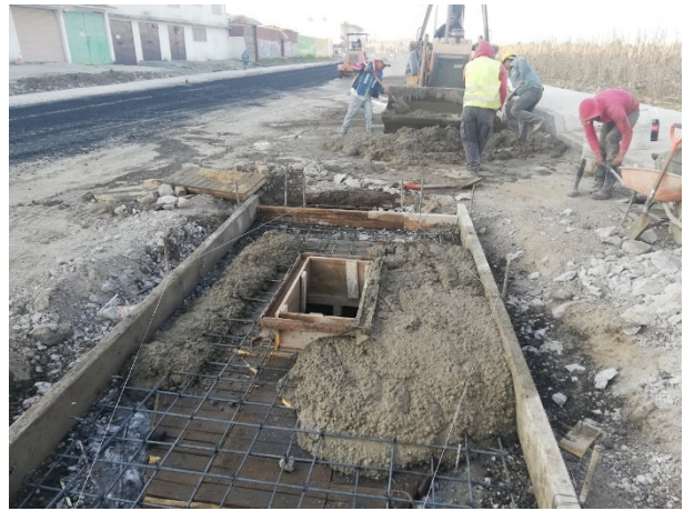
Foto 26, 27, 28 y 29. Proceso de demolición y reconstrucción de tapas de registros TELMEX. Fuente propia.
