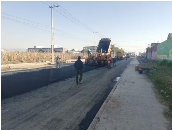
Foto 79. Colocación de carpeta asfáltica. Fuente propia.
