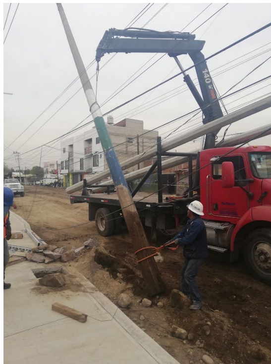
Foto 66. Retiro de postes viejos y colocación de nuevos. Fuente propia.
