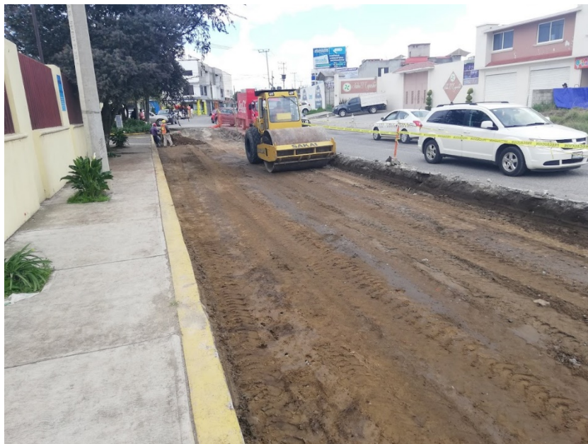
Foto 35. Comparación de terreno natural para recibir base. Fuente propia.
