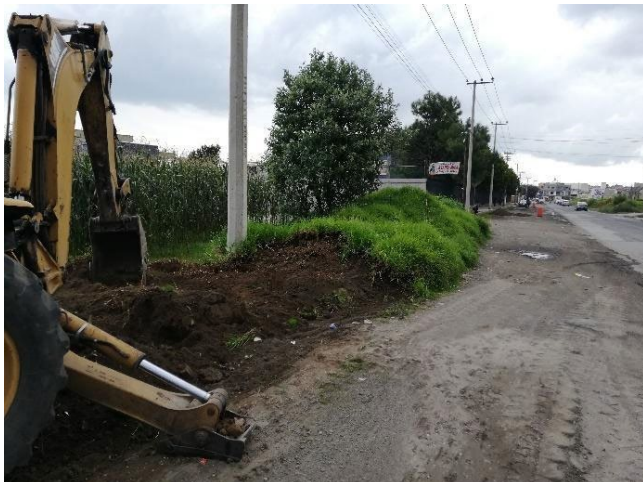
Foto 16 y 17. Despalme sobre hombros del proyecto. Fuente propia.
