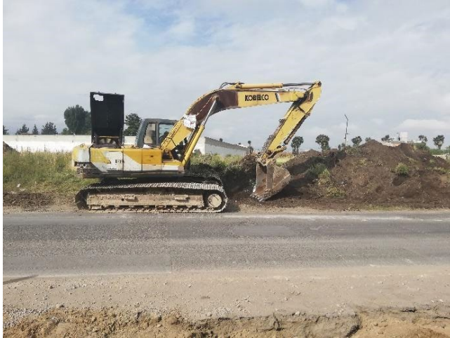
Foto 18 y 19. Despalme sobre hombros del proyecto. Fuente propia.
