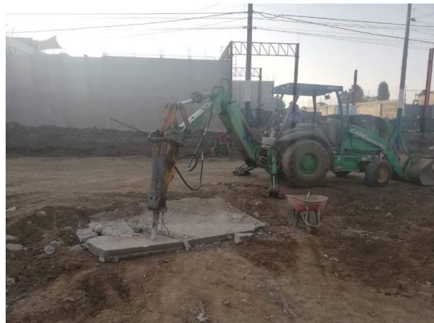
Foto 24 y 25. Identificación y demolición de tapas de registros TELMEX. Fuente propia.
