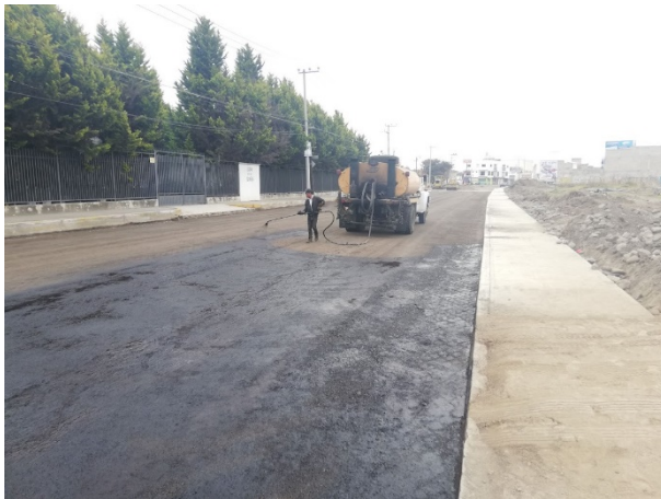
Foto 71. Colocación de riego de impregnación. Fuente propia.
