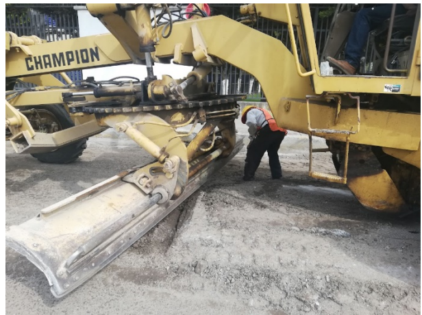
Foto 39. Corte de capa base. Fuente propia.
