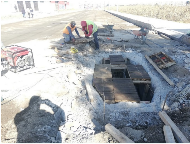
Foto 26, 27, 28 y 29. Proceso de demolición y reconstrucción de tapas de registros TELMEX. Fuente propia.
