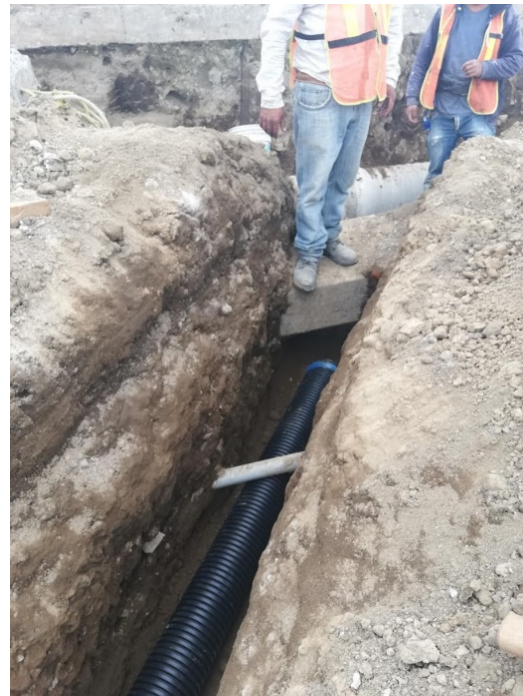
Foto 53 y 54. conexiones de tubo PAD. Fuente propia.
