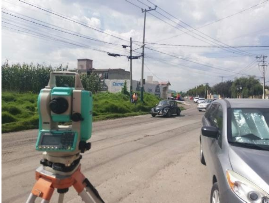
Foto 14. Verificación de trazo del proyecto de ampliación de la Av. Heriberto Enríquez. Fuente propia.
