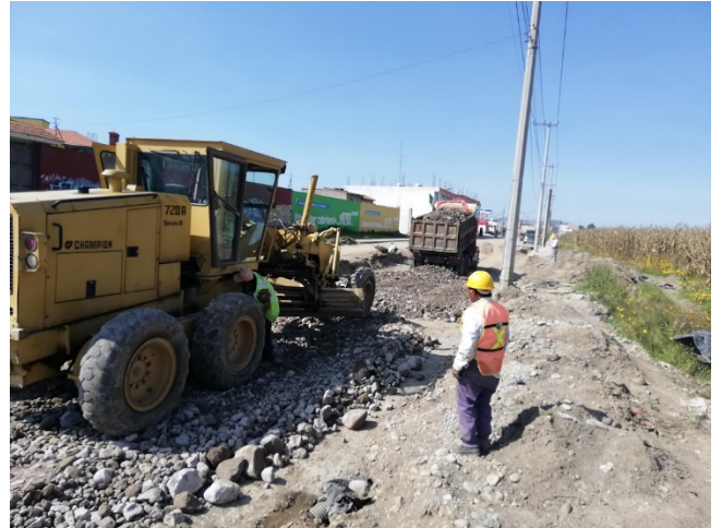
Foto 31 y 32. Tendido del pedraplén sobre el hombro izquierdo. Fuente propia.
