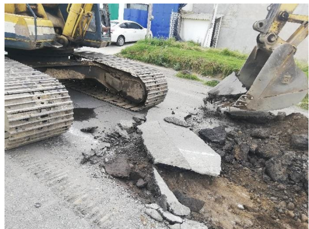
Foto 20 y 21. Demolición de carpeta existente. Fuente propia.
