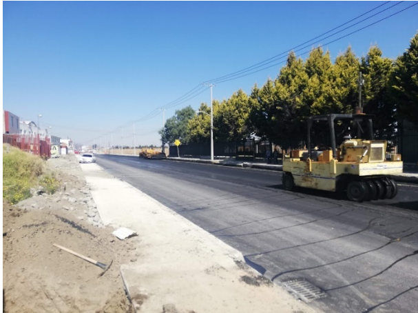
Foto 81. Compactación con neumático. Fuente propia.
