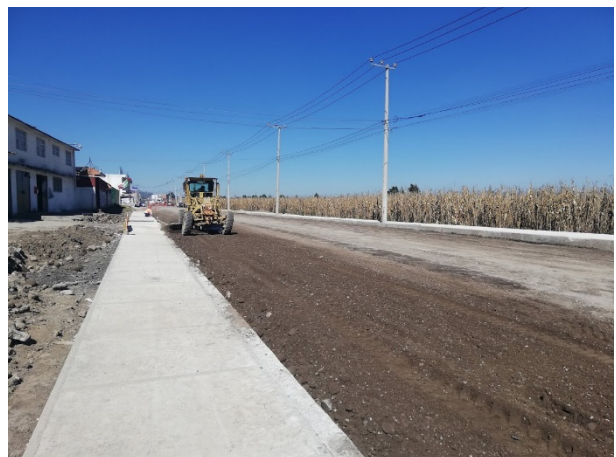
Foto 36 y 37. Conformación y Comparación de capa base. Fuente propia.
