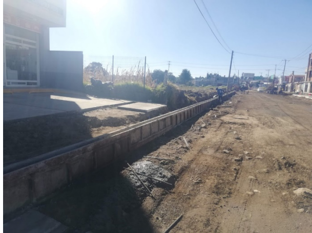
Foto 44 y 45. Colado de guarniciones con concreto premezclado. Fuente propia
