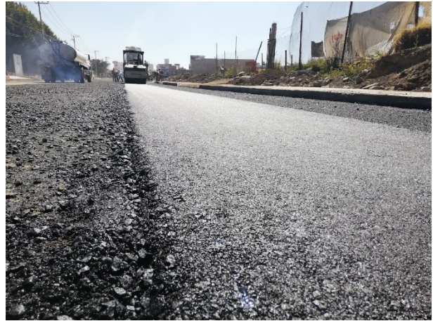
Foto 78. Compactación de carpeta asfáltica con tándem. Fuente propia.
