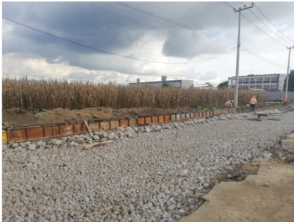
Foto 42. Cimbrado de guarniciones. Fuente propia.
