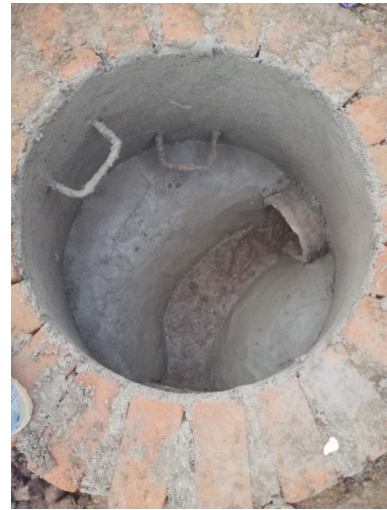
Foto 57 a la 58. Proceso de construcción de atarjeas. Fuente propia.
