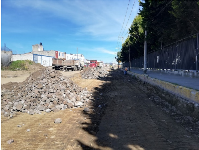
Foto 31 y 32. Tendido del pedraplén sobre el hombro izquierdo. Fuente propia.
