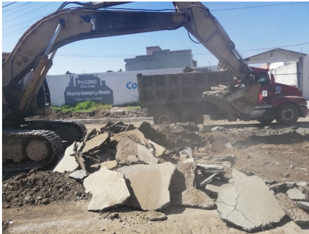
Foto 22 y 23. Demolición y carga de carpeta existente. Fuente propia.
