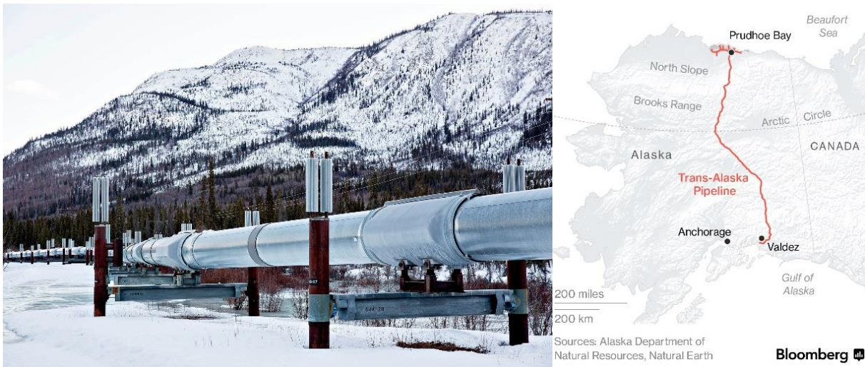
Figura 1.13 Ducto TranAlaska (Ojea, 2017).
