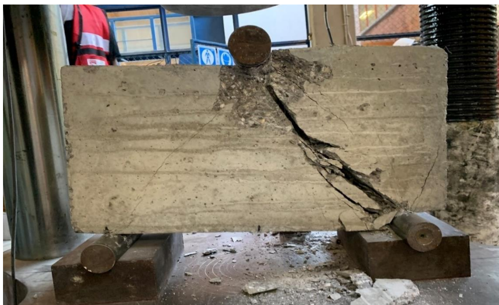
Figura 4. 156. – Viga V1-2614 después de llevarla a la falla con vista posterior.
