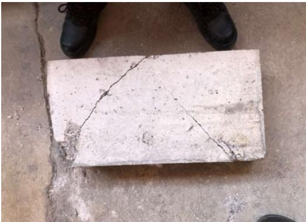
Figura 4. 48. - Viga V1-1709 después de llevarla a la falla vista en el suelo con falla por desconchamiento. Foto tomada por Bibian I. Silva.
