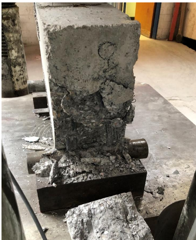
Figura 4. 56. - Detalle de primer agrietamiento de viga V1-1787.
