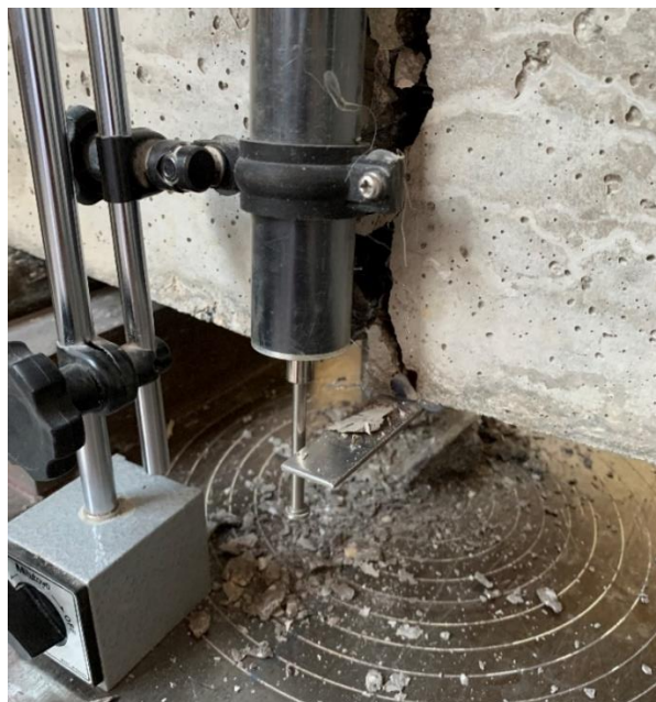
Figura 4. 165. – Detalle de falla de viga V2-2615 donde el transductor se deja de apoyar en la barra de donde se mide el desplazamiento, motivo por el que se paró la prueba.
