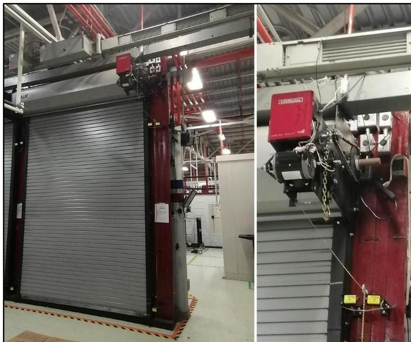
Figura 17. Vista frontal de puerta enrollable (izquierda) y abridor actual GH101 L5
