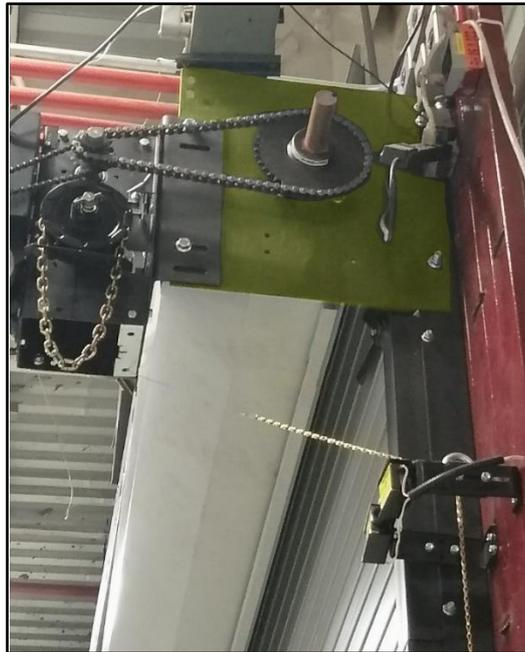
Figura 20. Placa de montaje de la puerta enrollable (resaltada en color amarillo)
