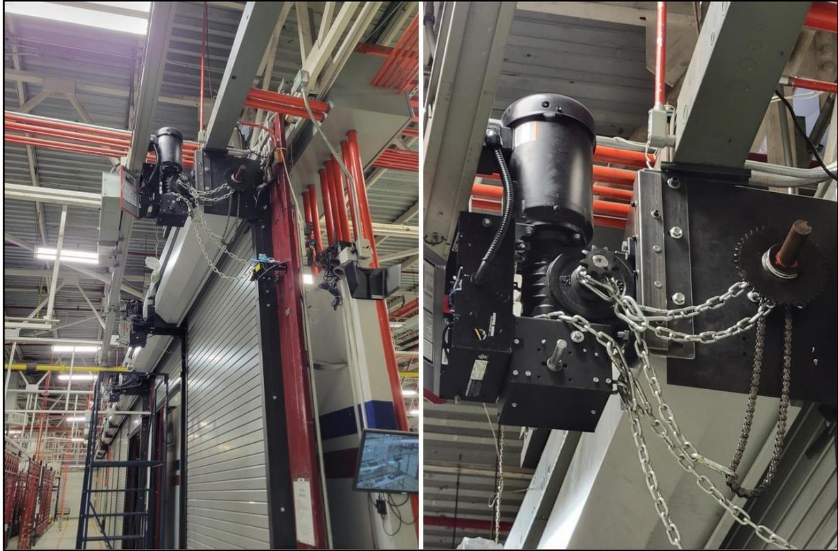
Figura 51. Bracket diseñado con abridor GH303 montado (cadena aún no ha sido tensada)
