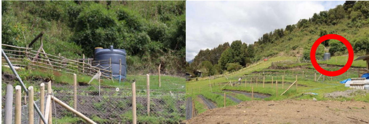
Figura 19. Ubicación de la cisterna en el punto de mayor elevación del predio.
