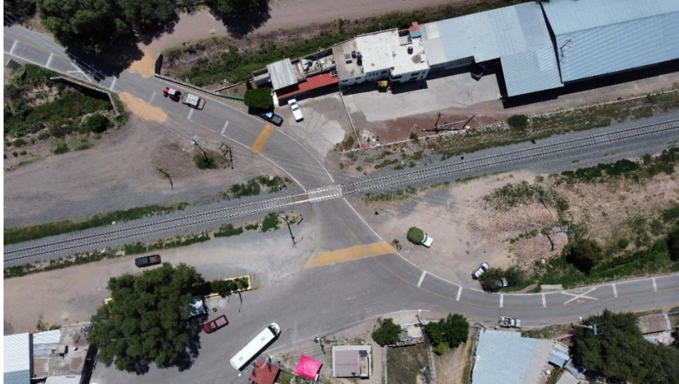
Figura 20 – Cruce a nivel en el km 224+450 de la línea B.
