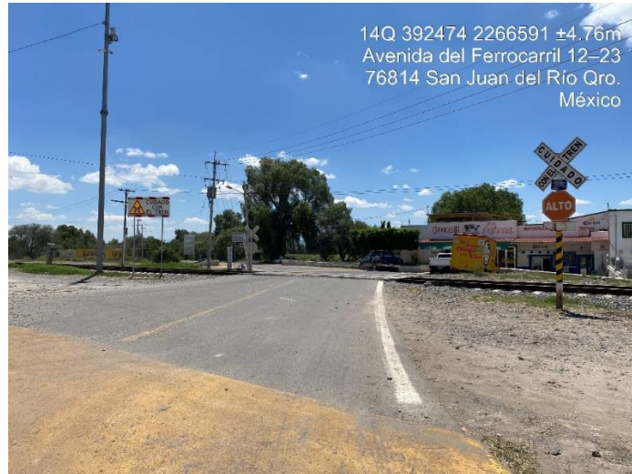
Figura 32 – Vista panorámica del cruce a nivel.
