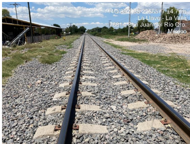
Figura 30 – Vista longitudinal de la vía férrea.
