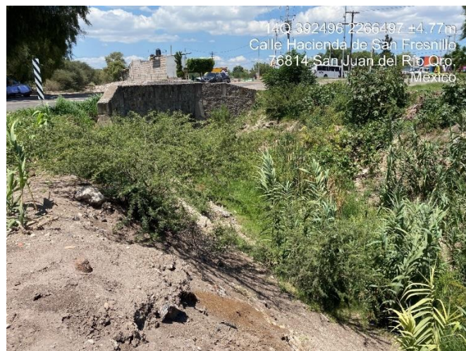
Figura 31 – Alcantarilla del tipo losa azolvada, paralela al trazo de la vía férrea.
