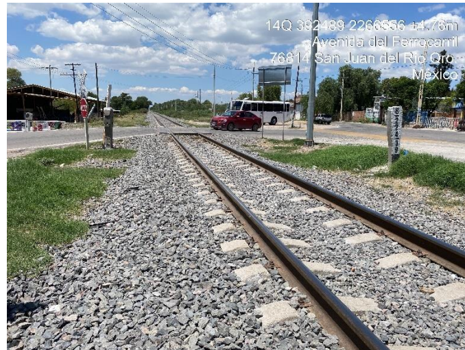
Figura 24 – Vista del cruce a nivel en el km 224+450 de la línea B.
