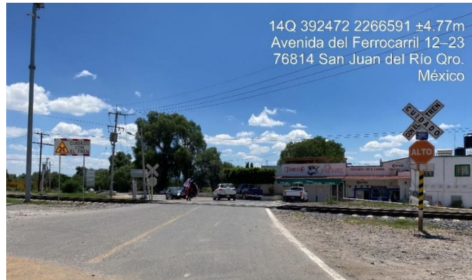
Figura 23 - Vista del cruce a nivel en el km 224+450 de la línea B.
