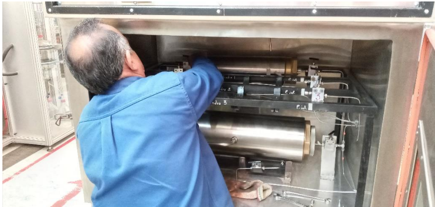
Figura 68 Maniobra para apretar conexiones de válvulas dentro del horno
