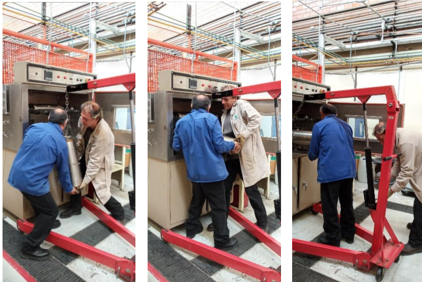
Figura 15 Maniobra de montaje del core holder al interior del horno
