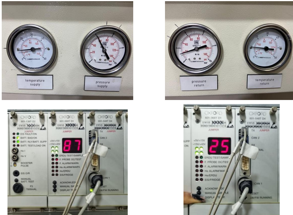
Figura 32 Verificación de parámetros de la Resonancia Magnética
