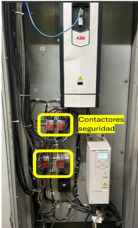
Imagen 3.36. Variador velocidad contra cuchillas y extractor de tiras. Fuente. elaboración propia
