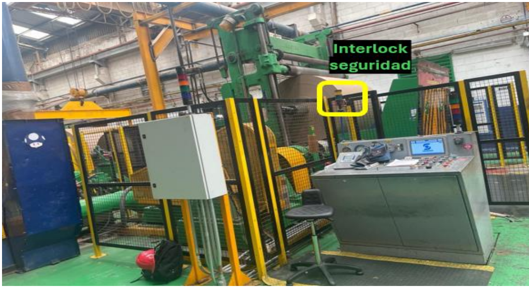
Imagen 3.33. Guarda de seguridades, interlock en zona 3. Fuente. elaboración propia
