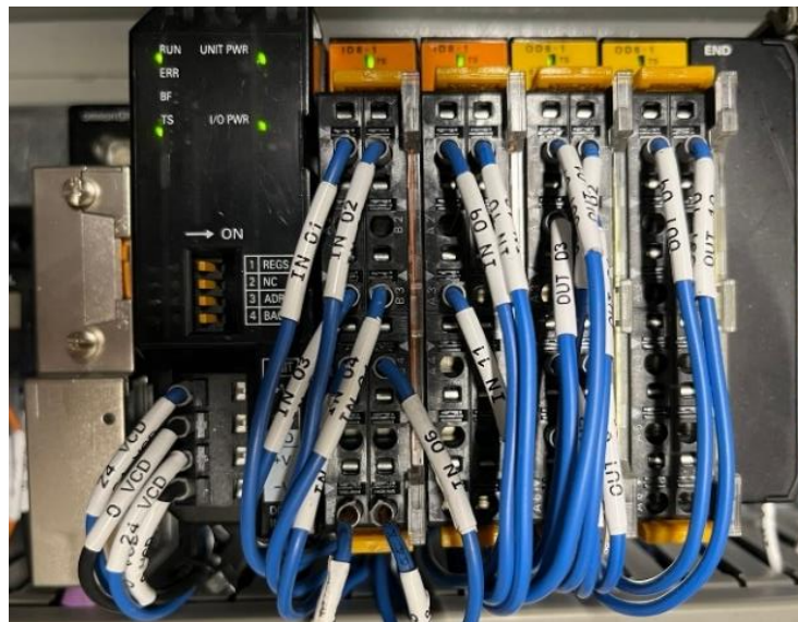
Imagen 2.24. Tarjetas E/S remotas (1 y 2). Fuente. elaboración propia
