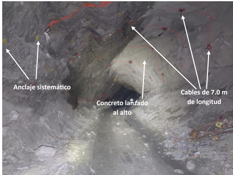
Ilustración 6: Sección de rebaje 540C, el cual posee los 3 tipos de soporte, anclaje sistemático primario, concreto lanzado al alto y cables de 7.0m de longitud a lo largo de la obra. Rebaje explotado con un sistema de corte y relleno ascendente. Imagen propia.
